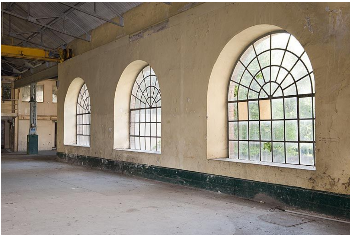
Salle des turbines. Détail des baies de la façade ouest.
