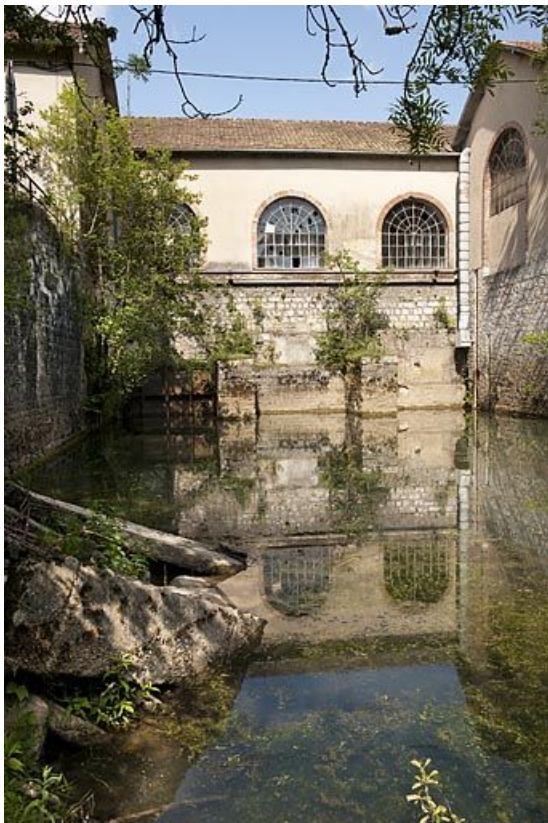
Mur oriental de la salle des turbines et canal de fuite.
