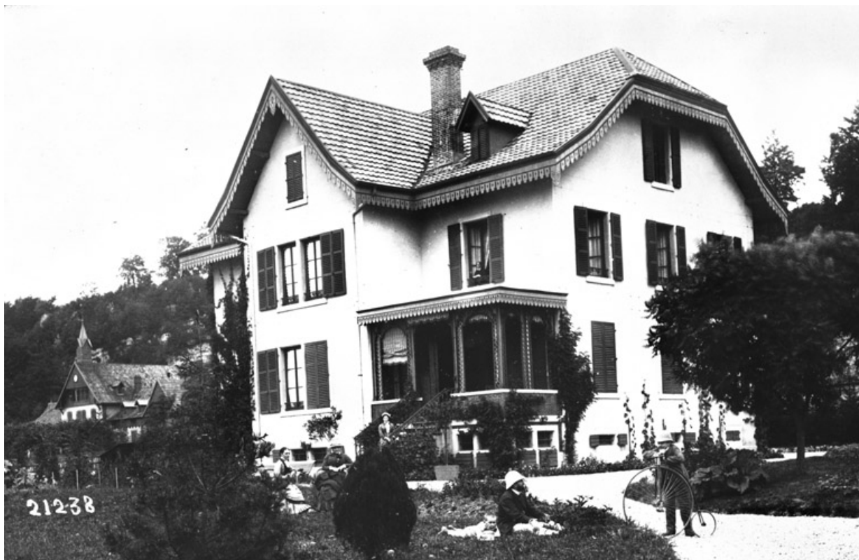
Vue d'ensemble depuis le jardin.
