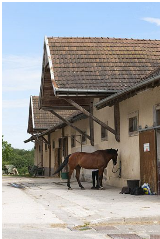
Ancienne étable. Vue de trois quarts.
