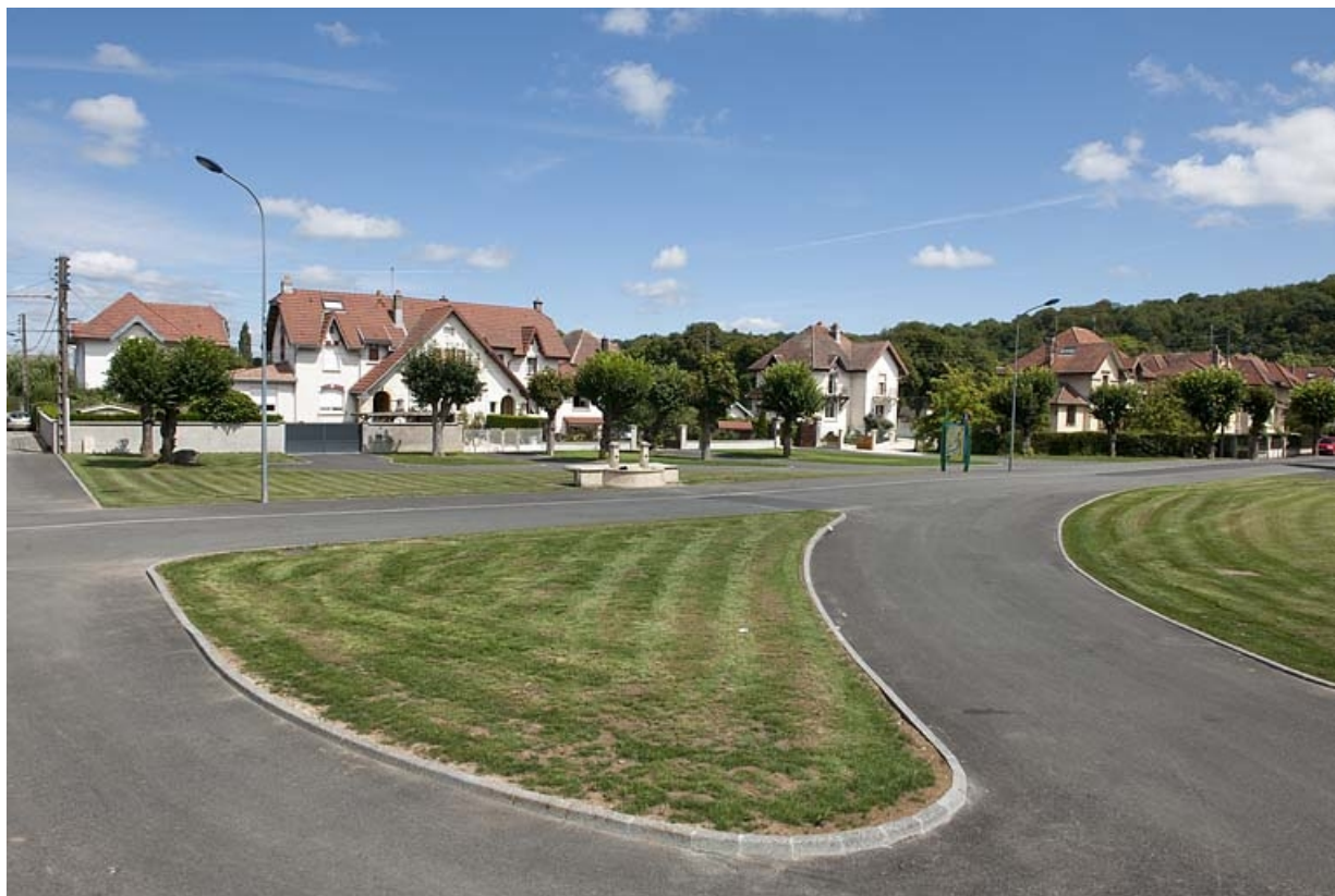
Vue d'ensemble depuis l'avenue Frédéric Bataille.
