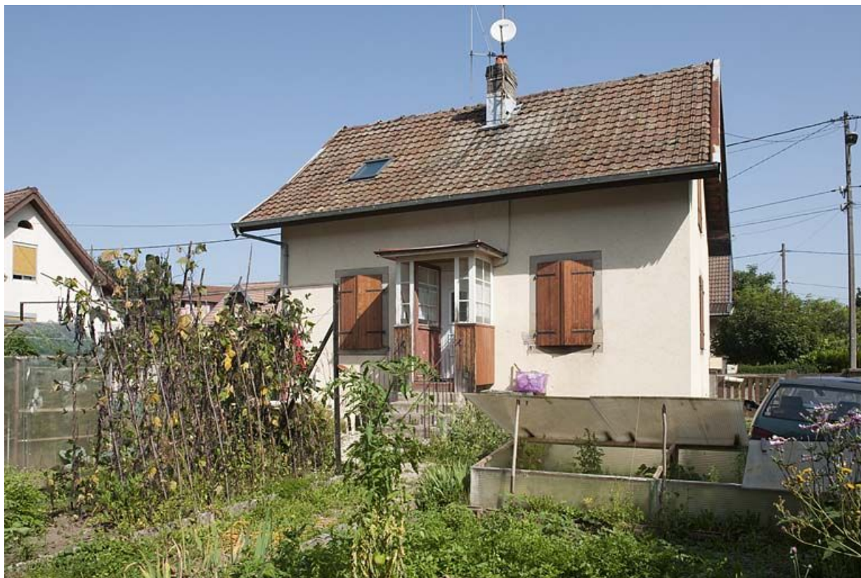
Maison individuelle rue des Lesses. Façade postérieure.
