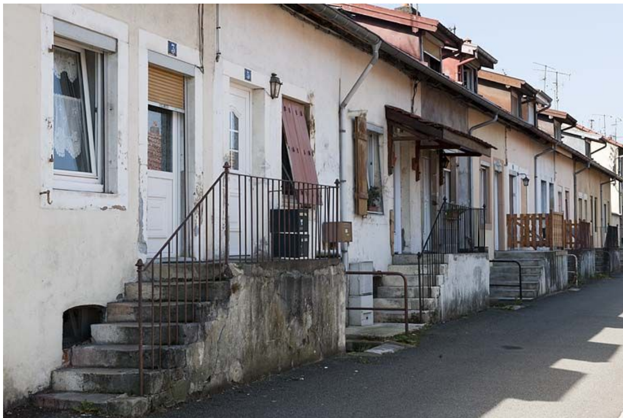
Façade nord sur la rue des Cités.
