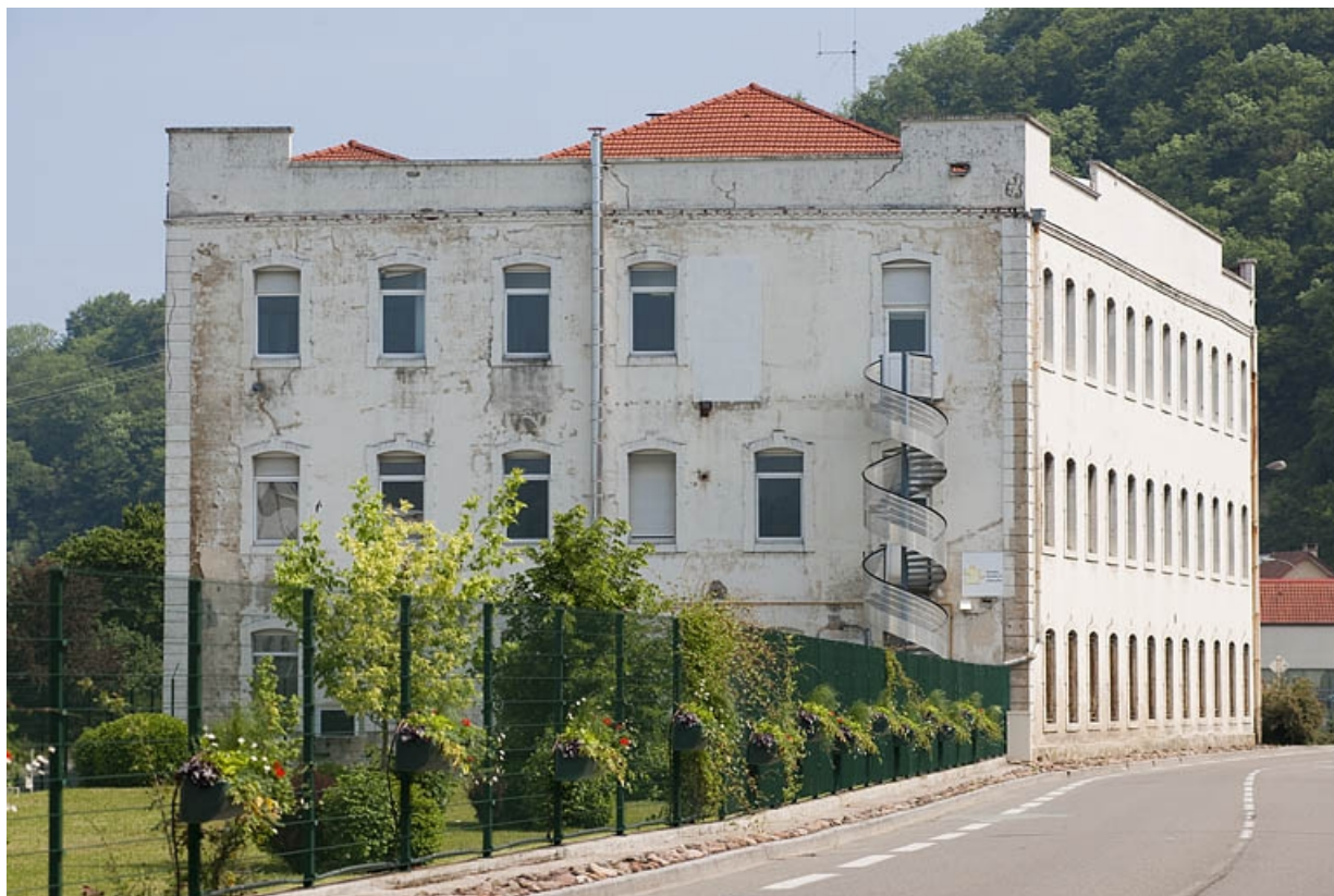
Immeuble de bureaux. Vue depuis le sud.
