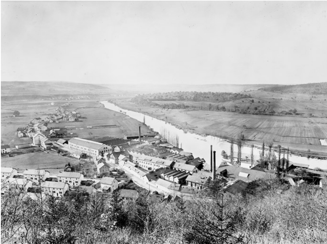
Vue plongeante depuis le nord-est. Partie amont de l'usine.
