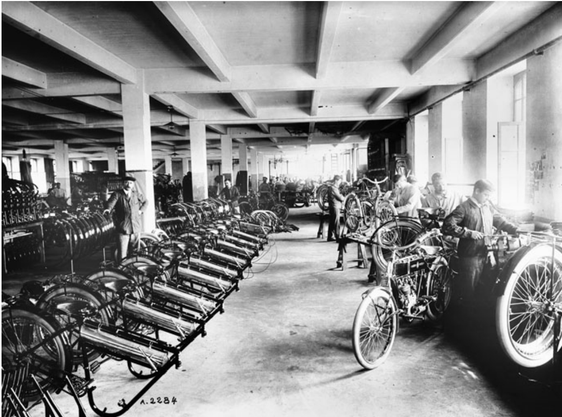
Atelier de montage des motocyclettes.
