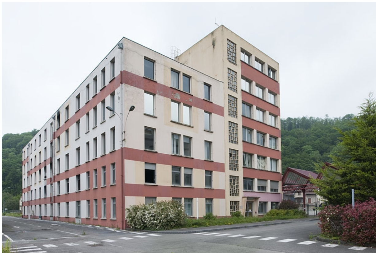
Bâtiment administratif. Vue depuis l'ouest.
