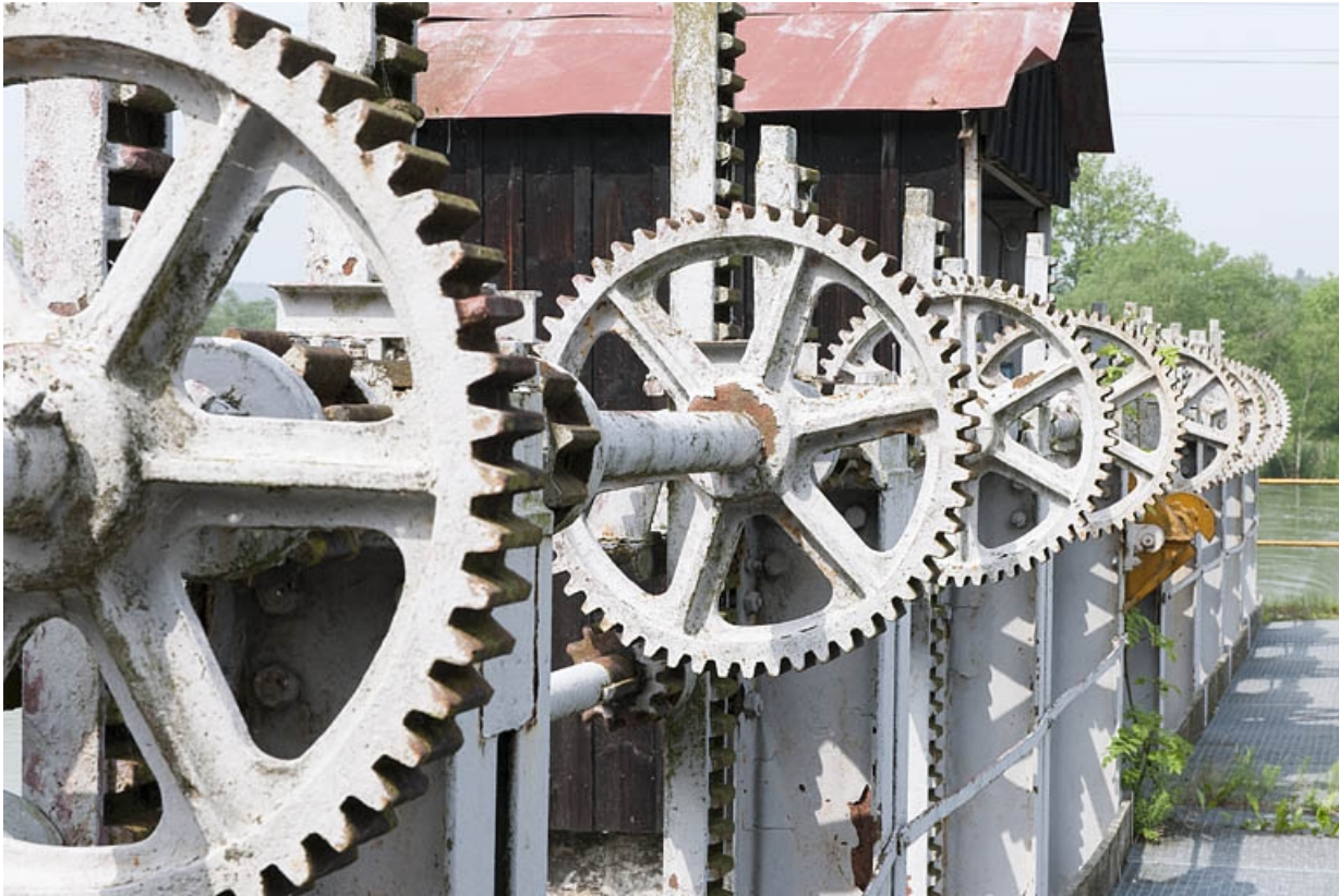
Vannage du barrage. Détail des engrenages.
