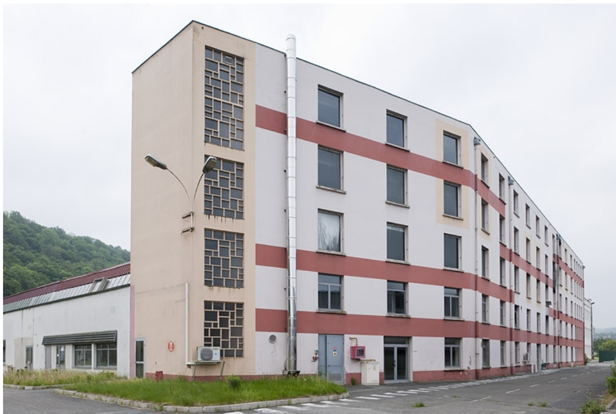
Bâtiment administratif. Façade nord-ouest.
