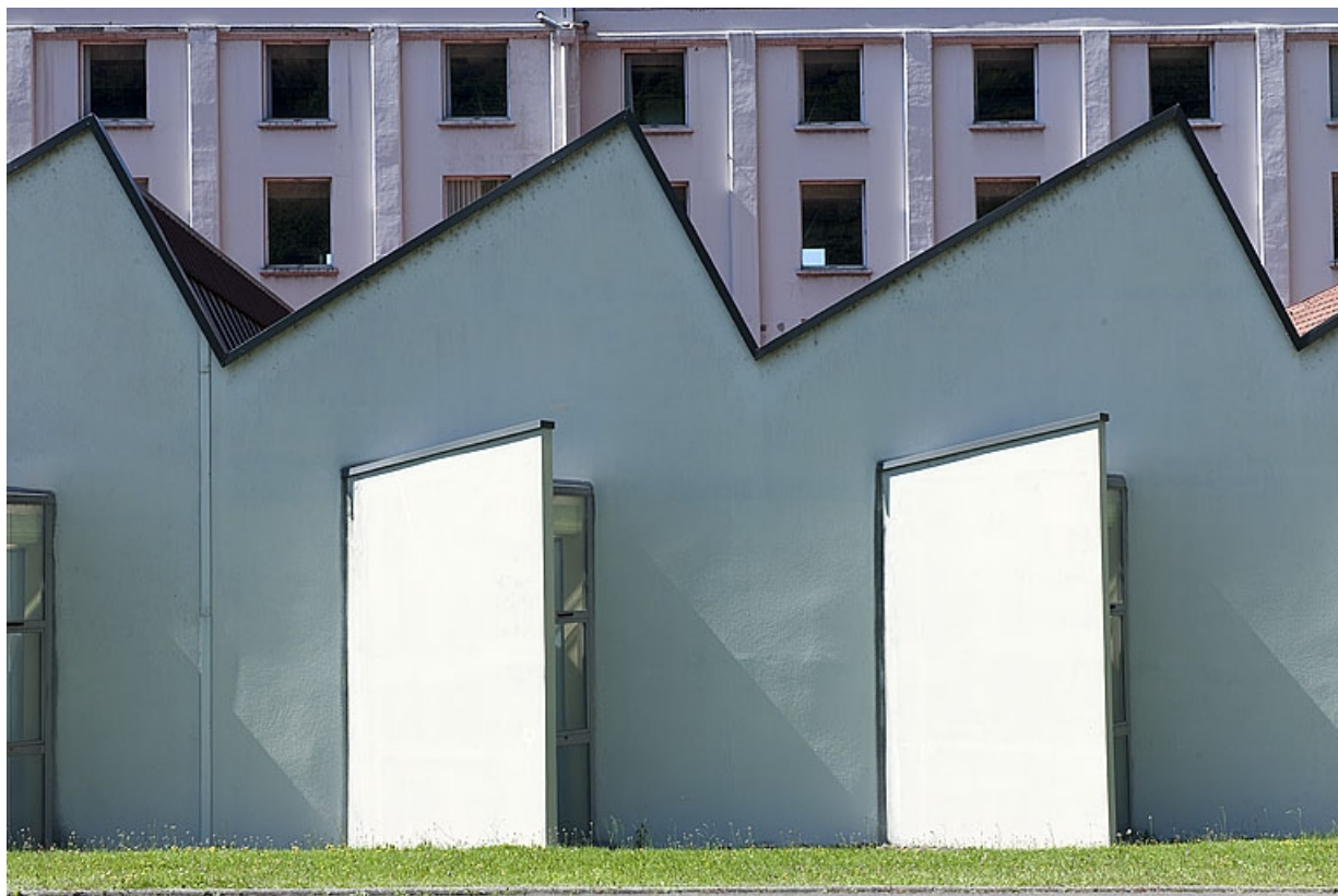
Atelier de fabrication en rez-de-chaussée. Détail des pignons des sheds.
