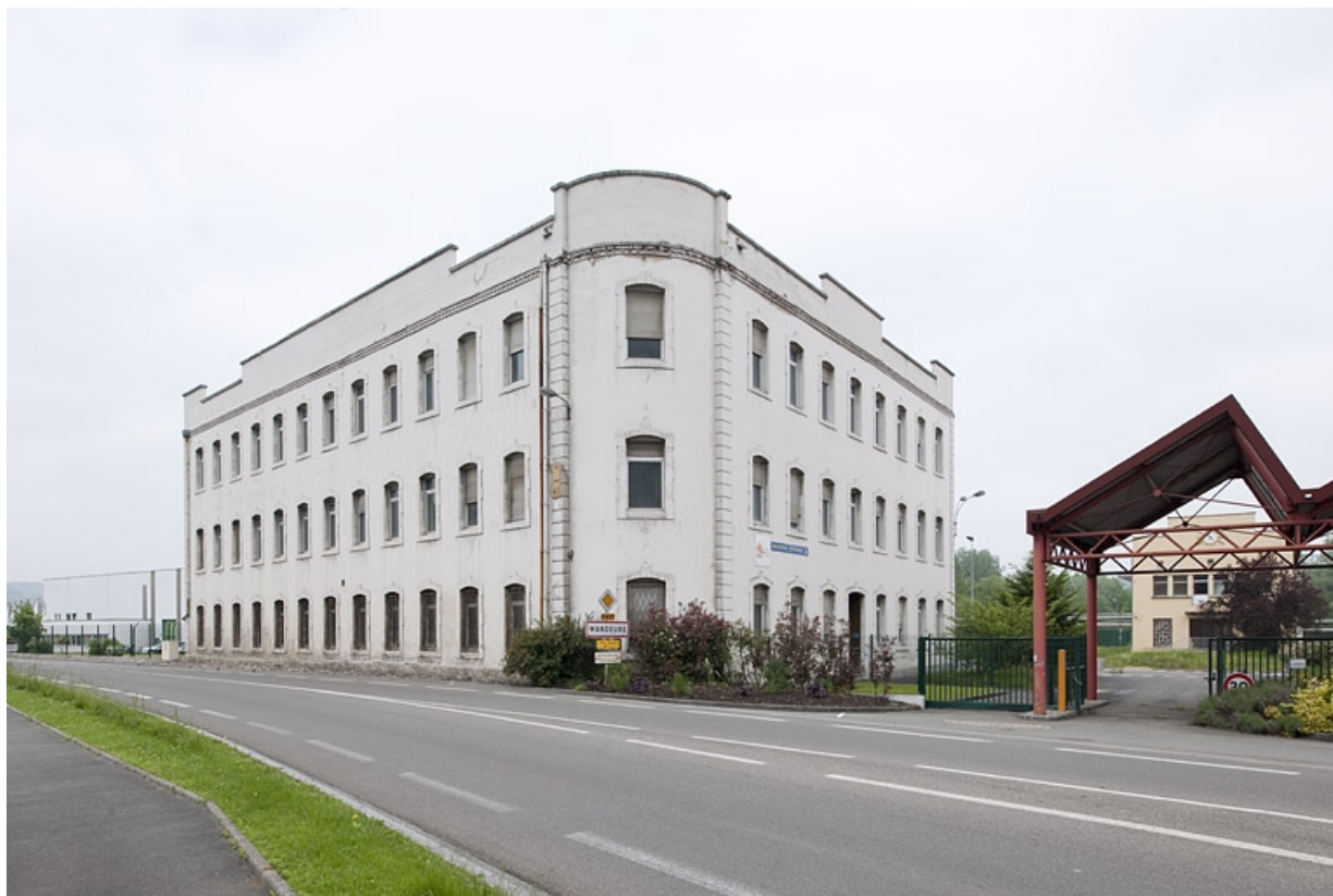
Immeuble de bureaux situé au sud de l'entrée.
