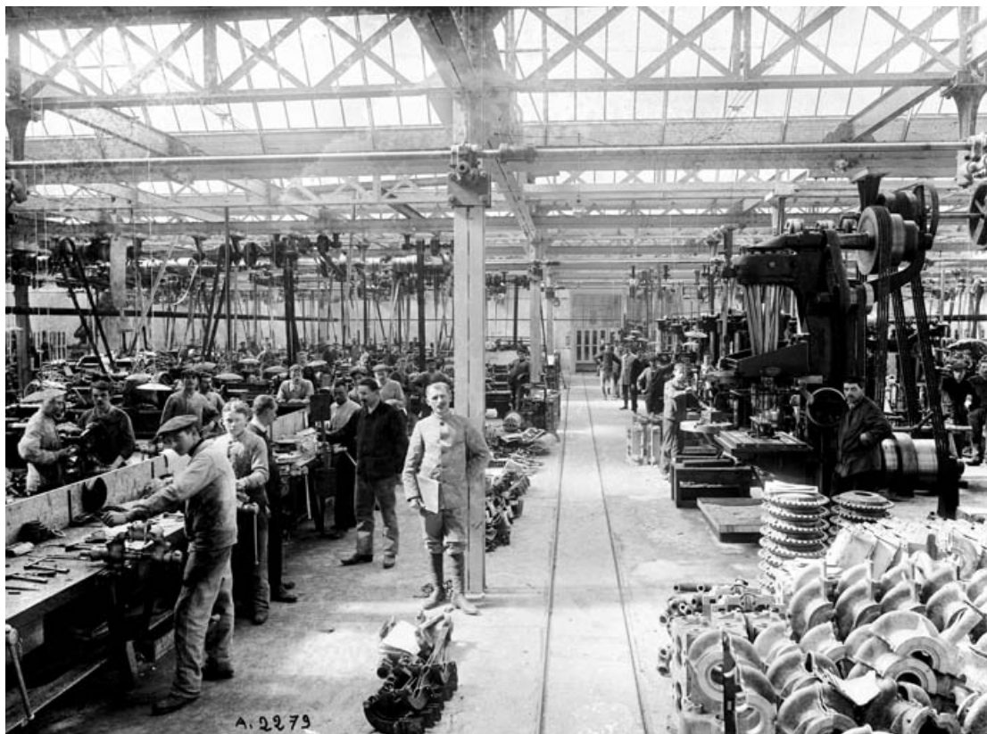
Intérieur d'atelier. Usine de Beaulieu (?).
