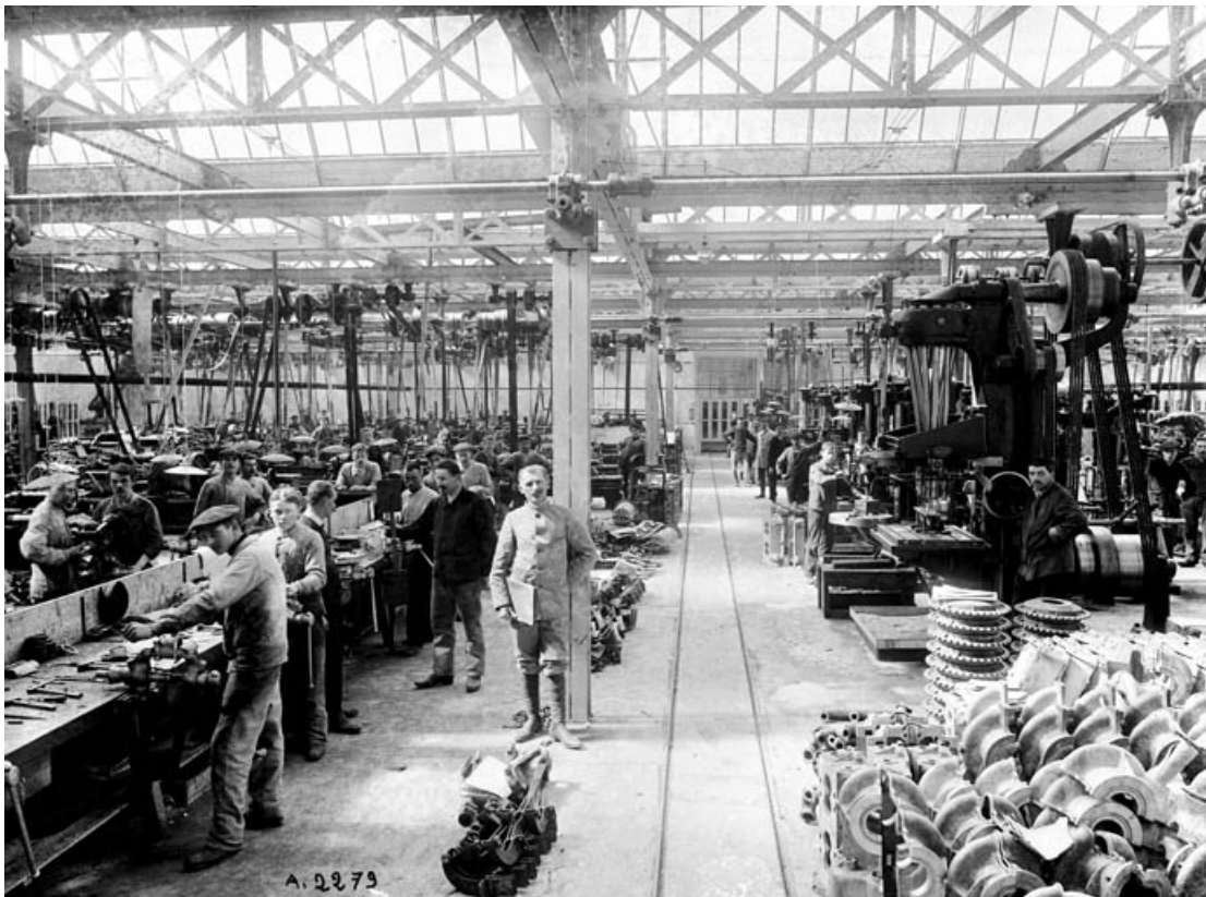
Intérieur d'atelier. Usine de Beaulieu (?).
