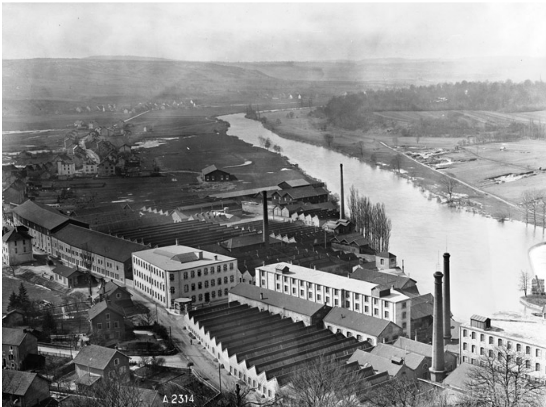
Vue plongeante sur la partie amont de l'usine.
