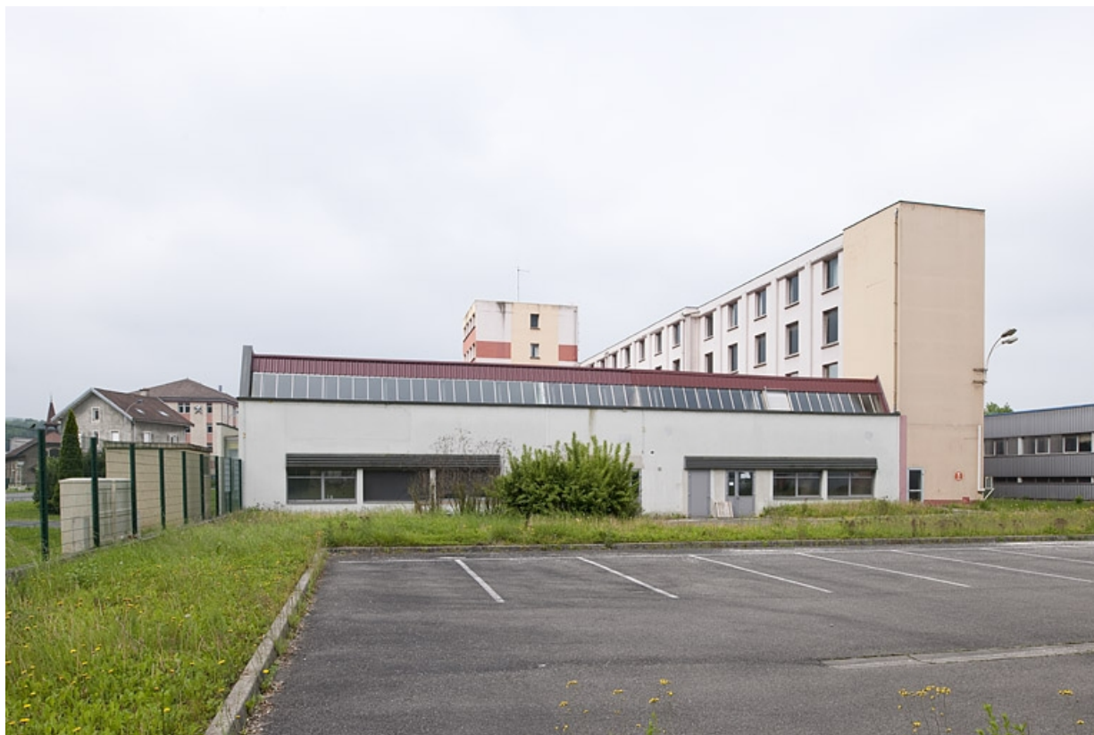
Atelier de fabrication et bâtiment administratif depuis le nord-est.
