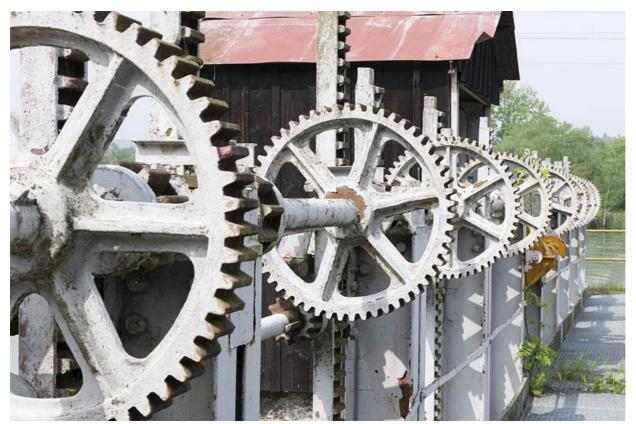
Vannage du barrage. Détail des engrenages.
