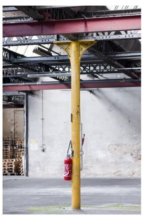
Colonne en fonte et charpente métallique.
