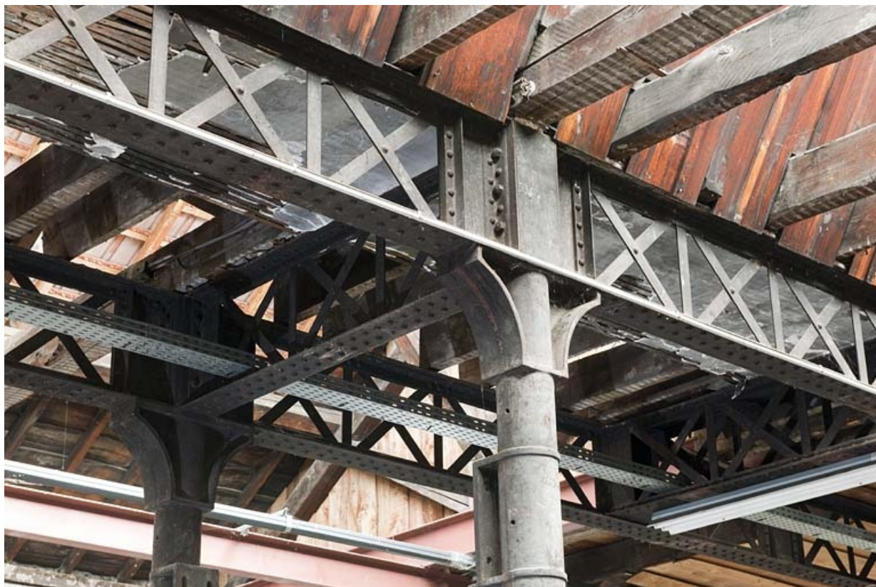
Ossature mixte : colonne, poutrelles à treillis et charpente en bois.
