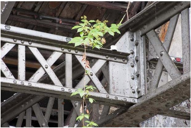
Détail de poutrelles à treillis.
