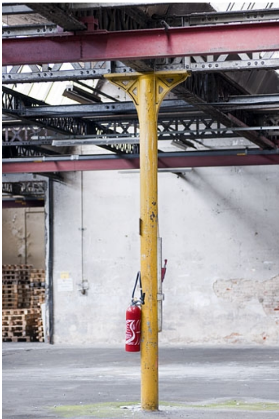
Colonne en fonte et charpente métallique.
