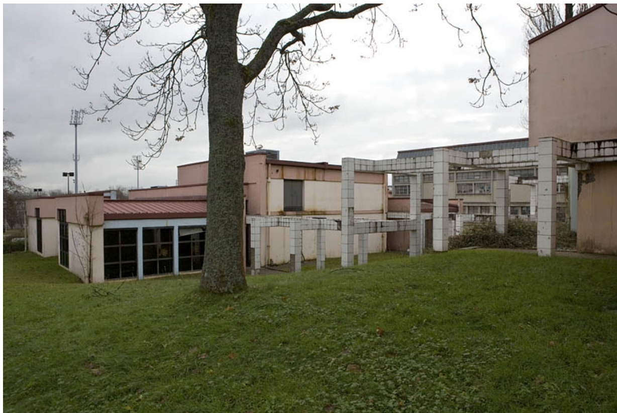
Vue de trois quarts gauche bâtiment J. 25, Montbéliard, 1 B rue Pierre Donzelot
