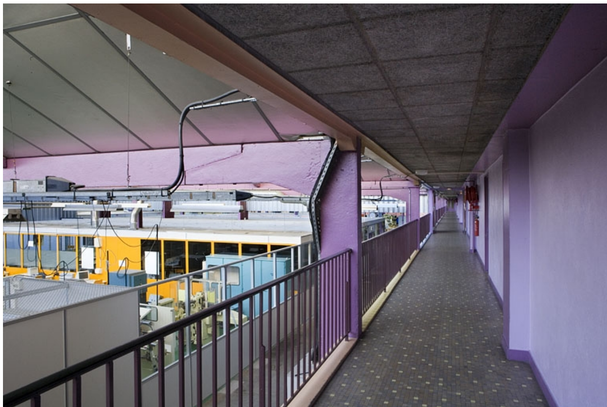
Bâtiment B. Atelier section technologique. Vue passerelle.
