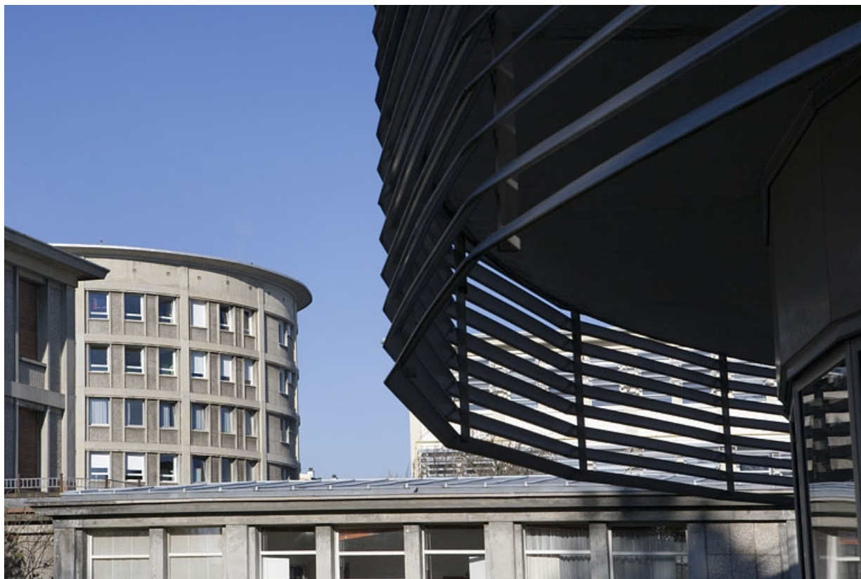
Détail architecture aile gauche bâtiment L. 25, Montbéliard, 1 B rue Pierre Donzelot
