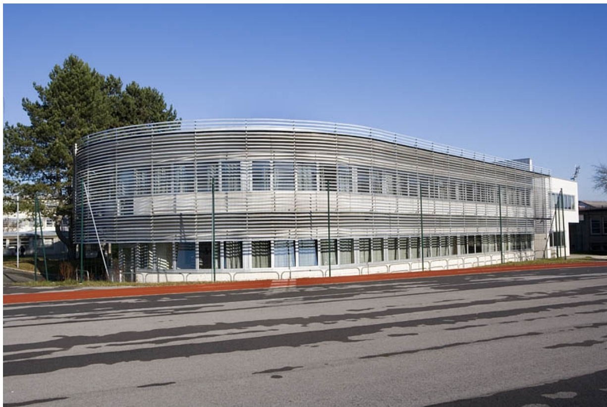
Vue de l'aile droite bâtiment L.
