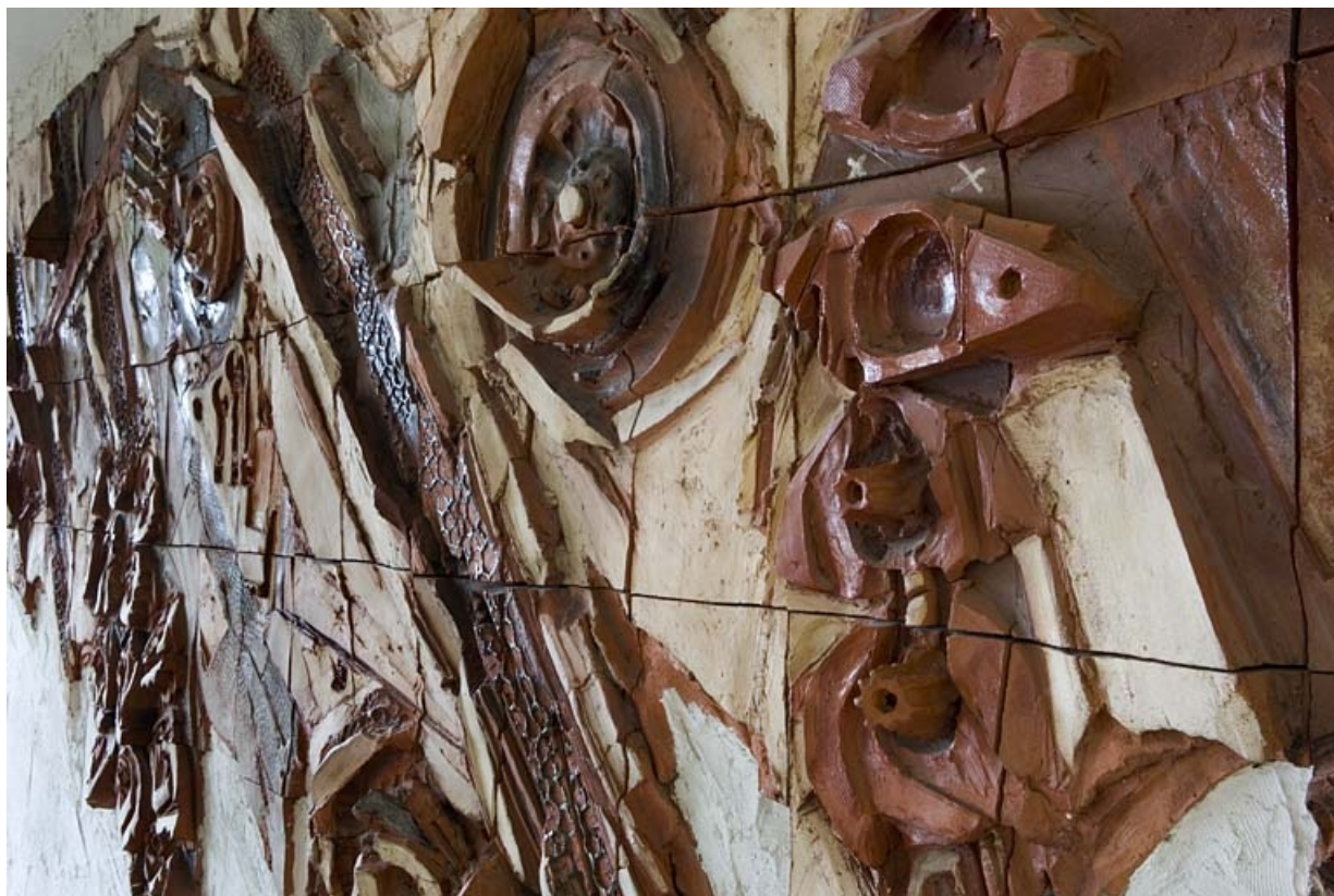
Bâtiment D. Détail haut-relief de Martine Planchat.
