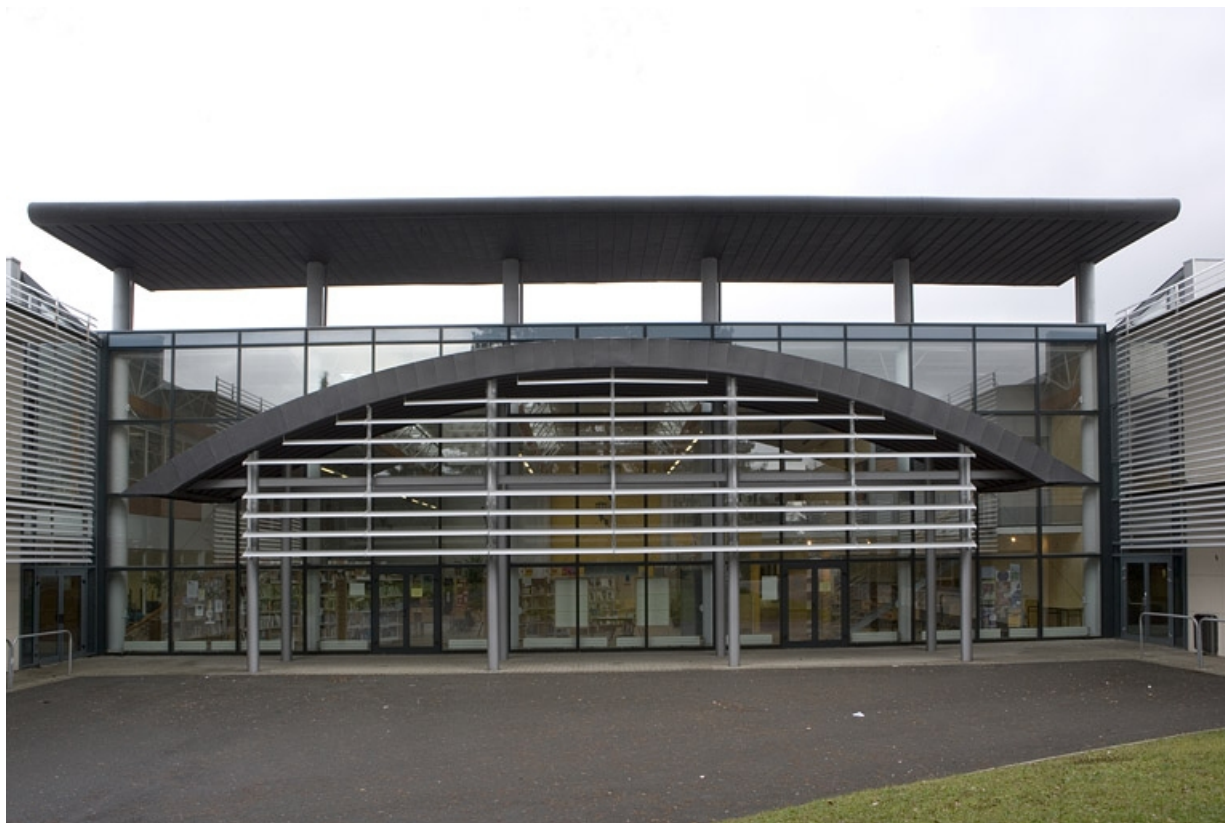
Vue façade antérieure bâtiment L.
