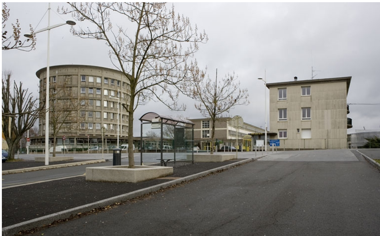
Vue d'ensemble côté entrée.
