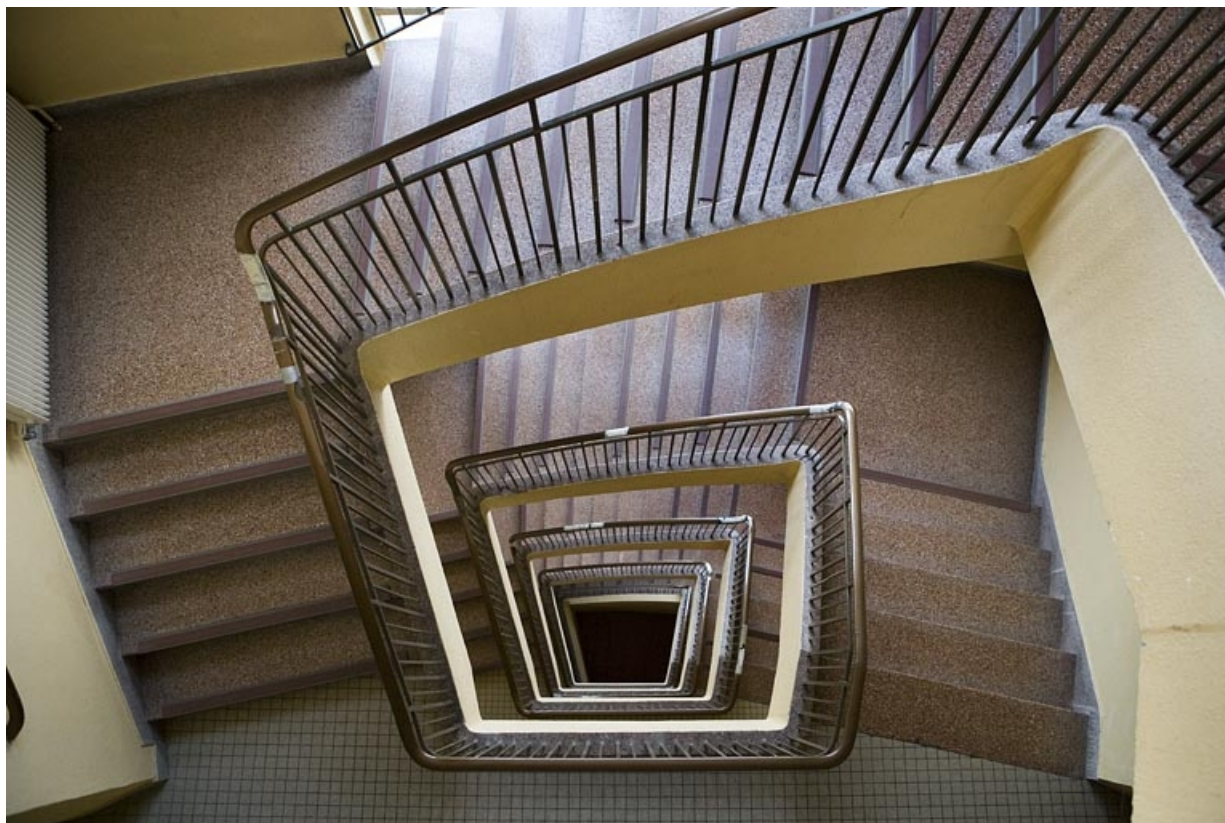
Bâtiment D : internat. Vue plongeante de l'escalier.
