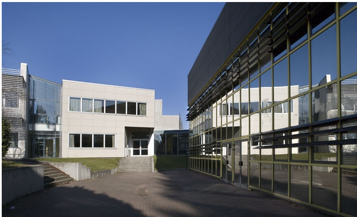
Vue de la façade antérieure bâtiment B.
