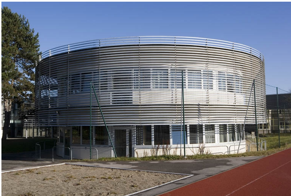
Vue de l'aile droite bâtiment L. Détail. 25, Montbéliard, 1 B rue Pierre Donzelot
