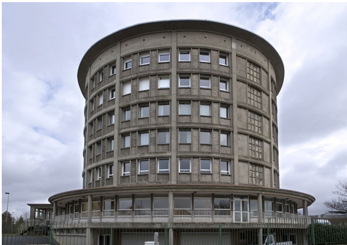
Bâtiment D. Vue de la tour d'internat.
