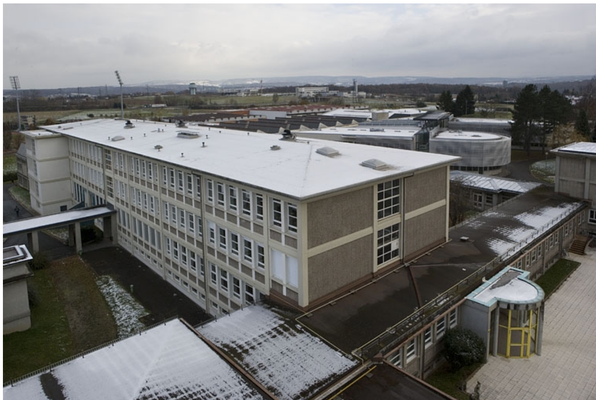
Vue d'ensemble depuis la tour d'internat.
