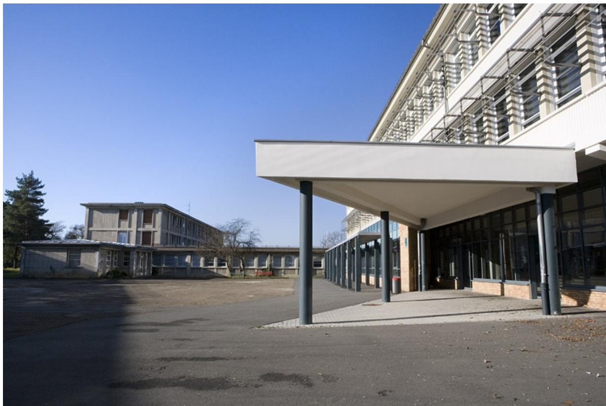
Vue façade antérieure bâtiment A et façade postérieure bâtiment C. 25, Montbéliard, 1 B rue Pierre Donzelot
