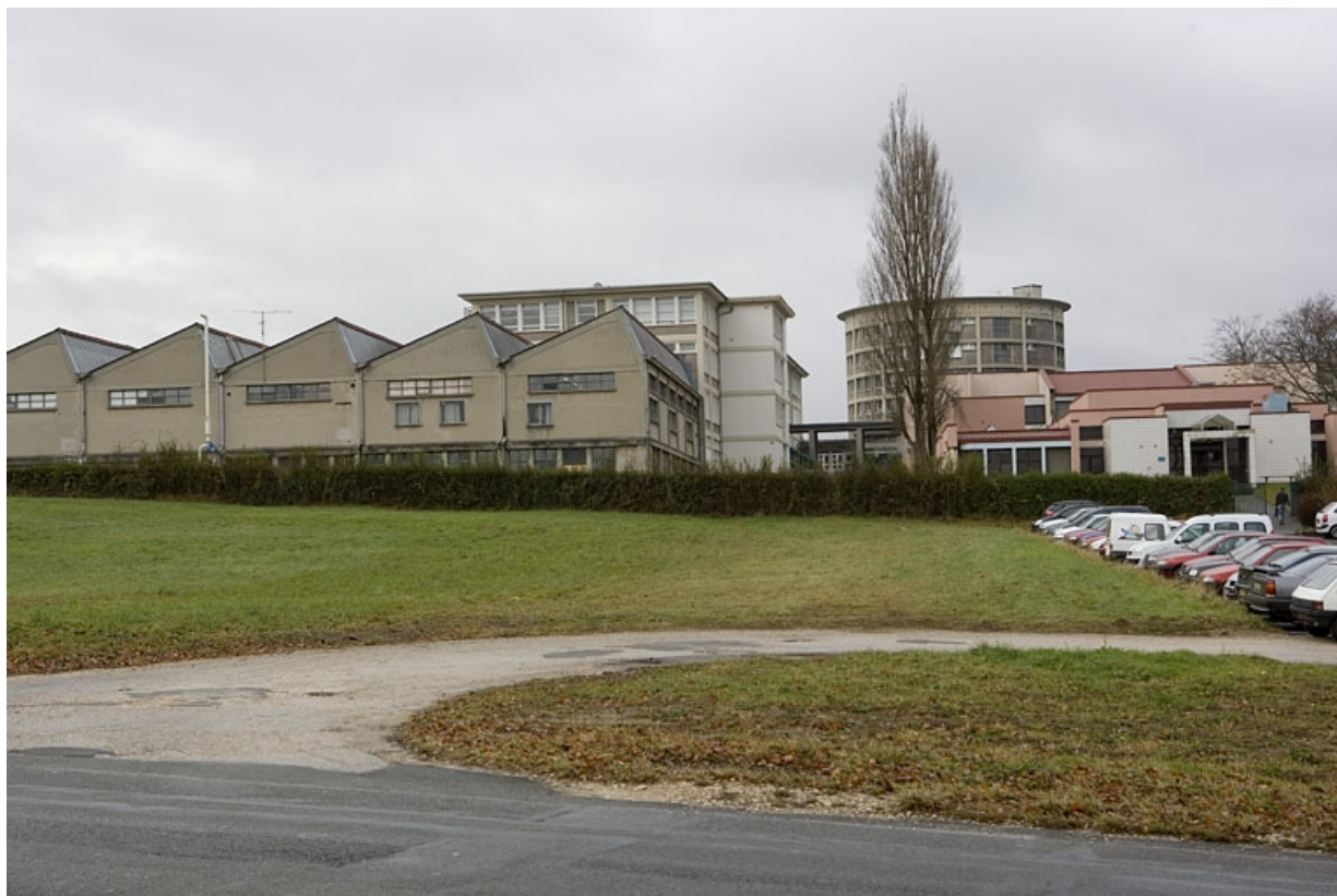
Vue d'ensemble. Façade postérieure du bâtiment B.
