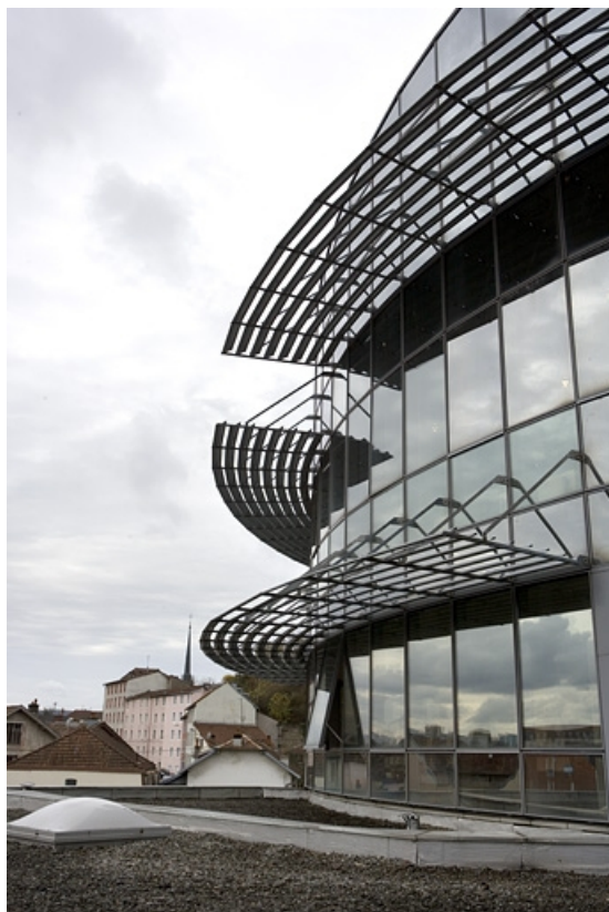
Tour bâtiment D. Détail brise-soleil métalliques.
