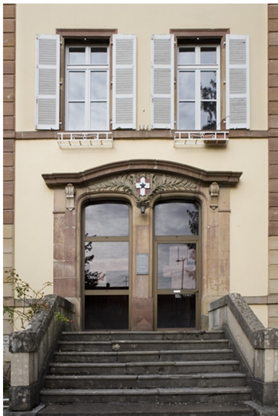
Vue façade antérieure bâtiment A : perron et porte d'entrée.
