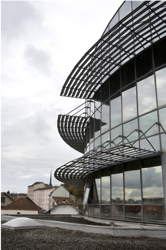
Tour bâtiment D. Détail brise-soleil métalliques.
