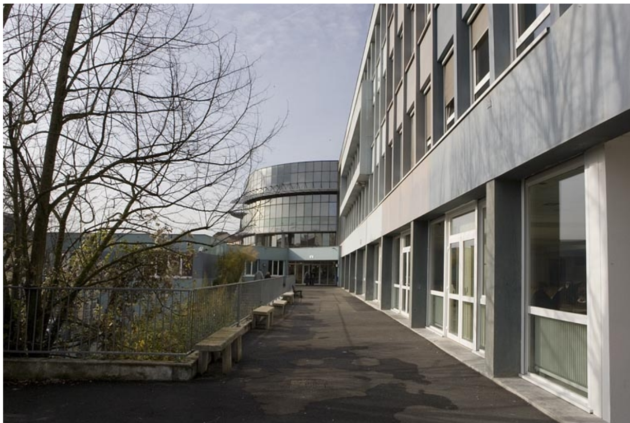
Vue latérale façade antérieure bâtiment C et tour bâtiment D.
