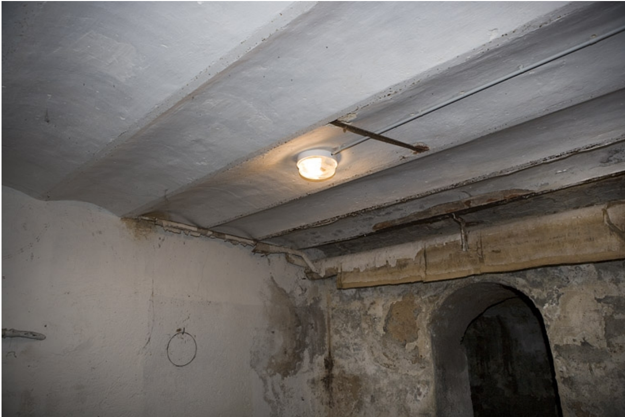
Bâtiment A : sous-sol. Détail voûtains.
