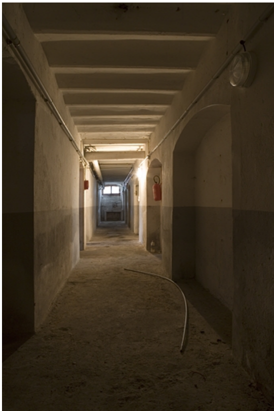
Bâtiment A : sous-sol. Vue du couloir.
