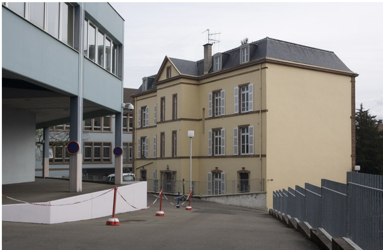
Vue extérieure bâtiment A trois quarts droit. 25, Montbéliard, 8 avenue de Lattre de Tassigny
