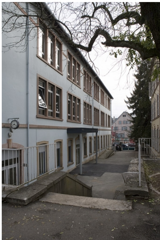
Bâtiment B. Vue face latérale droite.
