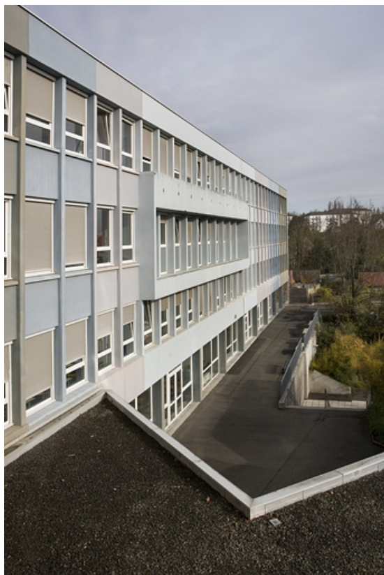
Vue extérieure façade antérieure bâtiment C depuis toit bâtiment D. 25, Montbéliard, 8 avenue de Lattre de Tassigny
