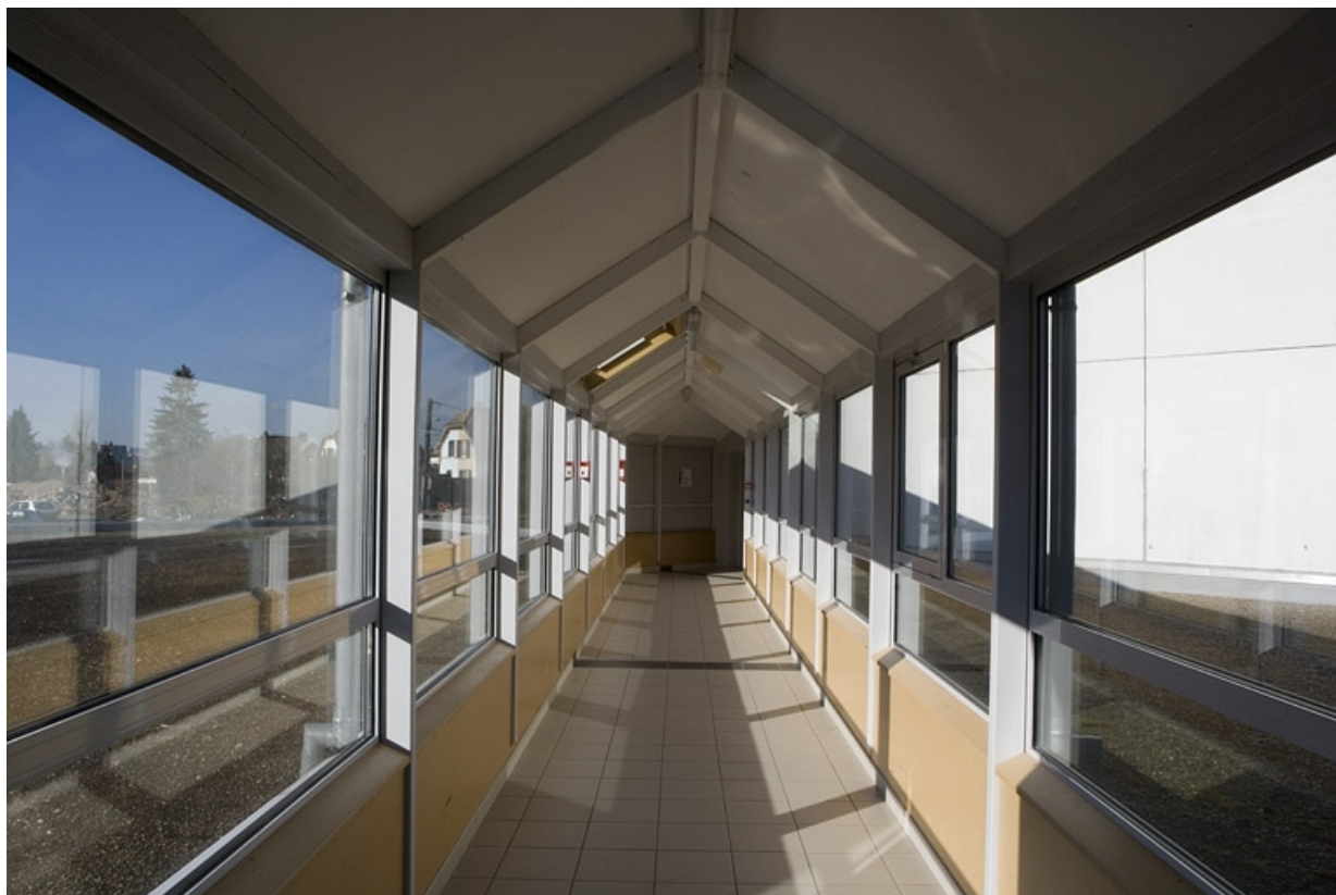
Vue de la passerelle entre les bâtiments A et D. 25, Montbéliard rue Pierre Donzelot
