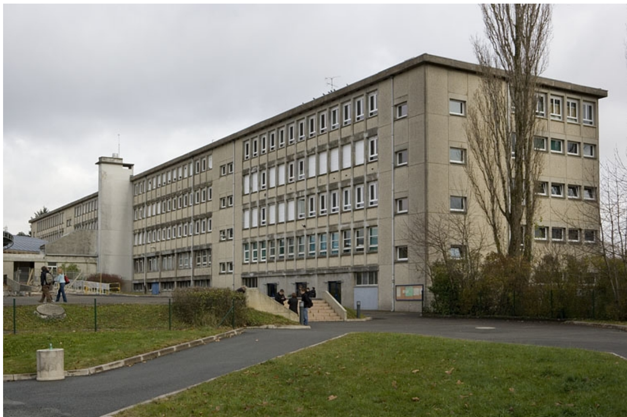
Bâtiment A. Vue de trois quarts droit du bâtiment d'externat.
