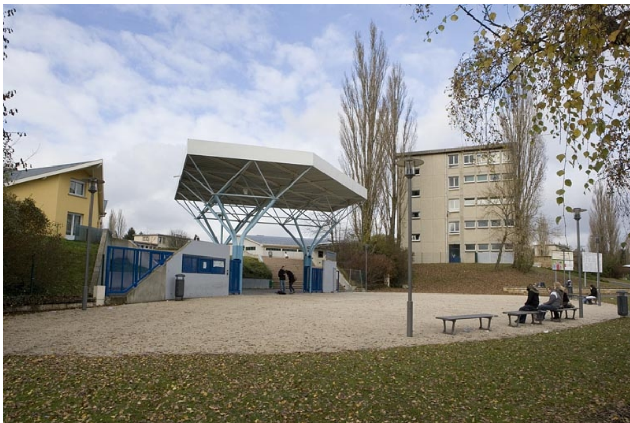
Vue de la nouvelle entrée.
