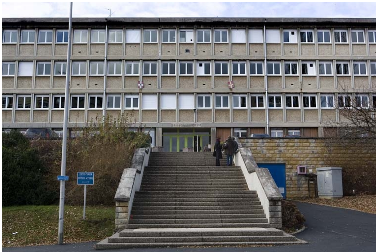
Façade postérieure du bâtiment A. Vue de l'ancienne entrée.
