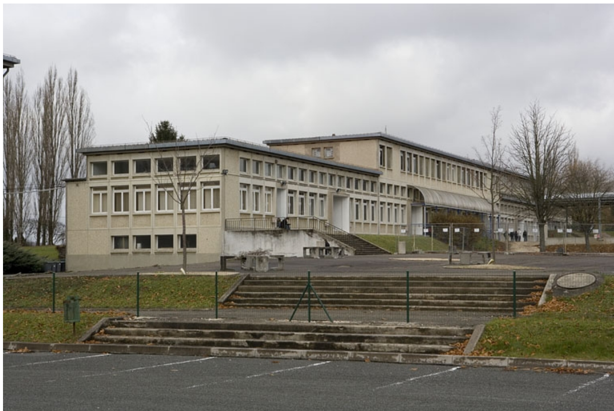
Vue de trois quarts gauche du bâtiment B.
