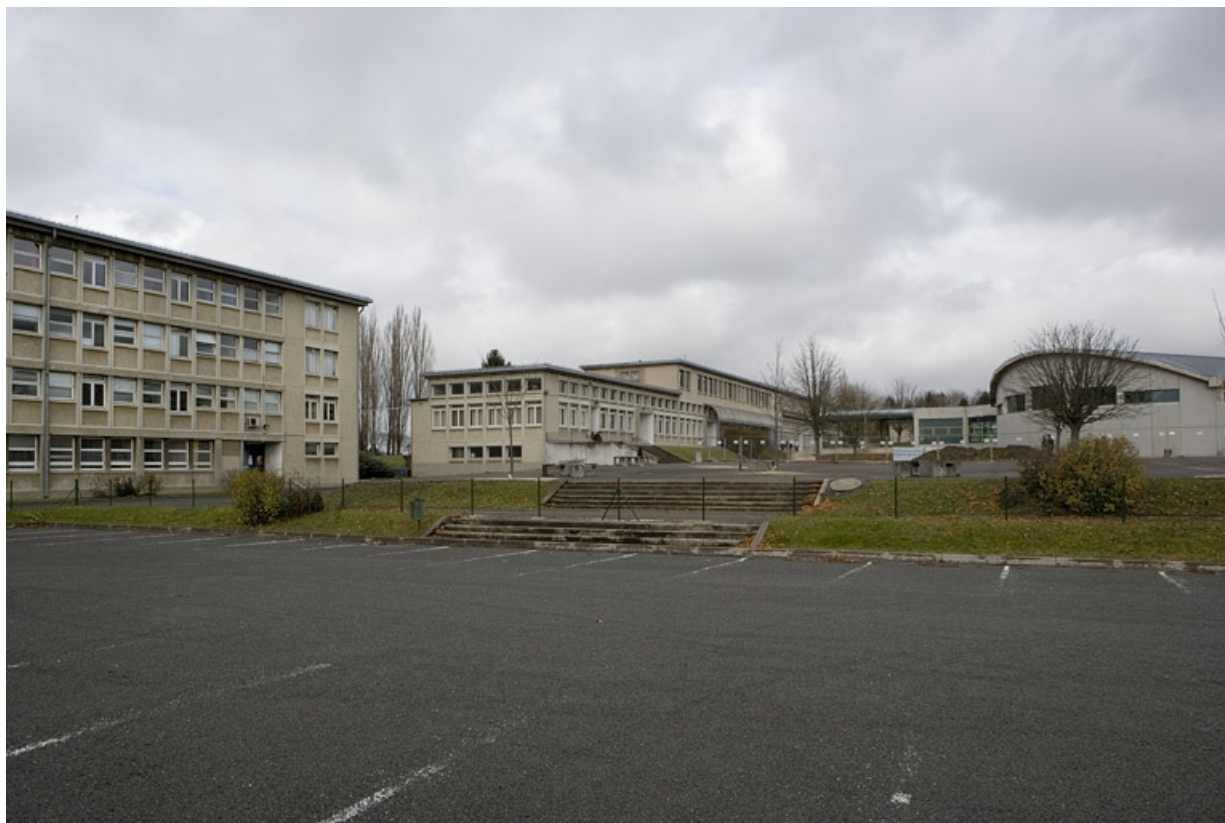
Vue d'ensemble bâtiments D et B.
