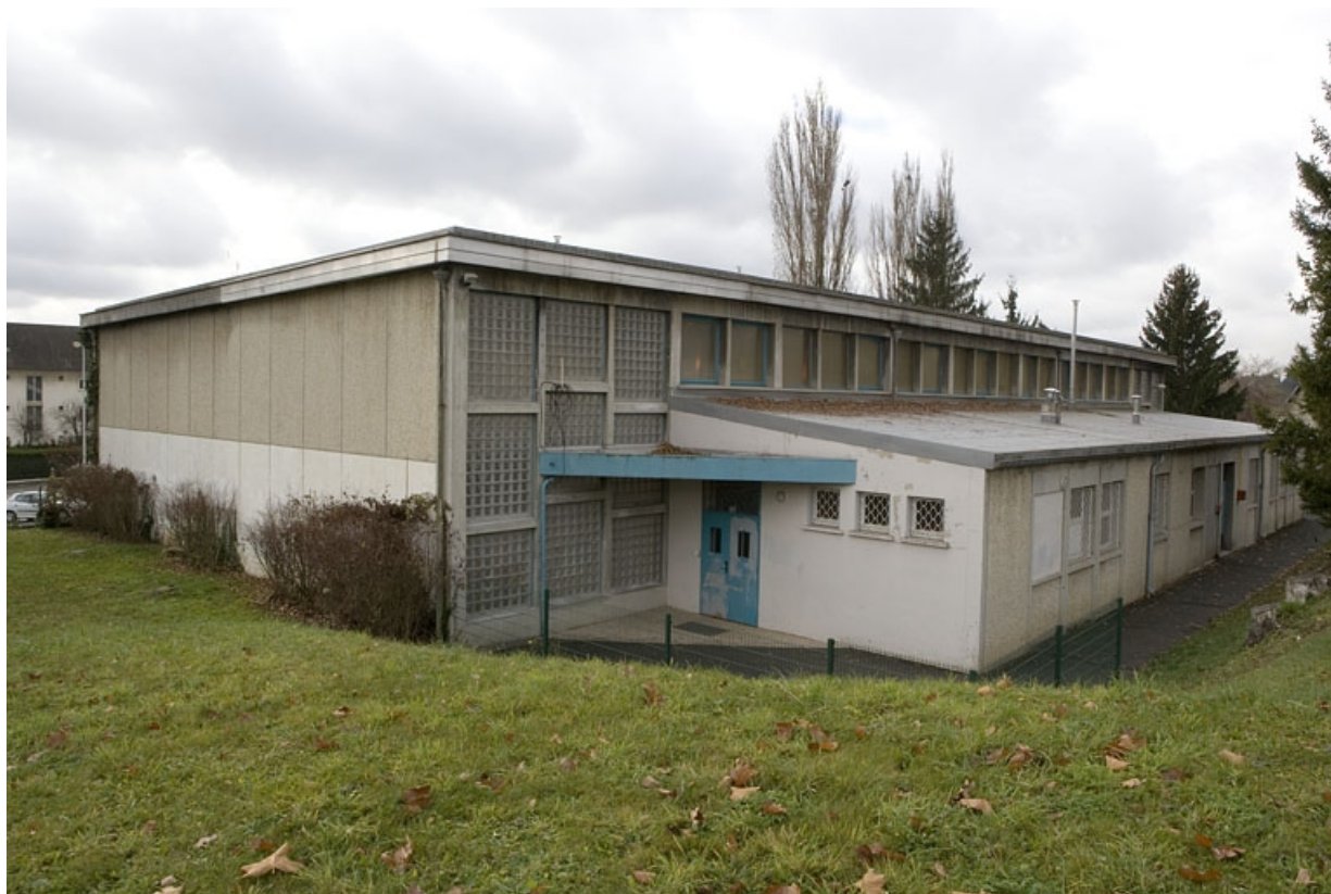
Bâtiment F1. Vue de trois quarts gauche du gymnase.
