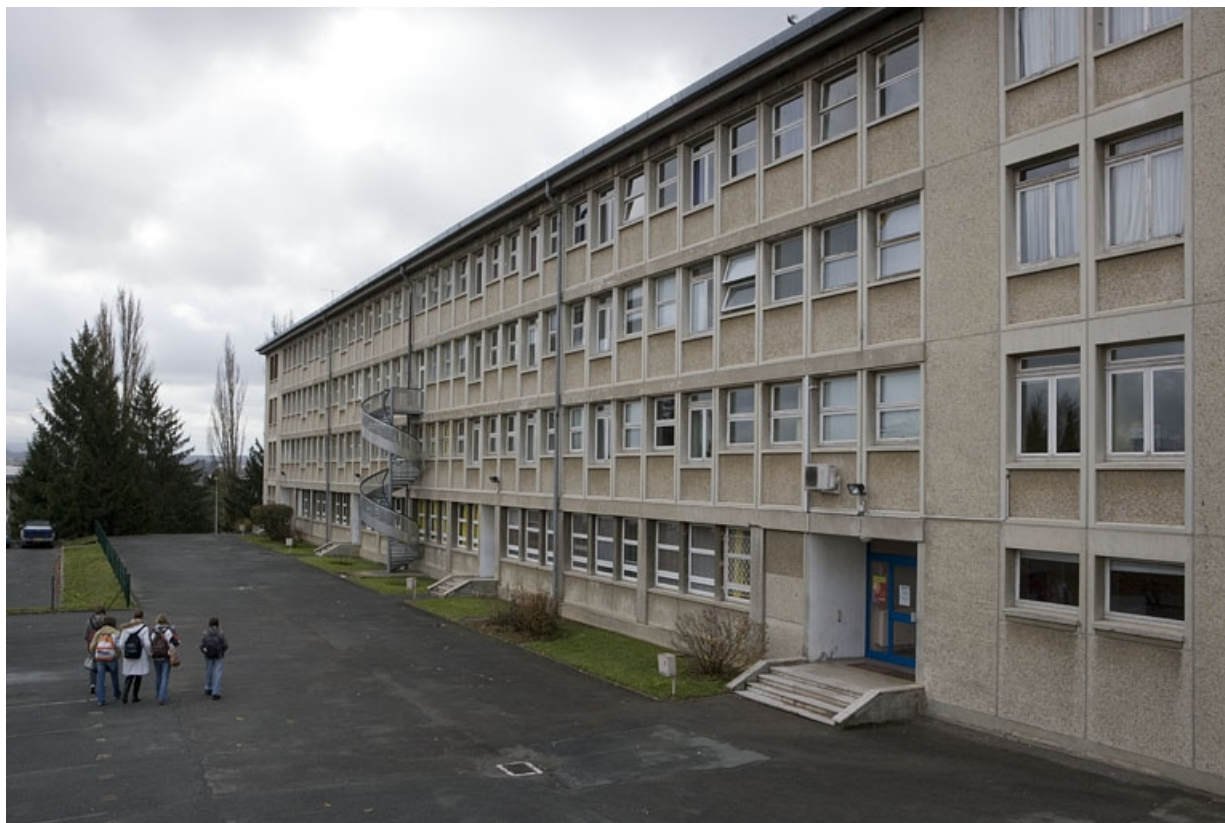
Vue façade latérale bâtiment D.
