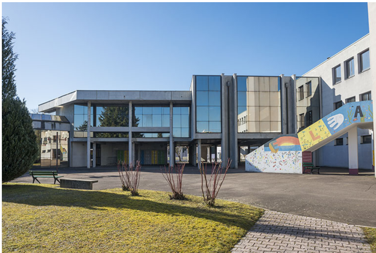
Façade nord du bâtiment d'accueil.
