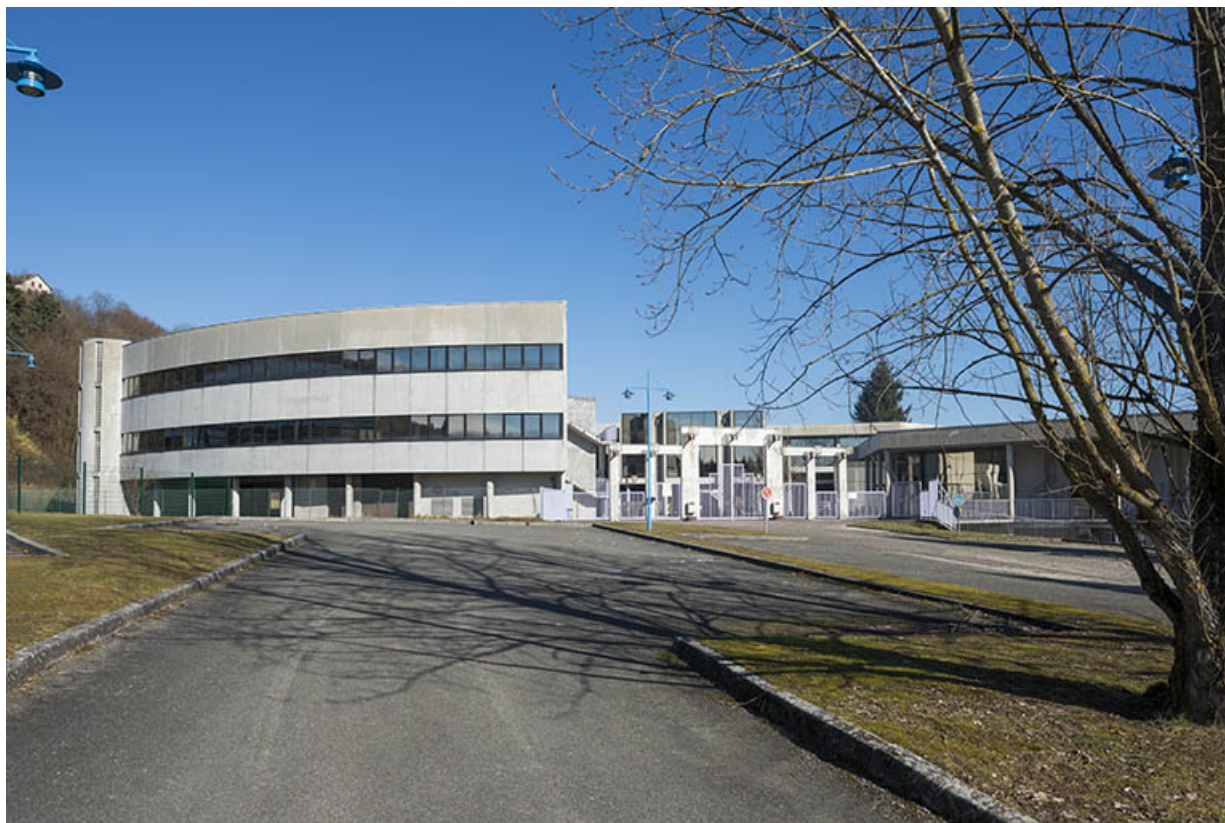
Vue d'ensemble depuis le sud : façade sud de l'externat-sud.
