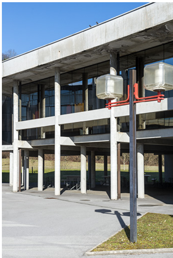
Détail de préau sous le bâtiment d'accueil.
