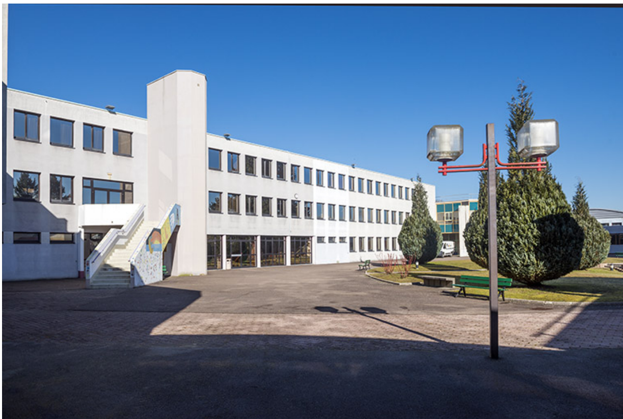
Façade est du bâtiment d'enseignement scientifique.
