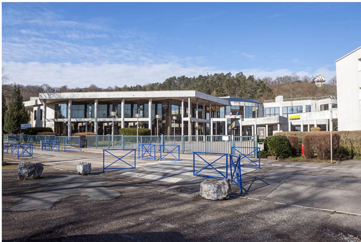
Valentigney, lycée Armand Peugeot : entrée depuis la rue des Carrières. 25, Valentigney, 30 rue des Carrières
