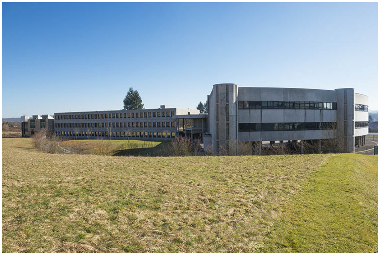
Vue d'ensemble des façades ouest.
