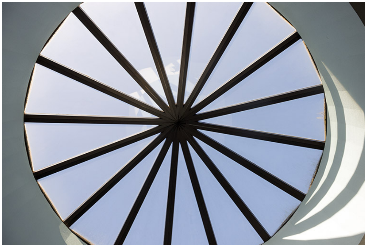
Détail intérieur de l'oculus zénithal du hall.
