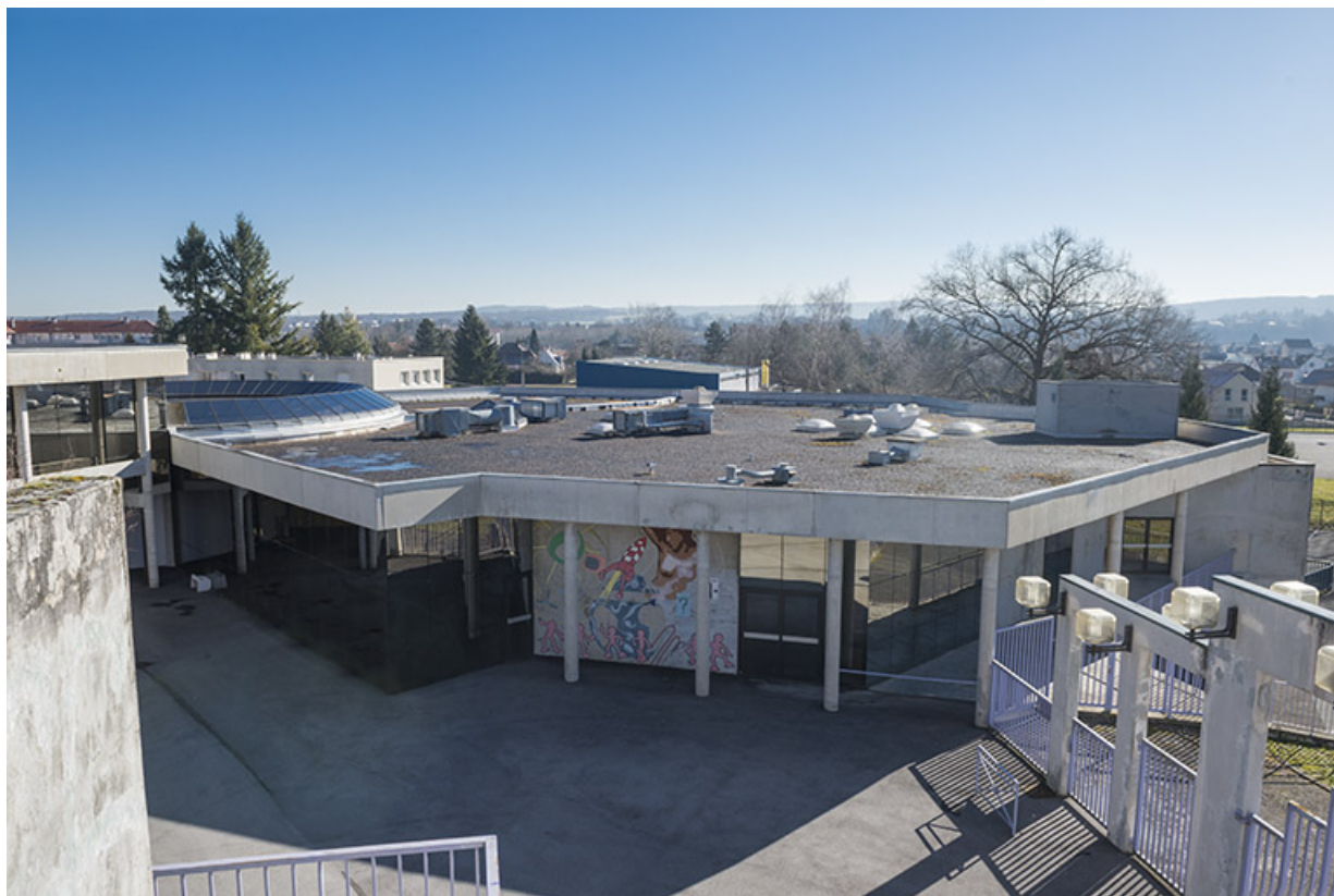
Forum et sa terrasse depuis l'externat sud. 25, Valentigney, 30 rue des Carrières
