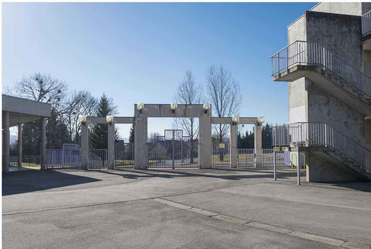
Depuis la cour sud, vue sur la grille et l'externat sud.
