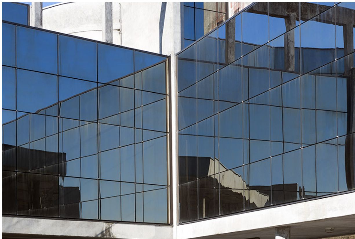
Vue rapprochée de l'angle intérieur nord-est de l'externat sud.
