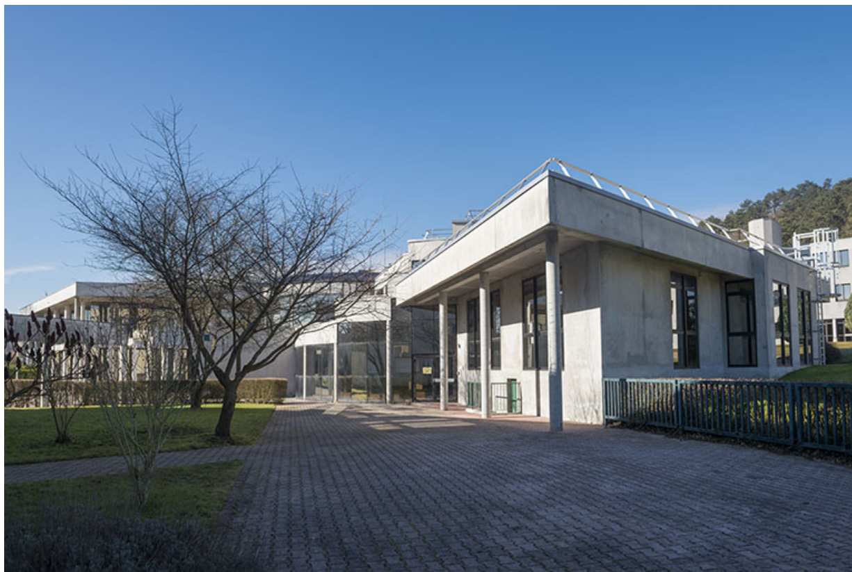
Angle nord-est de l'administration et façade est.
