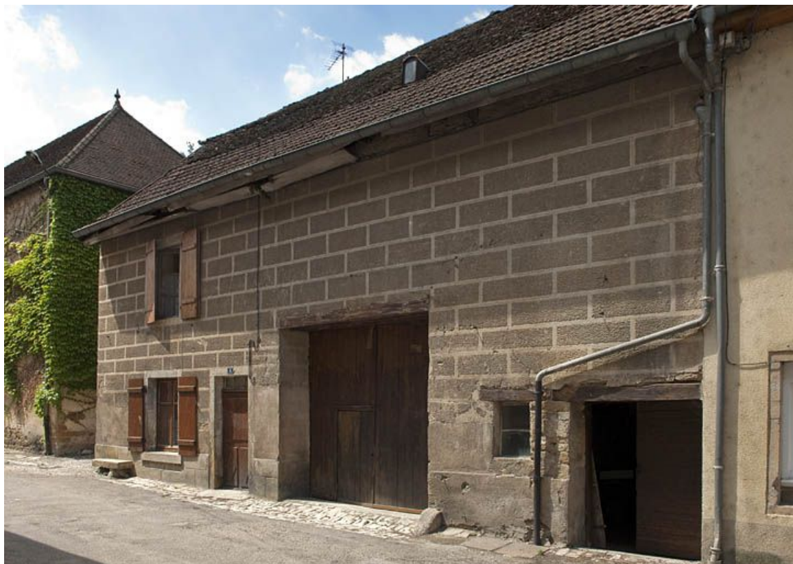
Façade antérieure, vue de trois quart droit.
