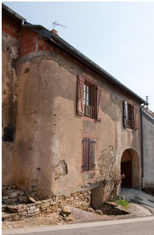
Vue rapprochée de la façade antérieure.
