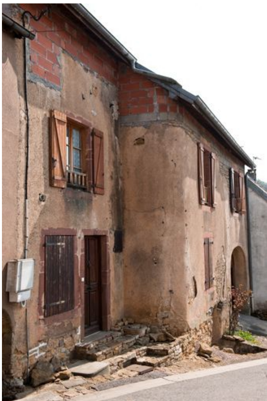
Façade antérieure, vue de trois quart gauche.
