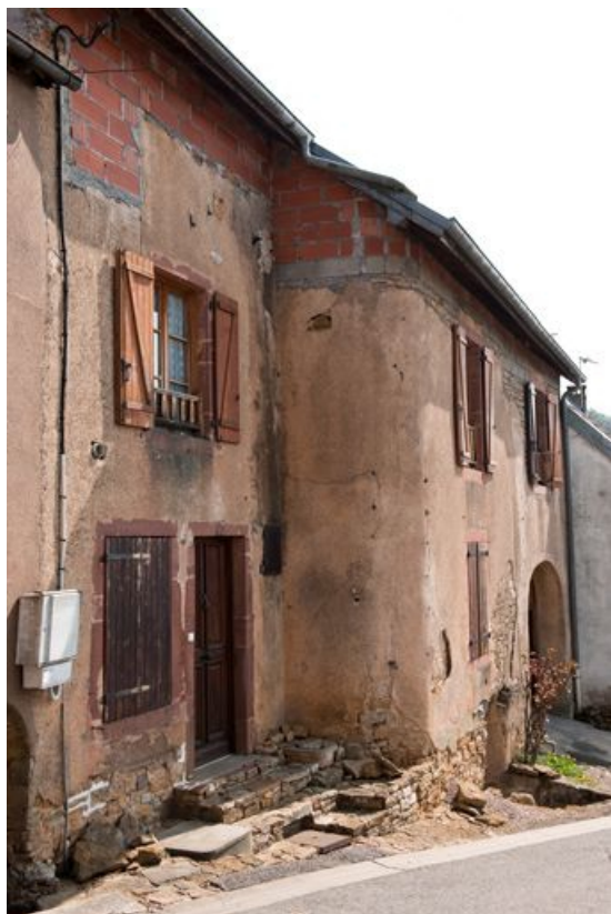
Façade antérieure, vue de trois quart gauche.
