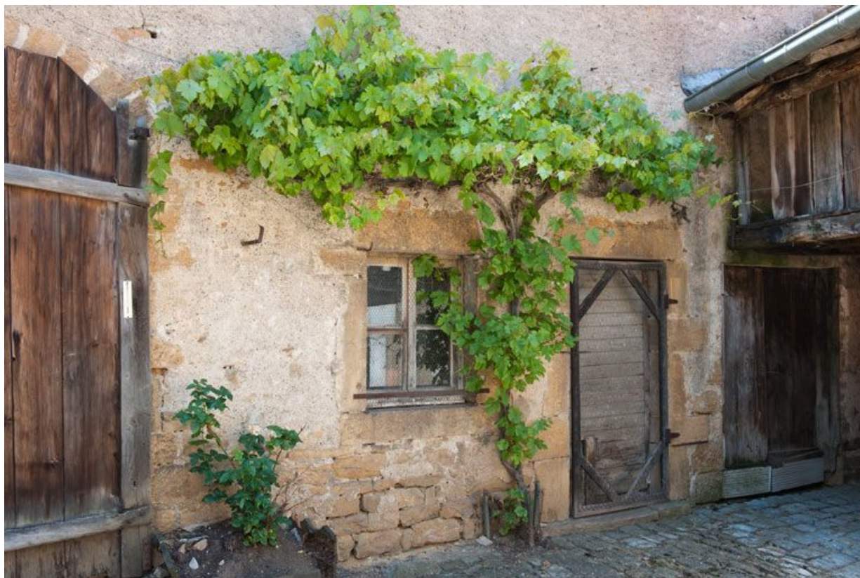
Les parties agricoles : la grange, l'étable et la remise.
