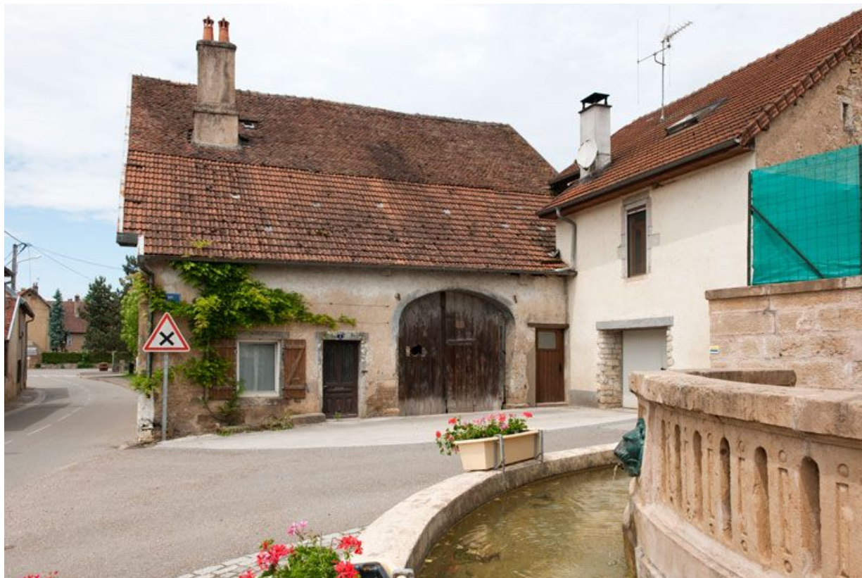
Vue rapprochée de la façade, du côté de la rue des Gratteris.
