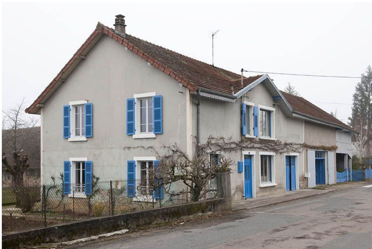
Façade antérieure et façade latérale gauche.
