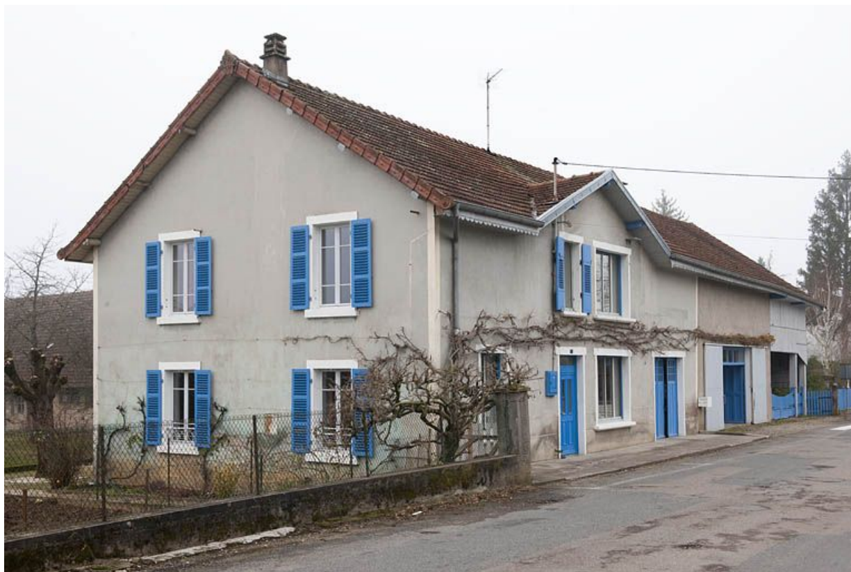
Façade antérieure et façade latérale gauche.
