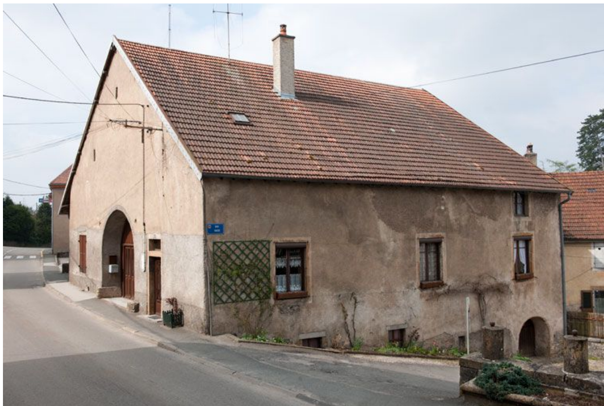
Façade antérieure et façade latérale droite.
