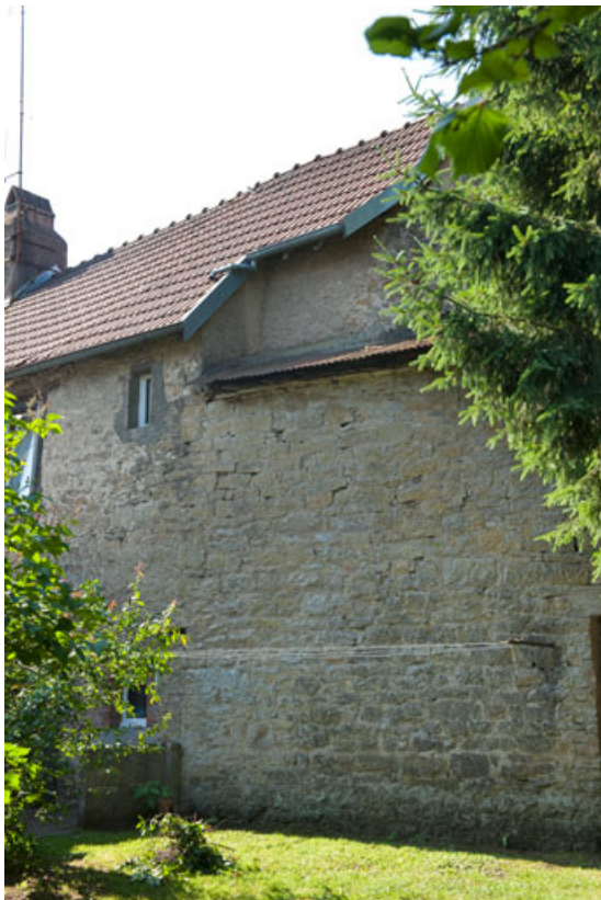
Construction élevée sur le mur d'enceinte, 7 rue du Vieux Moulin. 25, Rougemont
