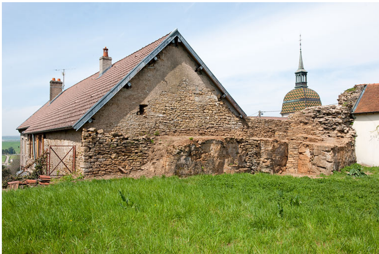
Revers des vestiges d'une tour du château accolée à la "maison d'autrefois", Quartier de la Citadelle. 25, Rougemont
