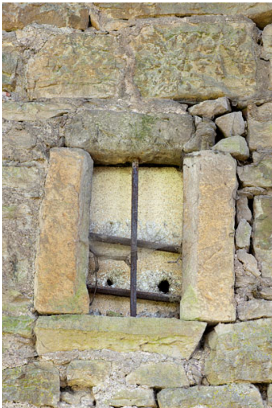
Ancienne baie encastrée dans le mur d'enceinte, 7 rue du Vieux Moulin. 25, Rougemont
