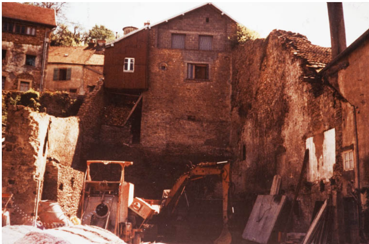
Une partie du mur d'enceinte en cours de destruction vers 1983-1984, 29 Grande Rue. 25, Rougemont
