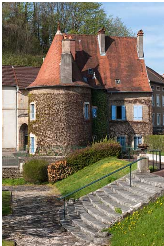
Vue générale de la maison du Vieux Moulin depuis le jardin de l'ancien château Vorget. 25, Rougemont
