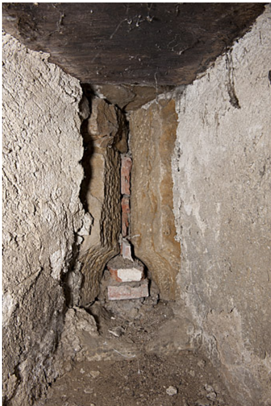
Archère-canonnière en "trou de serrure", 2 rue du Carrefour des Halles. 25, Rougemont
