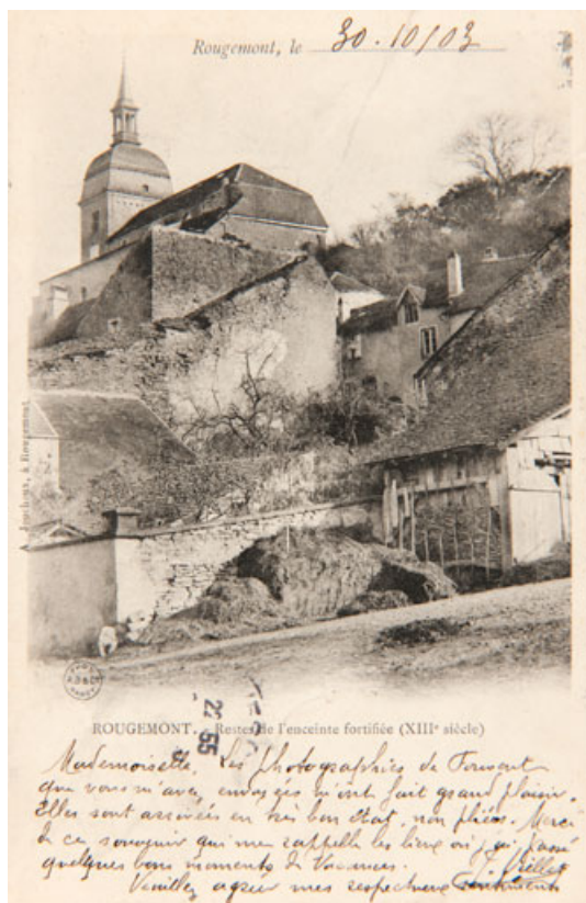
ROUGEMONT. Restes de l'enceinte fortifiée (XIIIe siècle). 25, Rougemont
