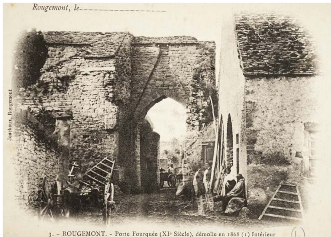
3.- Rougemont.- Porte Fourquée (XIe siècle), démolie en 1868. Intérieur. 25, Rougemont
