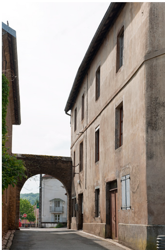
Vue de la porte du Vieux-Moulin et de la façade antérieure de l'hôtel. 25, Rougemont, 22 rue du Vieux Moulin
