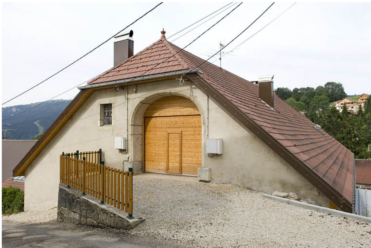
Façade latérale gauche et le pont de l'ancienne grange, rue du Châtelet. 25, Jougne, 16 rue de l' Eglise
