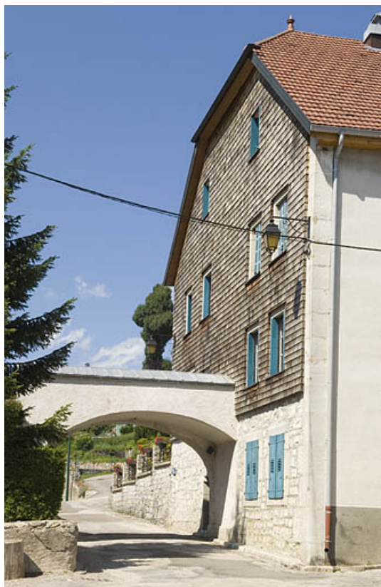
Façade latérale, côté rue de l'Eglise.
