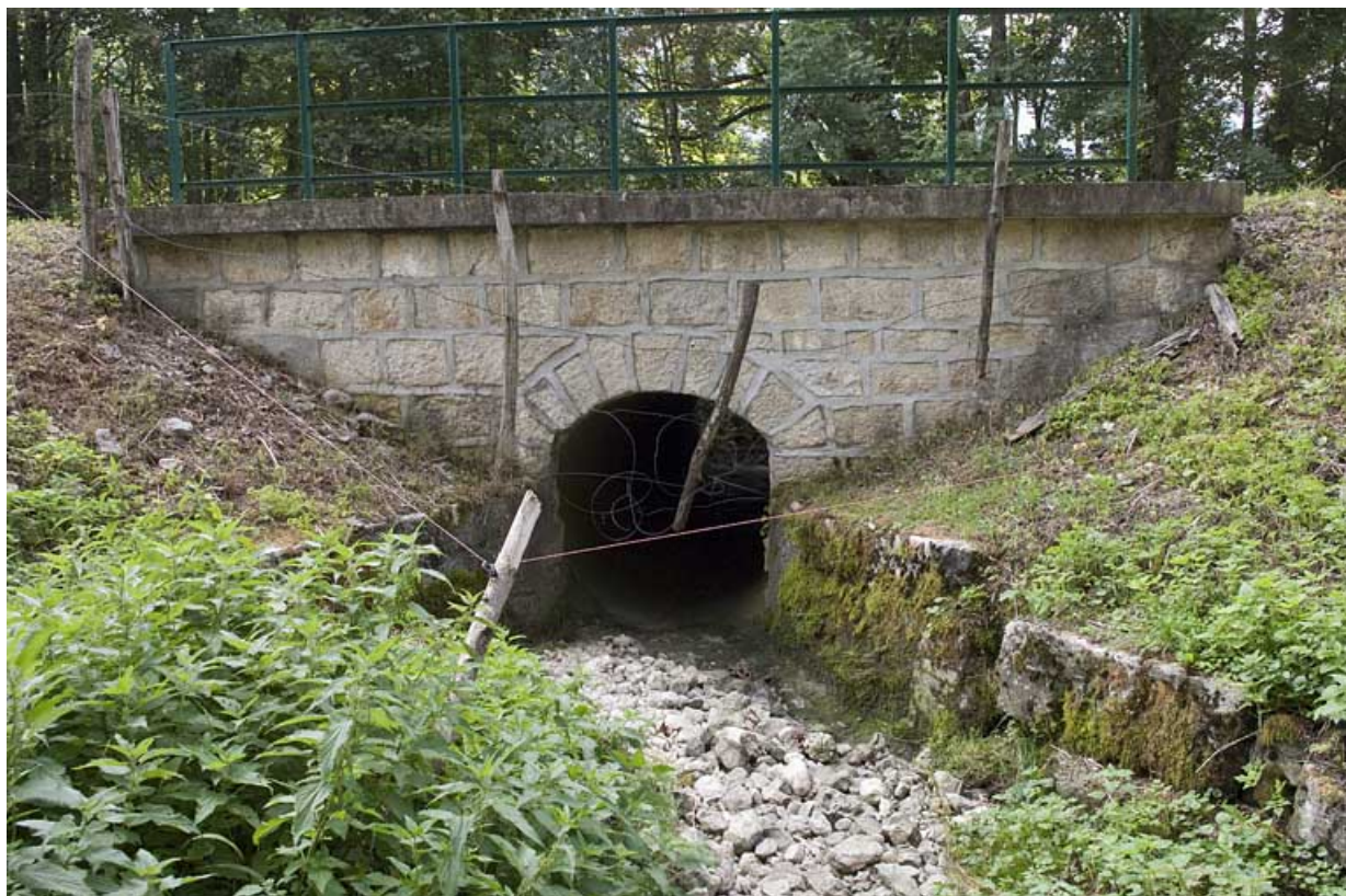
Pont sur la Servante (n°5), vue depuis l'amont. 25, Jougne
