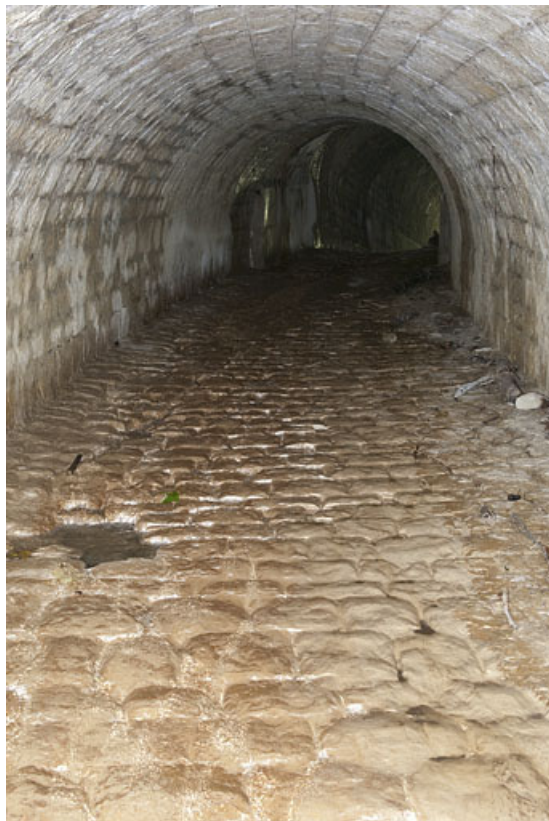
Intérieur du pont,aqueduc du Vaubillon (n°6), détail du pavage. 25, Jougue
