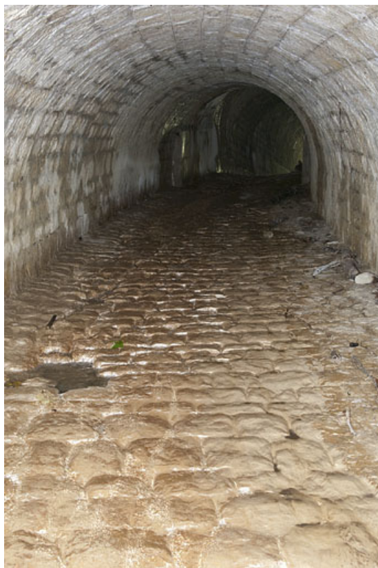
Intérieur du pont,aqueduc du Vaubillon (n°6), détail du pavage. 25, Jougne
