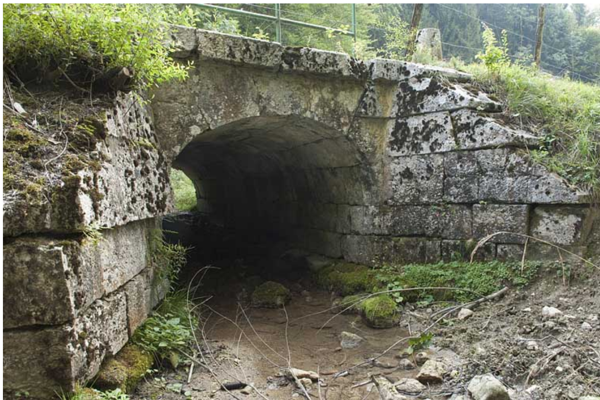
Pont du ruisseau de la Goulette (n° 18), vu depuis l'aval. 25, Jougne
