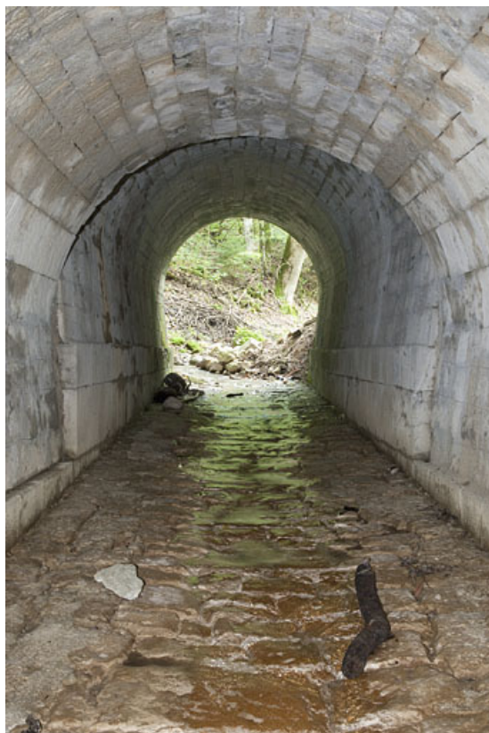
Intérieur du pont, aqueduc (n°6) en direction des Tavins. 25, Jougne
