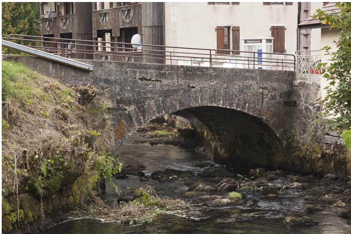
Pont sur la Jougna (n°13), vue depuis l'amont. 25, Jougne
