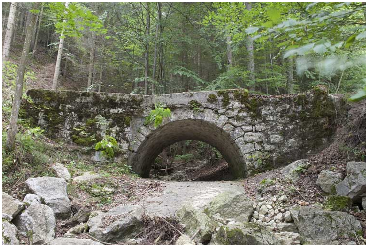
Pont sur le ruisseau de la Grange des Pauvres (n°7), vue depuis l'aval. 25, Jougne
