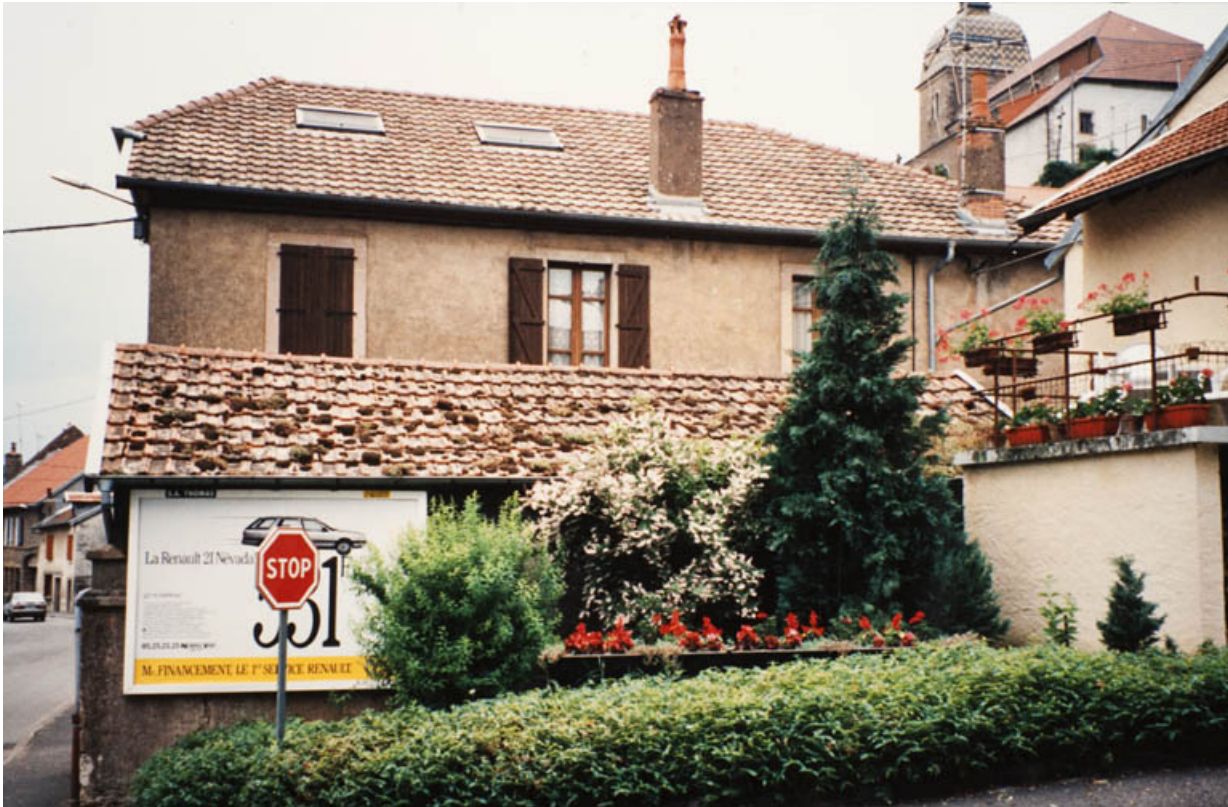
Remise vue depuis le Bas de la Côte, avant 1983. 25, Rougemont, 27, 29 Grande Rue
