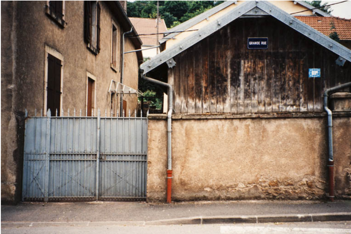
Remise située à l'arrière du bâtiment en AL549, avant 1983.
