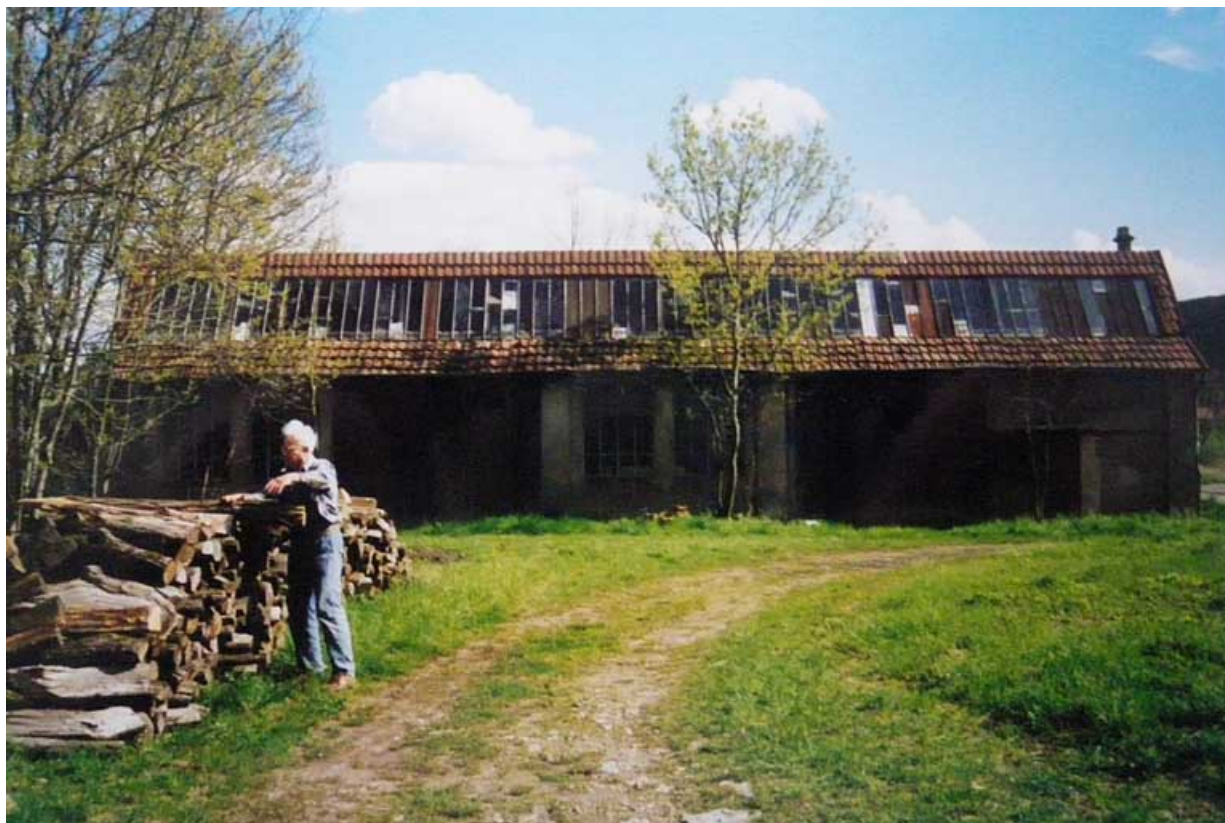
[Façade latérale gauche].
