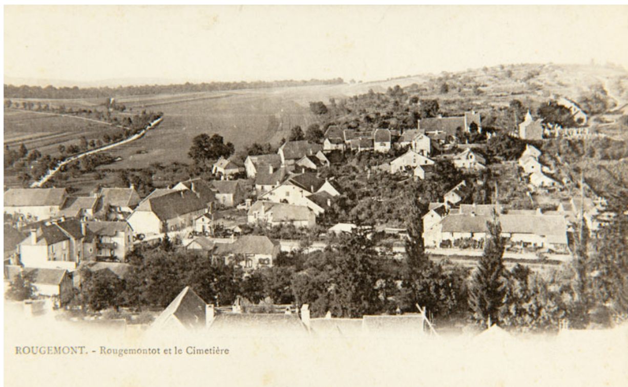
Rougemont.-[quartier de] Rougemontot et le Cimetière. 25, Rougemont rue des Gratteris, lieudit : Rougemontot
