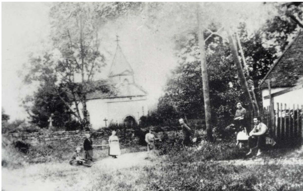
[Vue générale de la chapelle].
