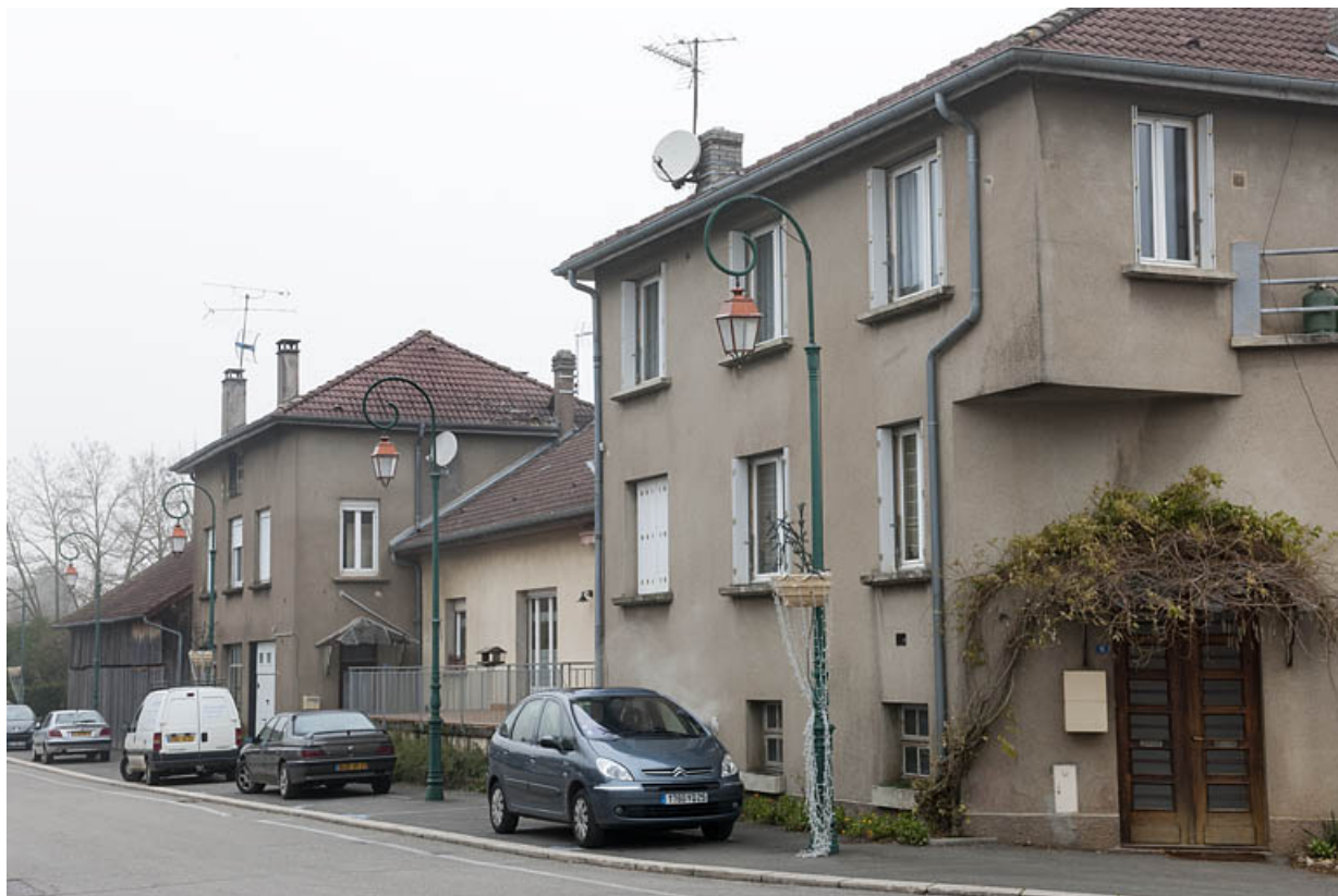
Vue d'ensemble des constructions le long de l'avenue de la Gare.
