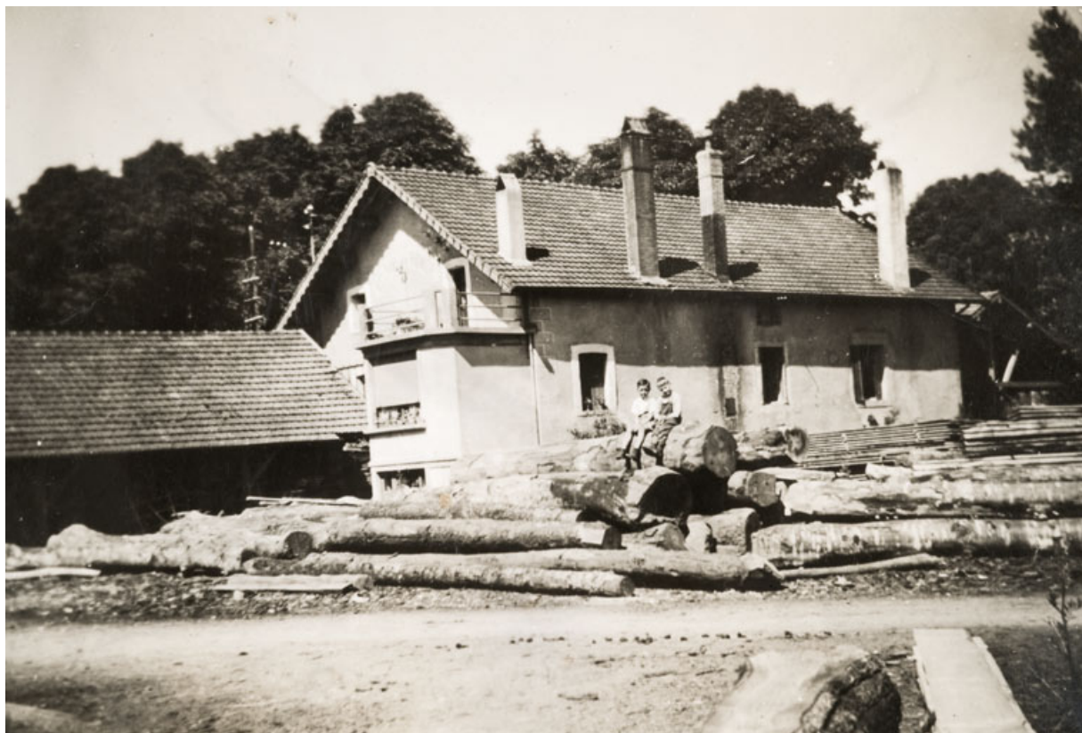
[Revers des constructions le long de l'avenue de la Gare (hangar détruit) avec l'aire des matières premières et des produits manufacturés, vers 1950].
