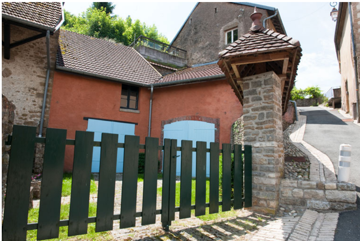
Vue d'ensemble des constructions abritant les caves.
