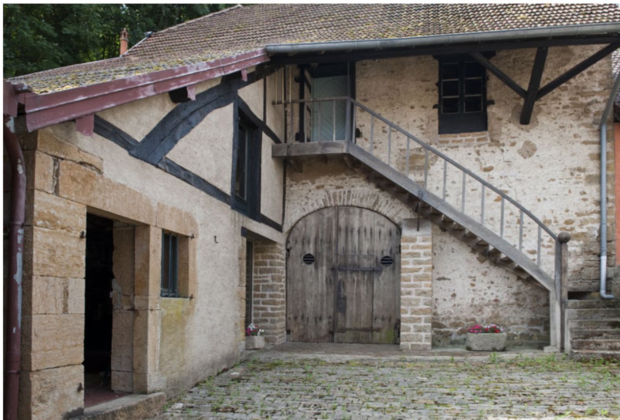
Vue générale des communs depuis l'entrée.
