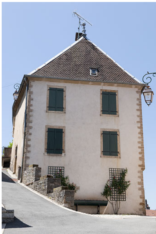
Façade latérale droite.
