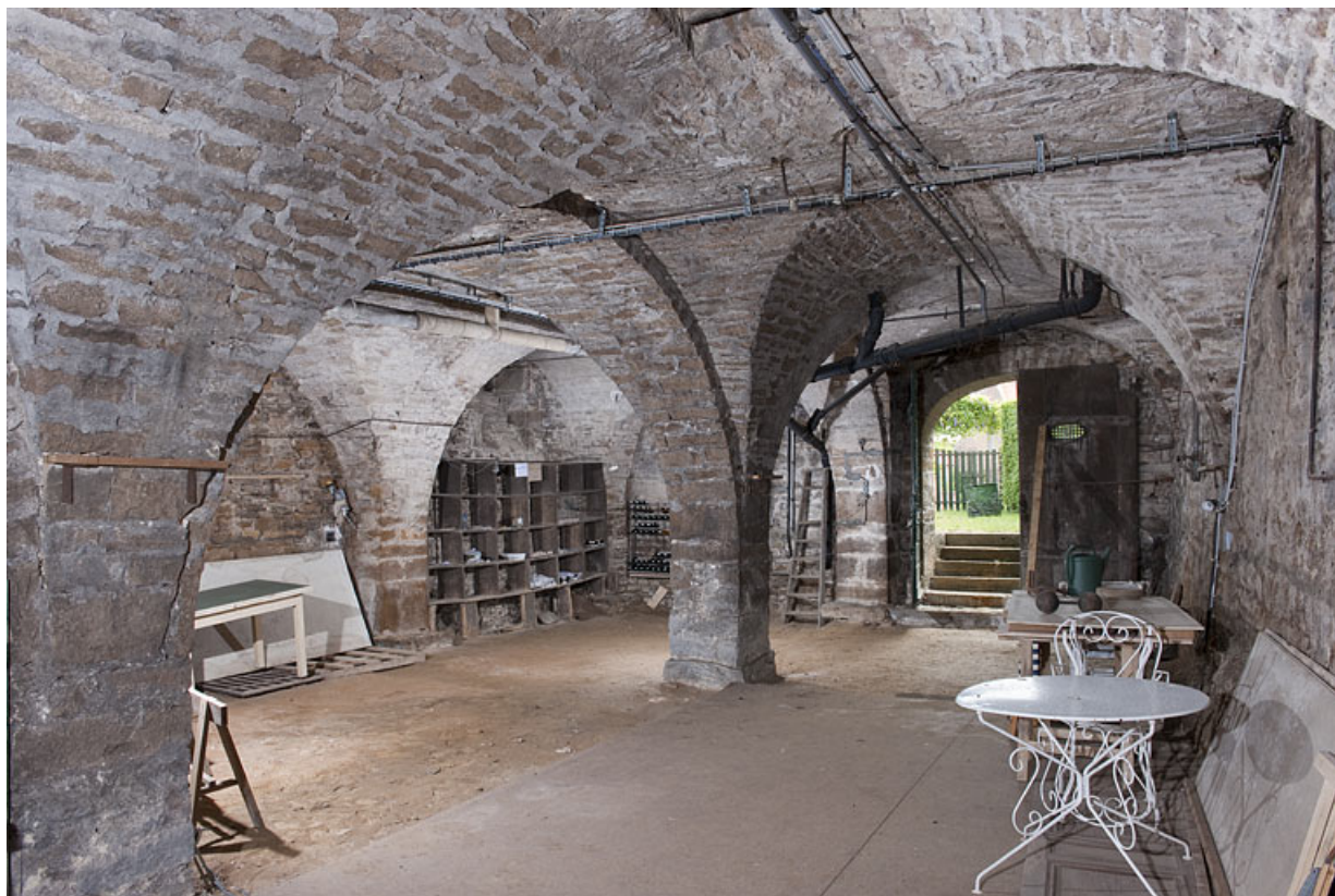
Le sous-sol : vue de trois quarts.
