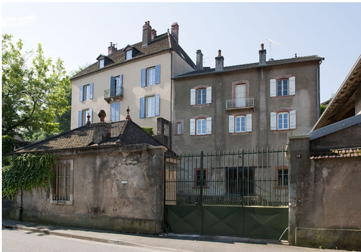
Vue d'ensemble de la demeure et de la maison de négociant Bichet rue du Vieux Moulin.
