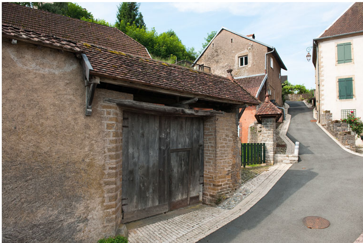
Vue des communs et de la demeure depuis la rue de la Petite Côte.
