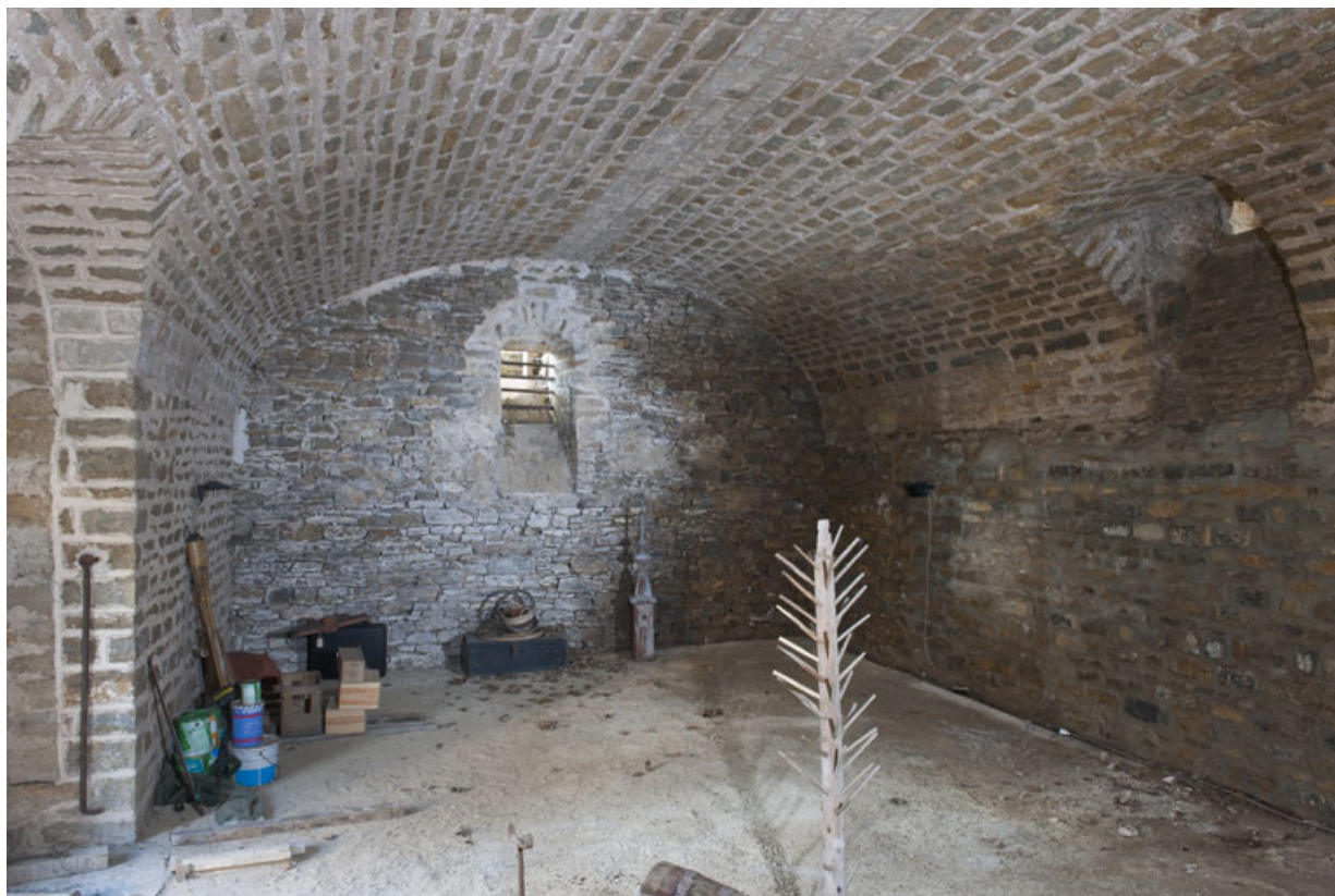
Vue générale d'une des caves des communs.
