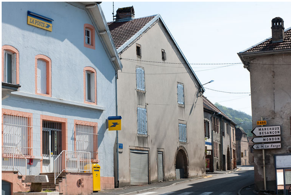
Vue générale de la façade antérieure depuis la place.
