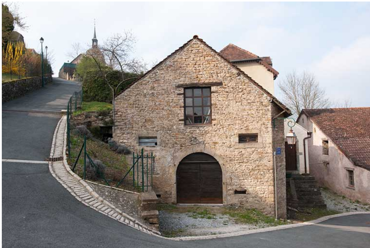
Grange : façade latérale gauche.
