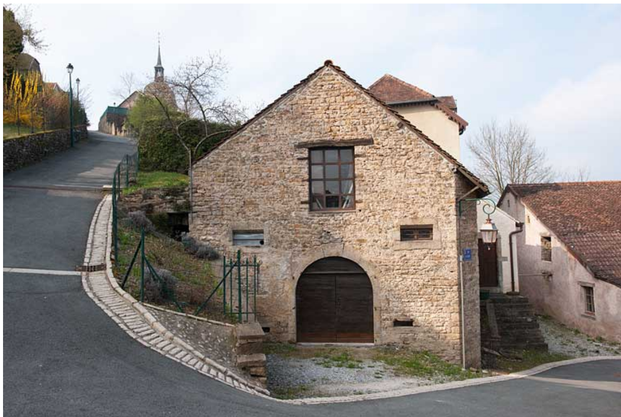
Grange : façade latérale gauche. 25, Rougemont, 6 rue de l' Église
