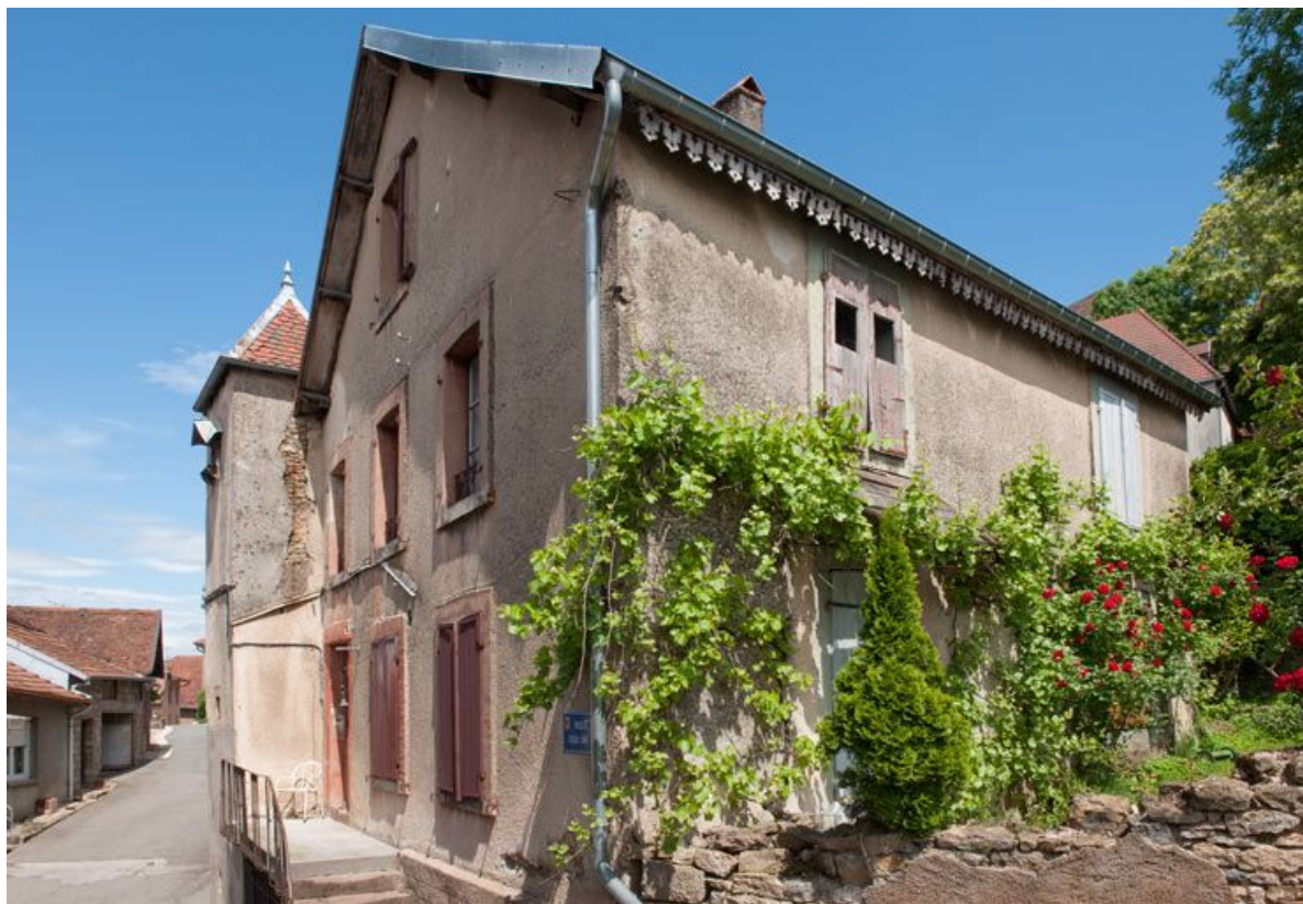
Façade antérieure et façade latérale droite.
