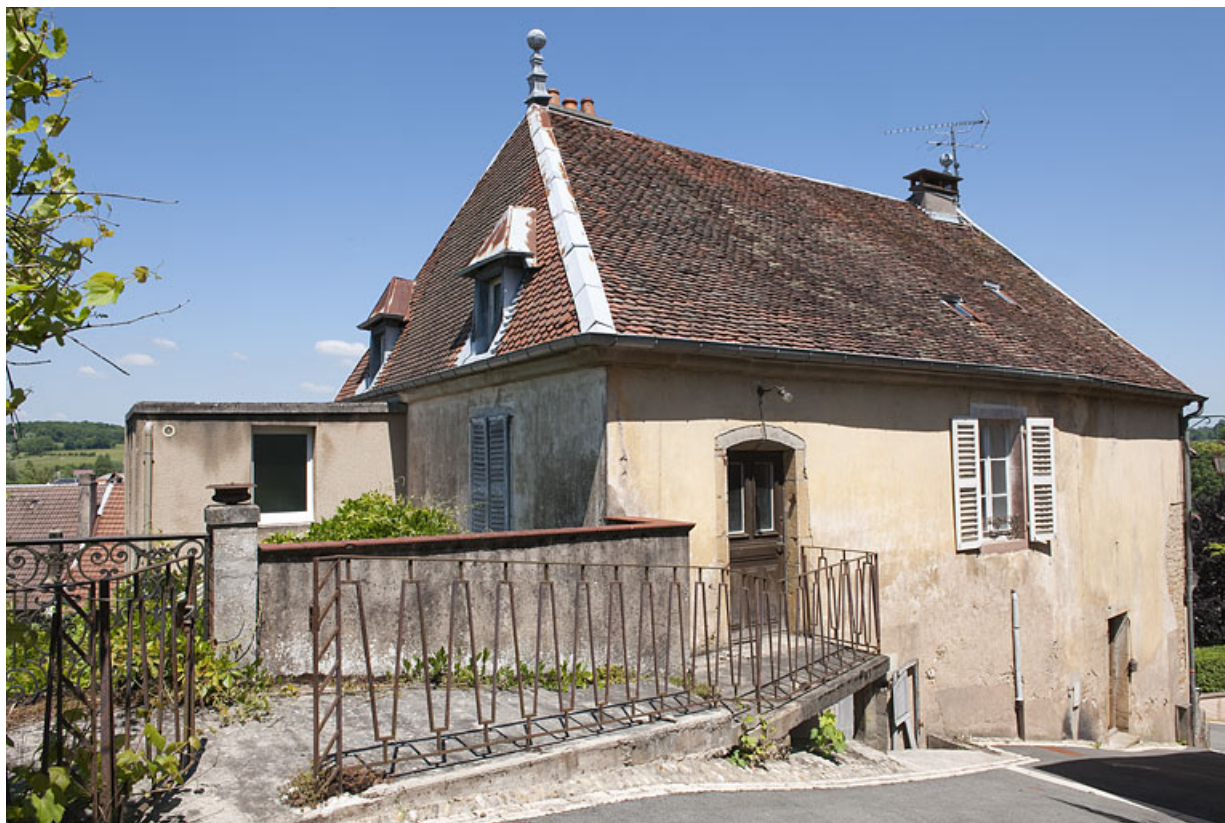
Façade sur la rue de la Petite Côte (sud).
