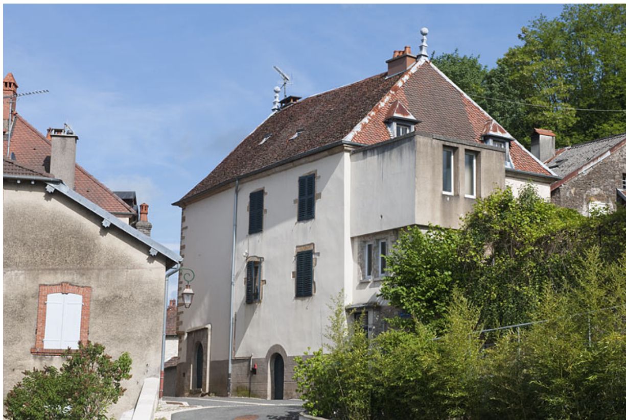
Façade sur la rue de la Glacière (nord). 25, Rougemont, 5 rue de la Glacière
