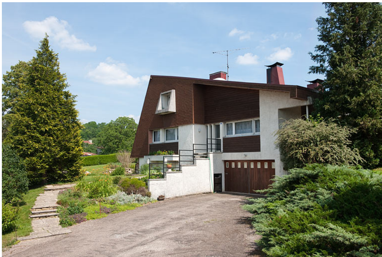
Vue générale de la façade antérieure, route de Besançon.
