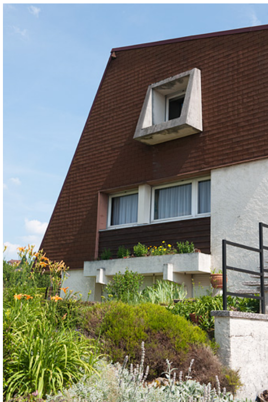
Détail : baies de la façade antérieure.
