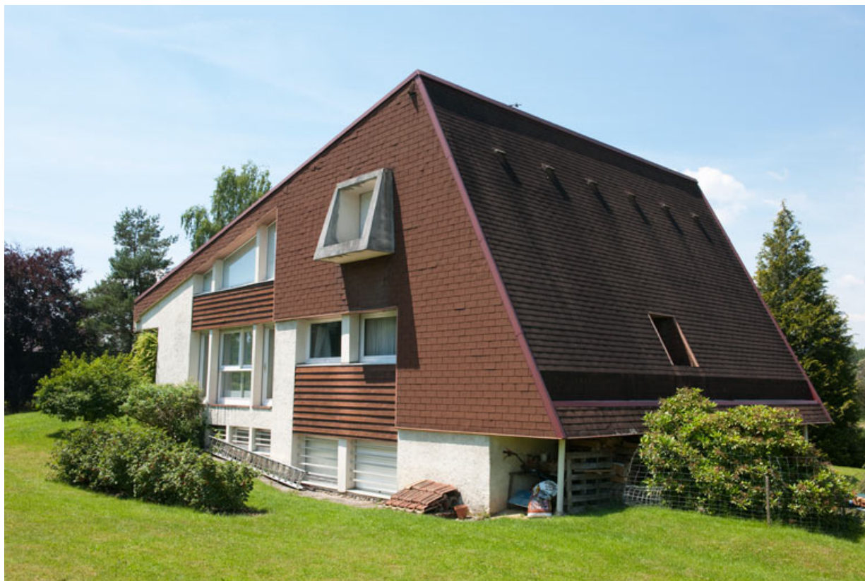
Façade postérieure vue de trois-quarts droit. 25, Rougemont, 19 route de Besançon
