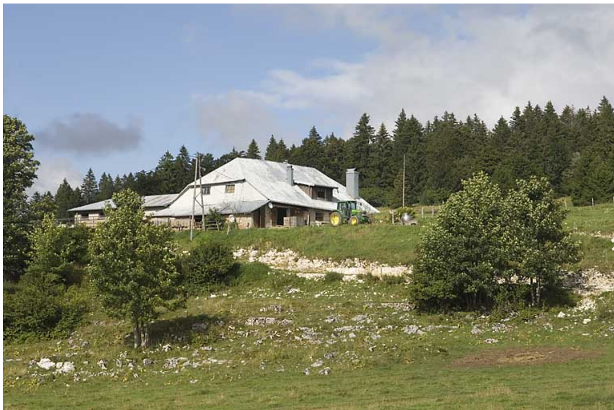
Vue rapprochée du chalet d'estive de la Piagrette et ancien refuge du C.A.F. 25, Jougne
