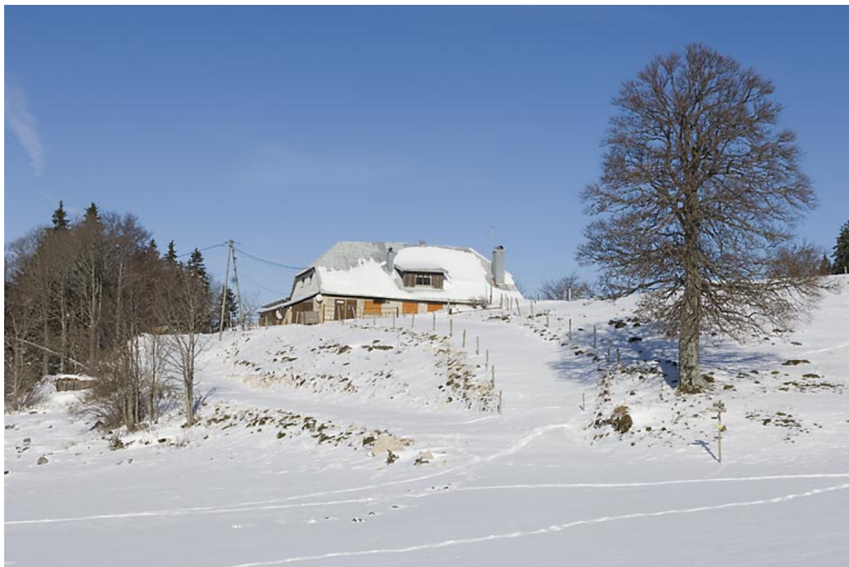
Vue générale du chalet d'estive de la Piagrette et ancien refuge du C.A.F. 25, Jougne
