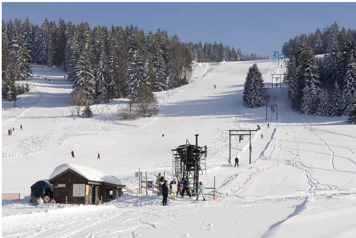
Vue d'ensemble du télésiège d'Entre-les-Fourgs. 25, Jougne
