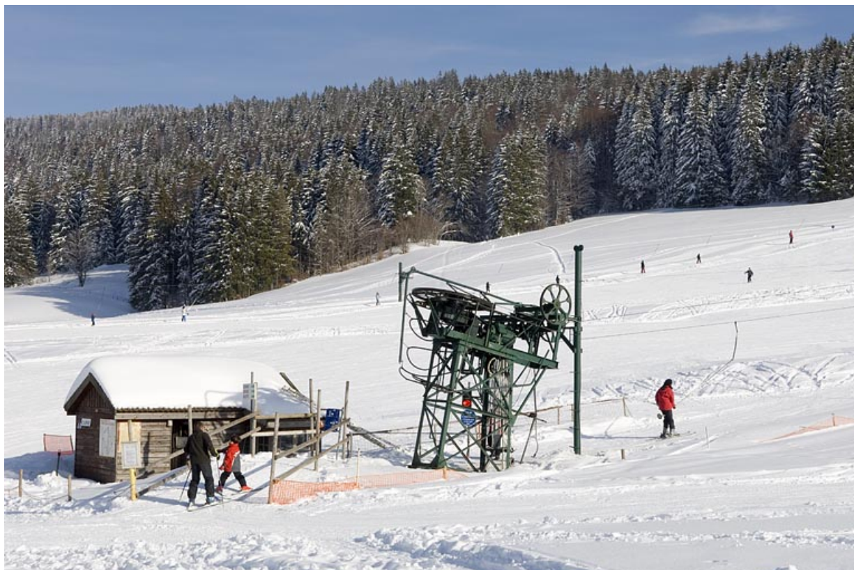
Départ du grand télésiège d'Entre-les-Fours. 25, Jougne
