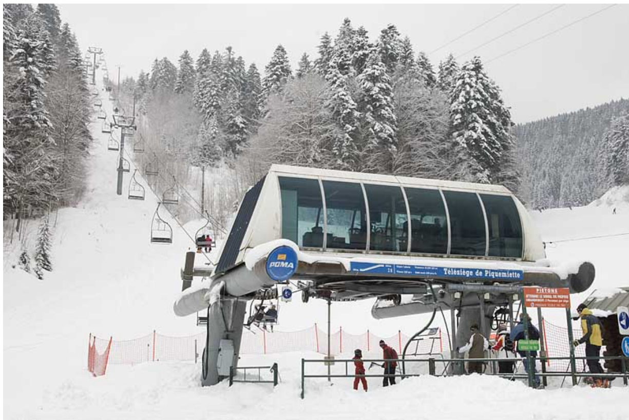
Vue rapprochée du télésiège au départ des Tavins en direction du domaine de Piquemiette. 25, Jougne
