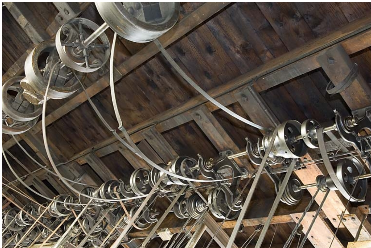
Les arbres de transmission équipés des poulies et des courroies. 25, Besançon, 11 rue Larmet
