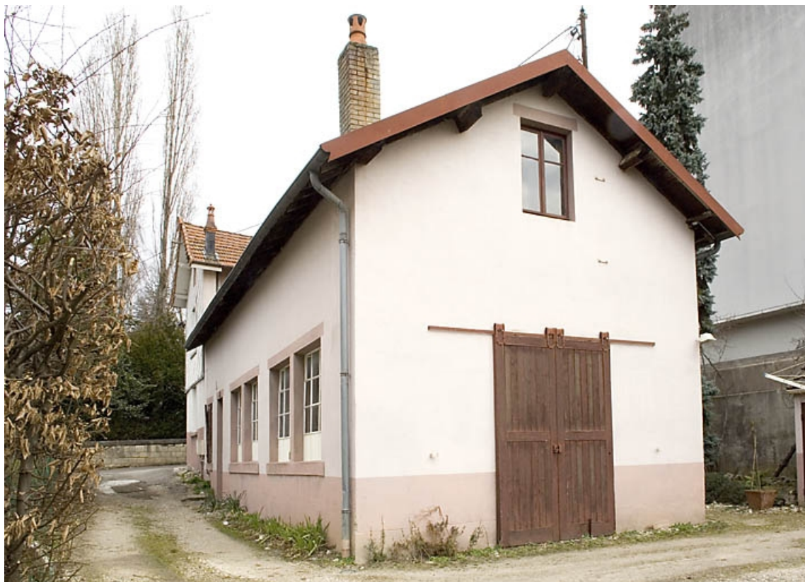
Atelier de fabrication vu depuis le sud-ouest. 25, Besançon, 11 rue Larmet
