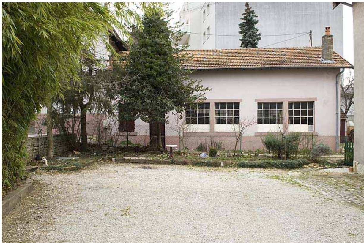
Façade ouest de l'atelier de fabrication.
