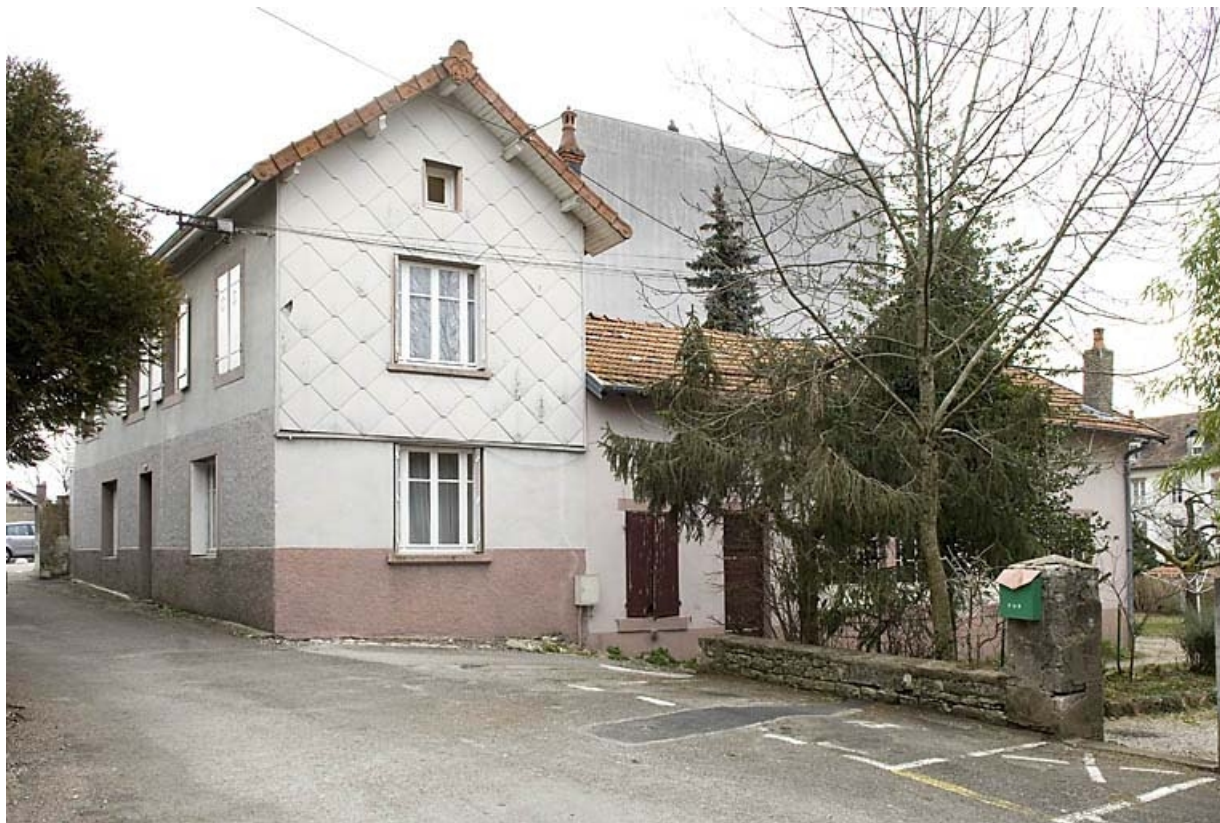
Vue d'ensemble depuis la rue Larmet : logement et atelier de fabrication.
