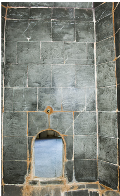
L'ouverture d'une cuve depuis l'intérieur.
