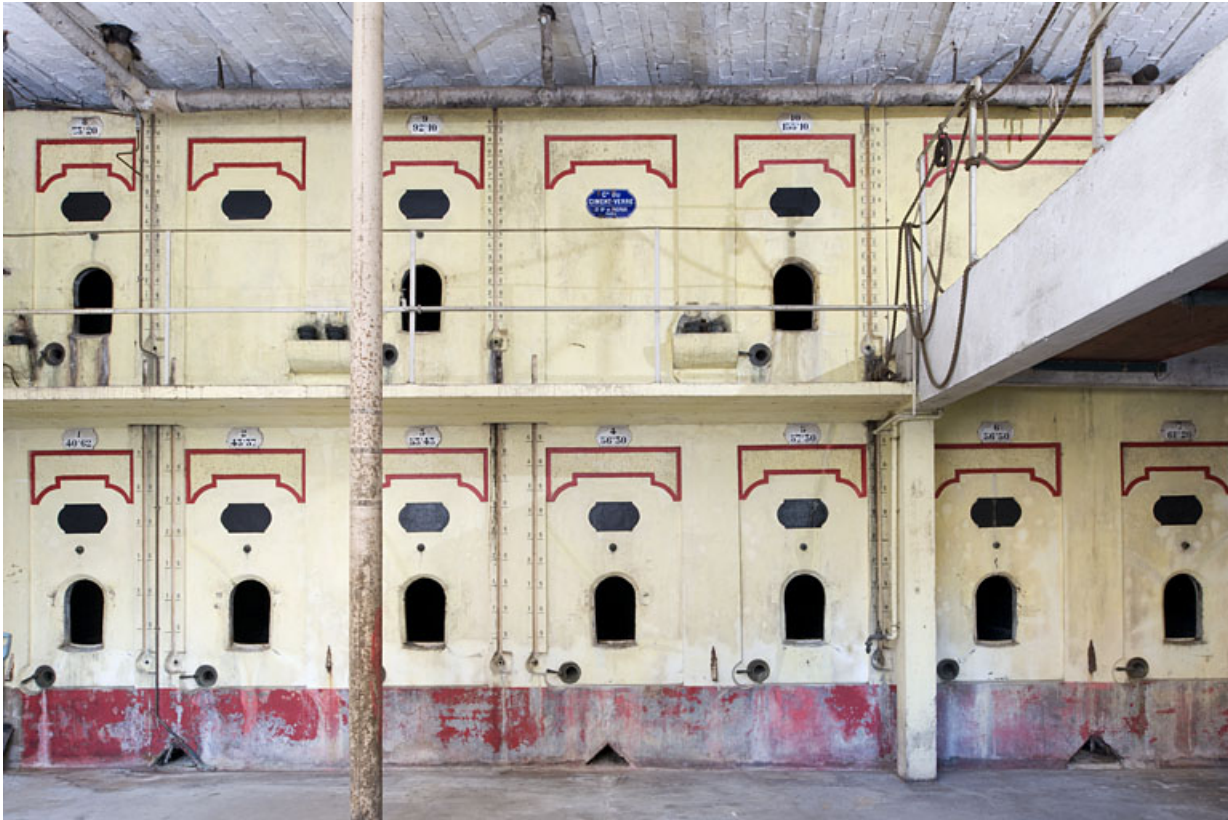
Intérieur de l'entrepôt : vue d'ensemble des cuves depuis l'entrée.
