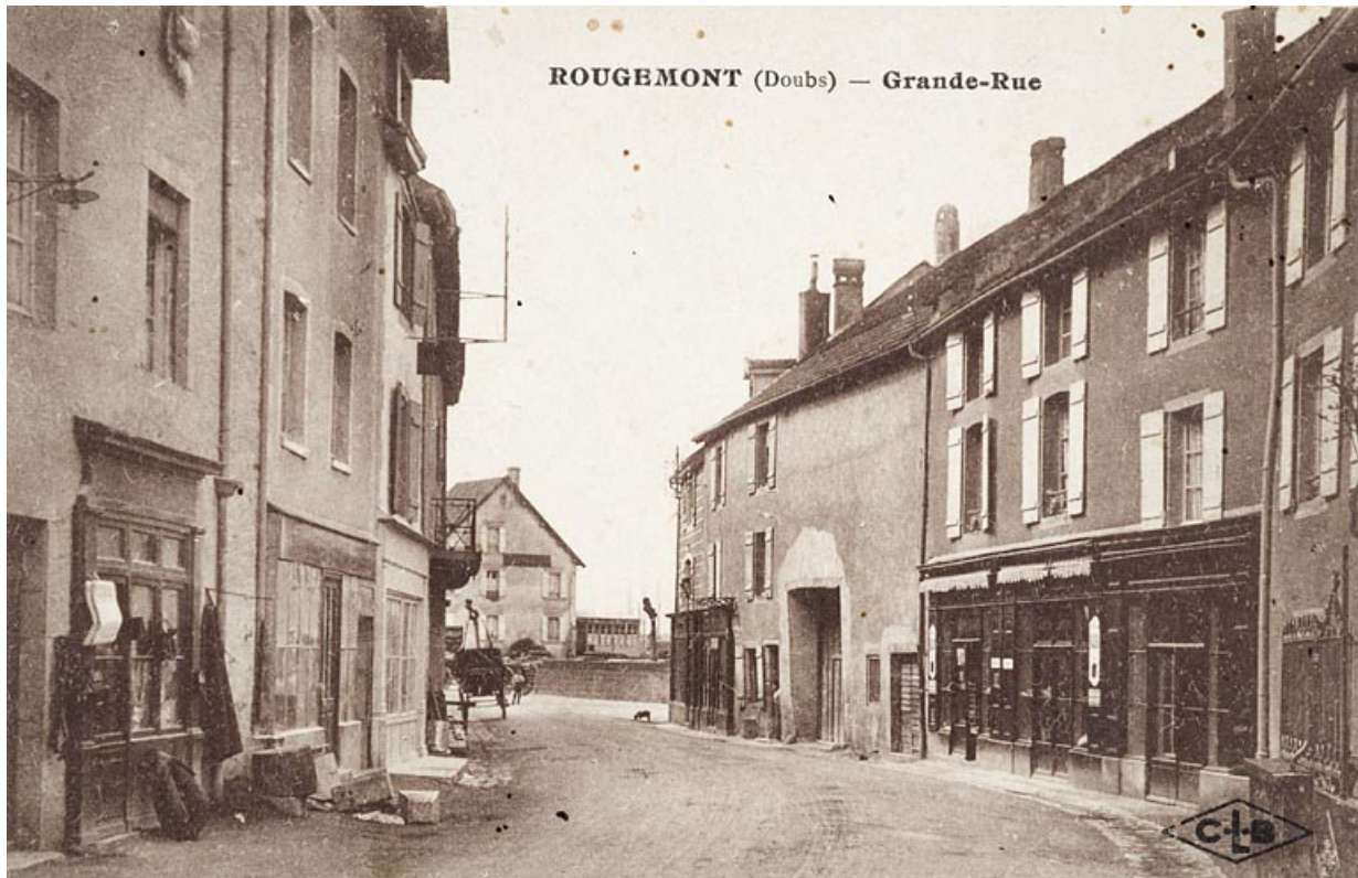
Rougemont, Doubs-Grande-Rue. [Le magasin de Denis-Joseph Laboube est le 1er à droite de la carte postale]. 25, Rougemont, 10 rue du Vieux Moulin
