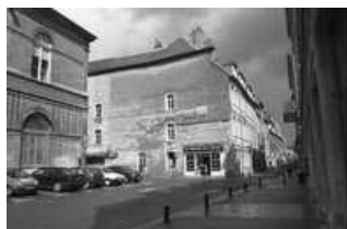
Hôtel et immeuble : vue de la façade latérale gauche, sur la rue Pâris. 25, Besançon
