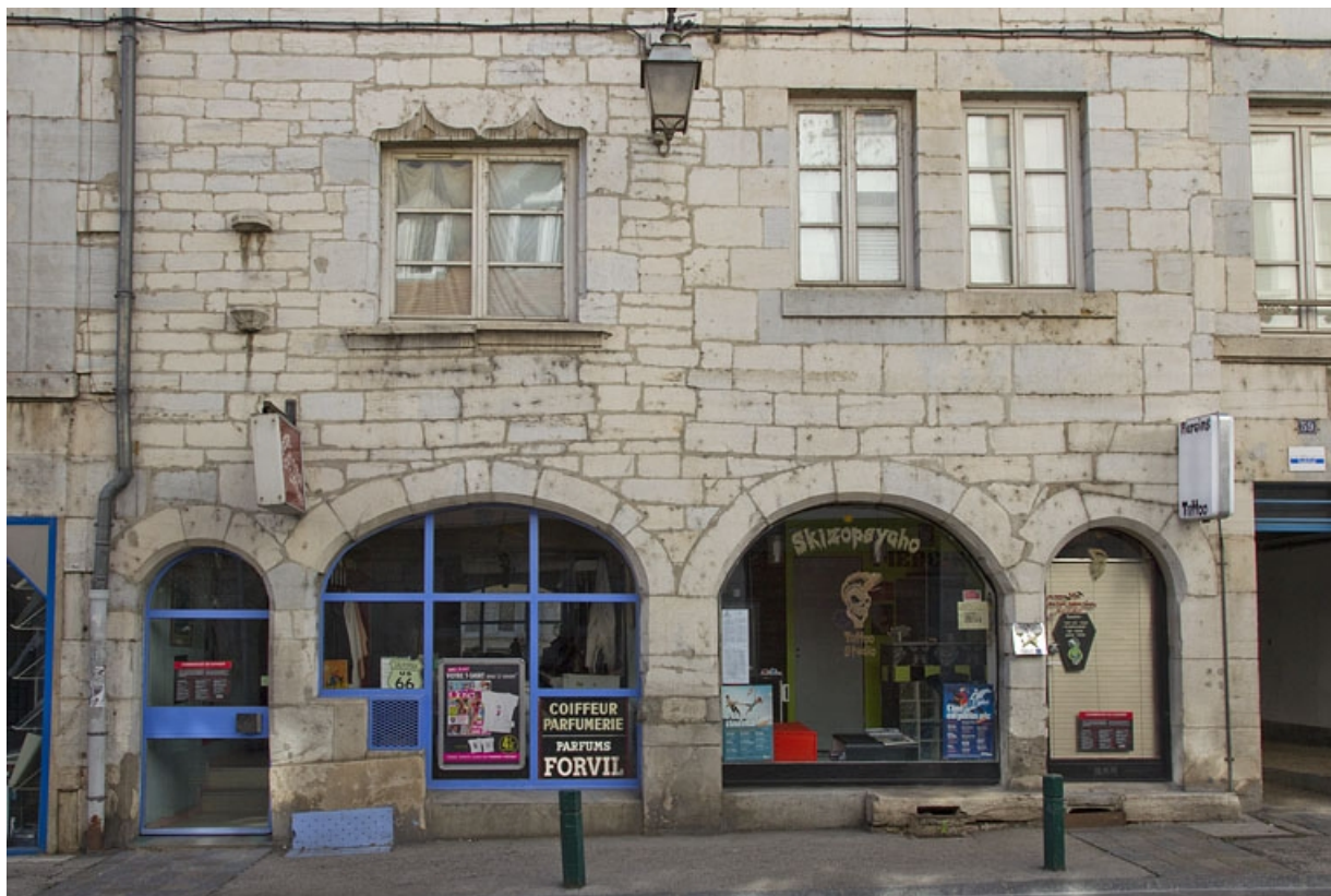
Vue d'ensemble du rez-de-chaussée de deux maisons du XVI e siècle. 25, Besançon
