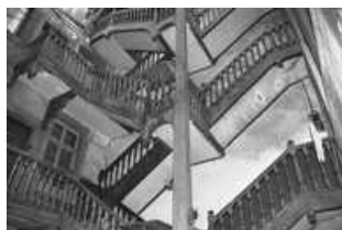
Immeuble : détail de l'escalier sur cour : vue allongée.
