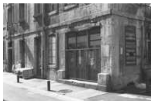
Immeuble : détail de l'angle de l'immeuble entre la rue Courbet et la rue Jean Petit.
