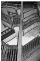
Immeuble : détail de l'escalier sur cour : de face.
