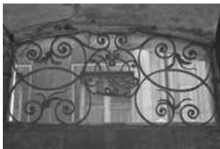
Immeuble : détail de la ferronnerie de l'imposte de la porte d'entrée. 25, Besançon
