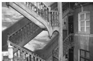
Immeuble : détail du premier étage de l'escalier sur cour.
