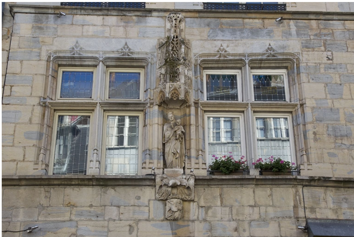
Maison de ville de l'abbaye de la Charité, façade antérieure : détail de la niche. 25, Besançon
