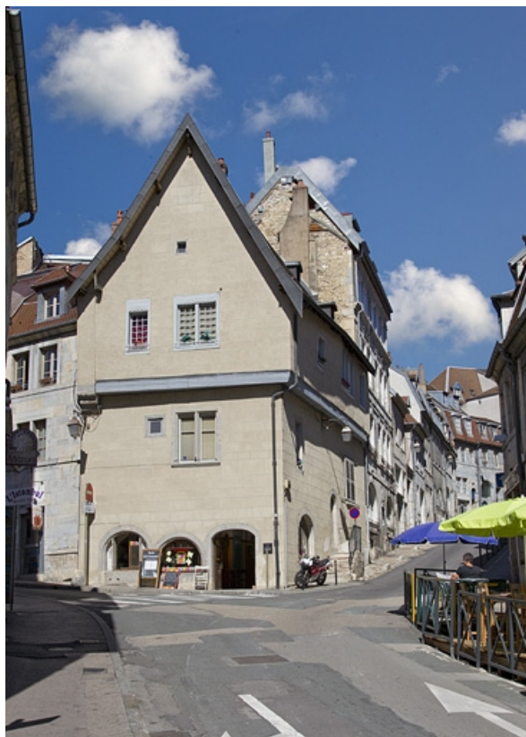
Maison : vue d'ensemble. 25, Besançon
