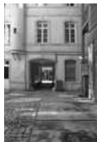
Hôtel et immeuble : façade postérieure du logis principal sur cour : détail partie droite. 25, Besançon
