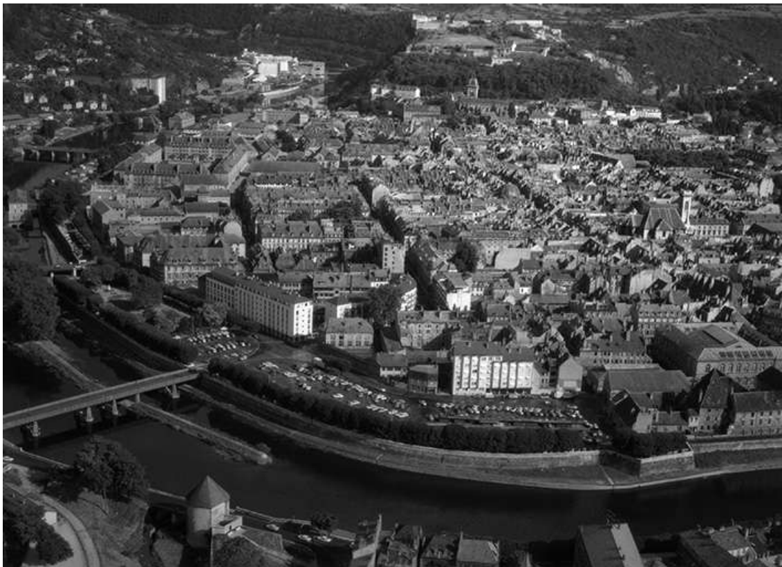
Vue aérienne du centre-ville depuis le quartier Battant en 1964. 25, Besançon
