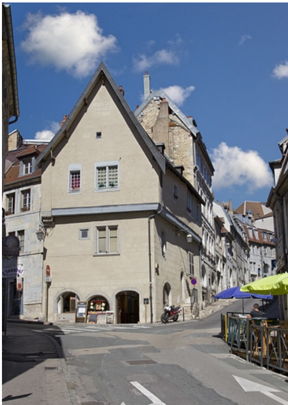
Maison : vue d'ensemble. 25, Besançon
