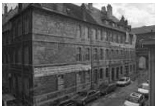
Hôtel et immeuble : logis secondaire donnant place Pâris : vue de l'angle gauche. 25, Besançon
