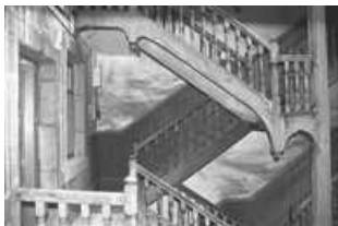
Immeuble : détail du deuxième étage de l'escalier sur cour.
