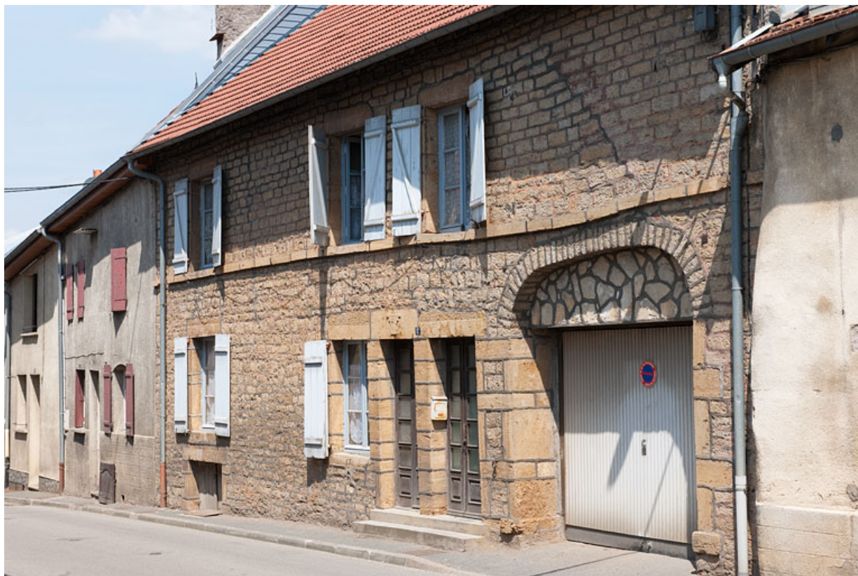
Façade antérieure, vue de trois quart droit. 25, Rougemont, 17 Grande Rue
