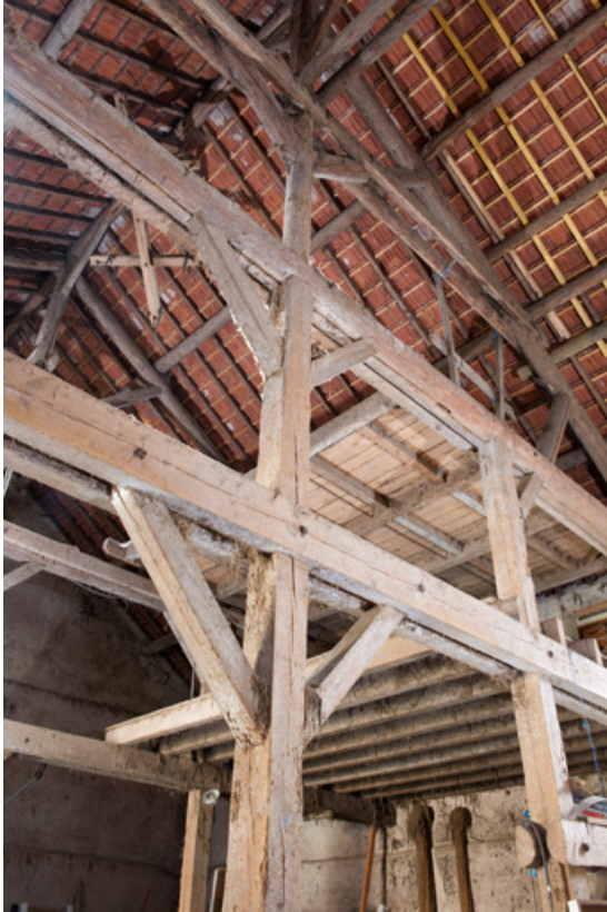
Grange : vue de la charpente.
