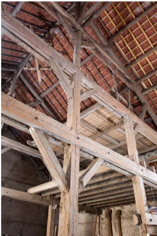
Grange : vue de la charpente.
