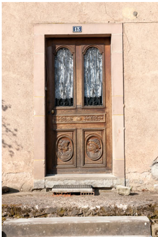
Logis (côté rue) : porte d'entrée.
