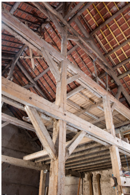
Grange : vue de la charpente.
