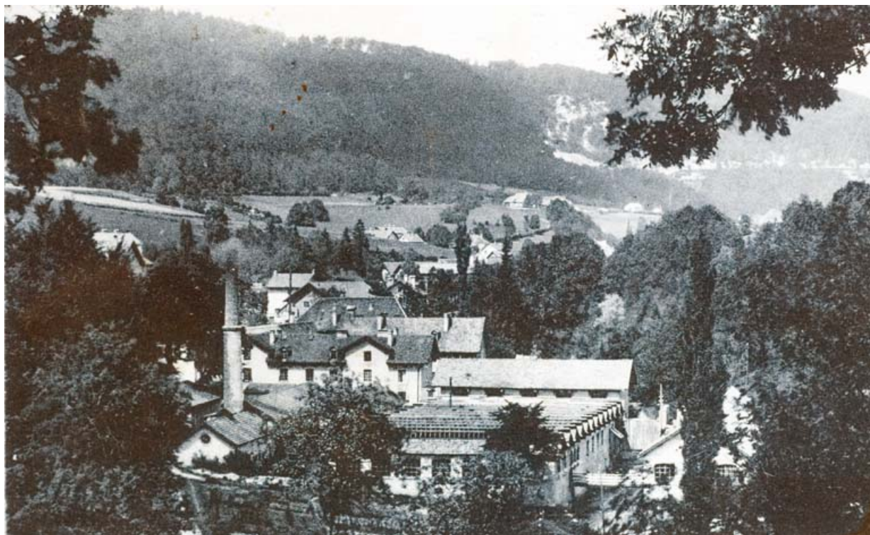
[Vue d'ensemble de l'usine, depuis l'ouest], [milieu 20e siècle].
