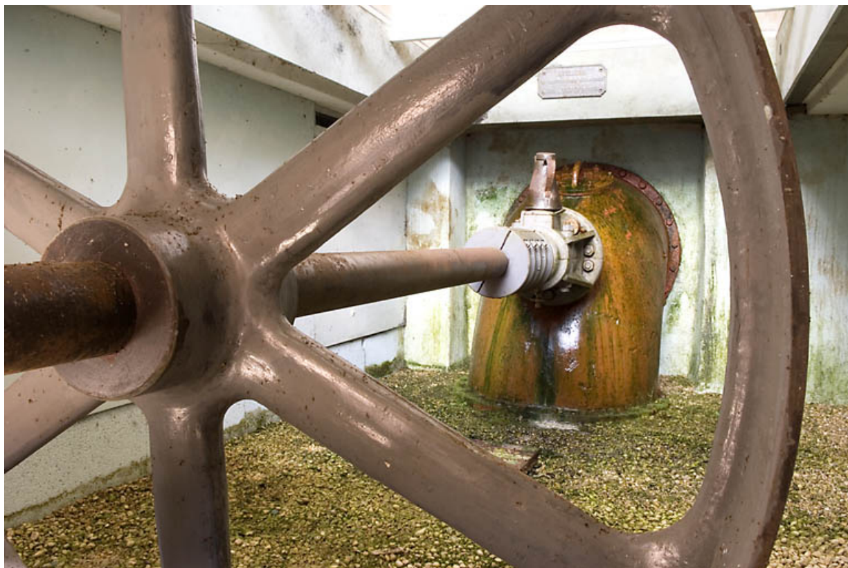
Usine : axe de transmission et volant.
