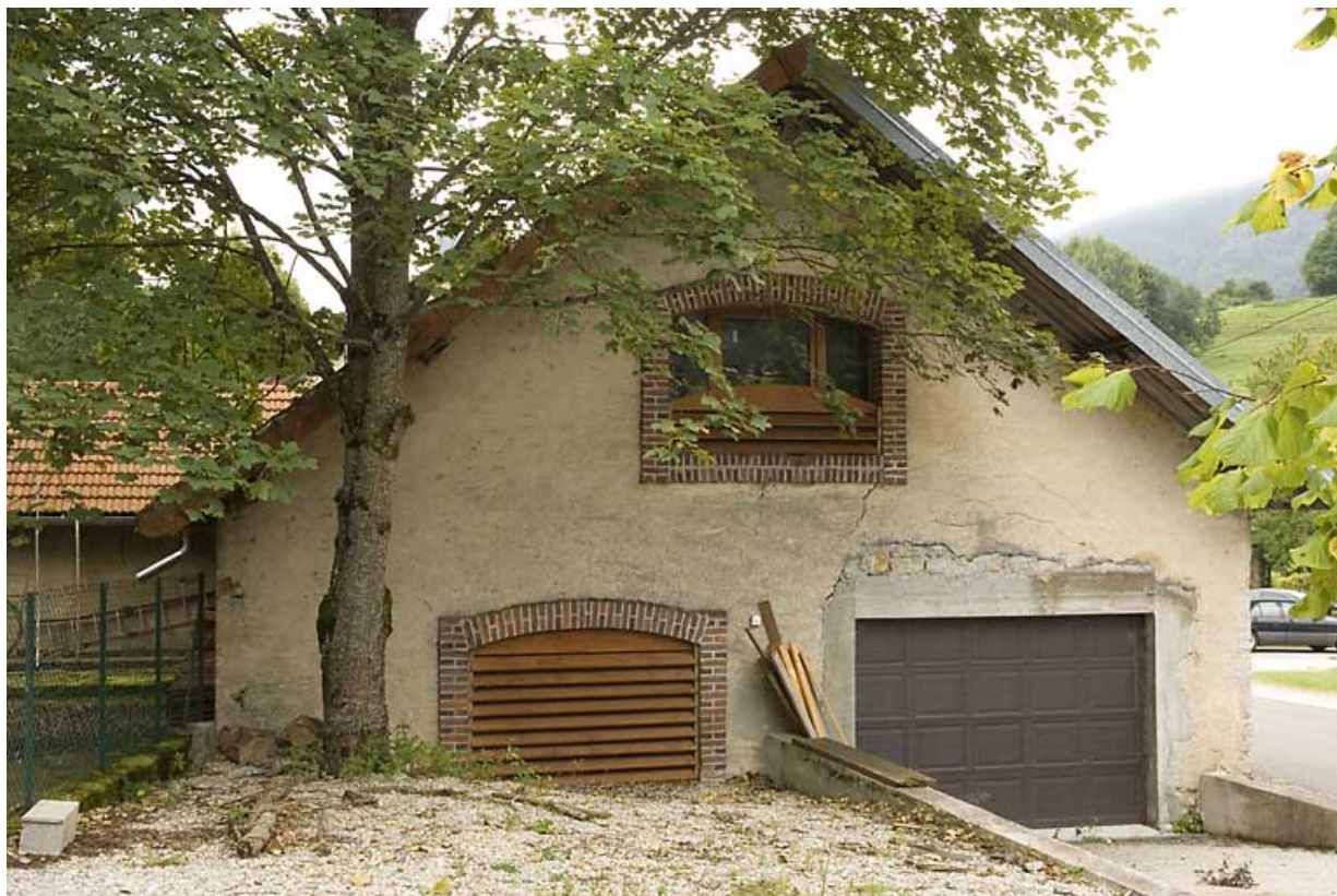
Usine : façade latérale gauche.
