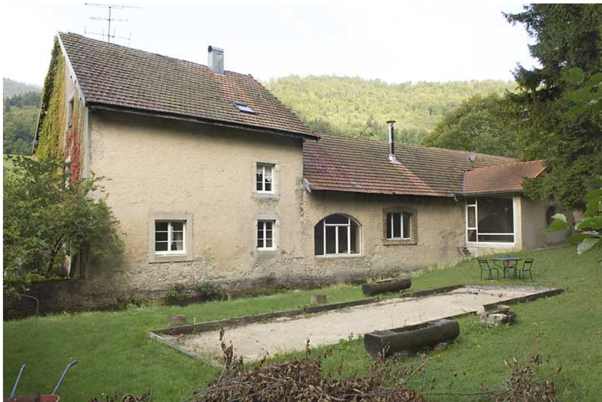
Façade postérieure, de trois quarts gauche. 25, Jougne rue des Forges, lieudit : les Maillots
