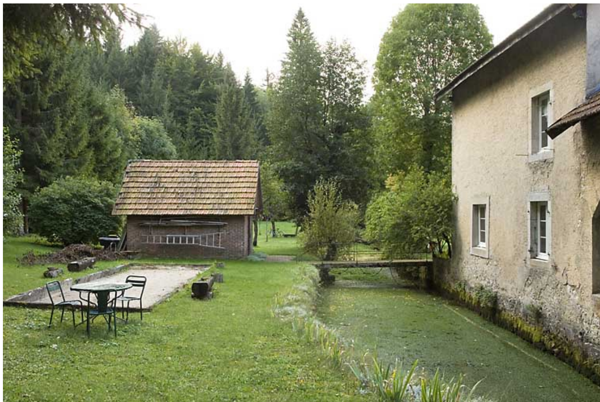
Canal de fuite, depuis l'amont, entre remise (à gauche) et maison (à droite).
