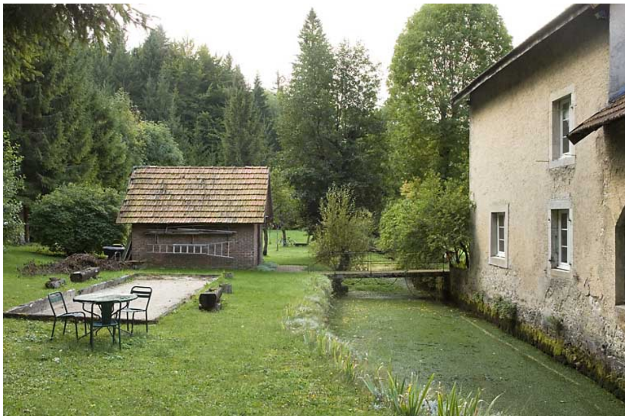
Canal de fuite, depuis l'amont, entre remise (à gauche) et maison (à droite). 25, Jougne rue des Forges, lieudit : les Maillots
