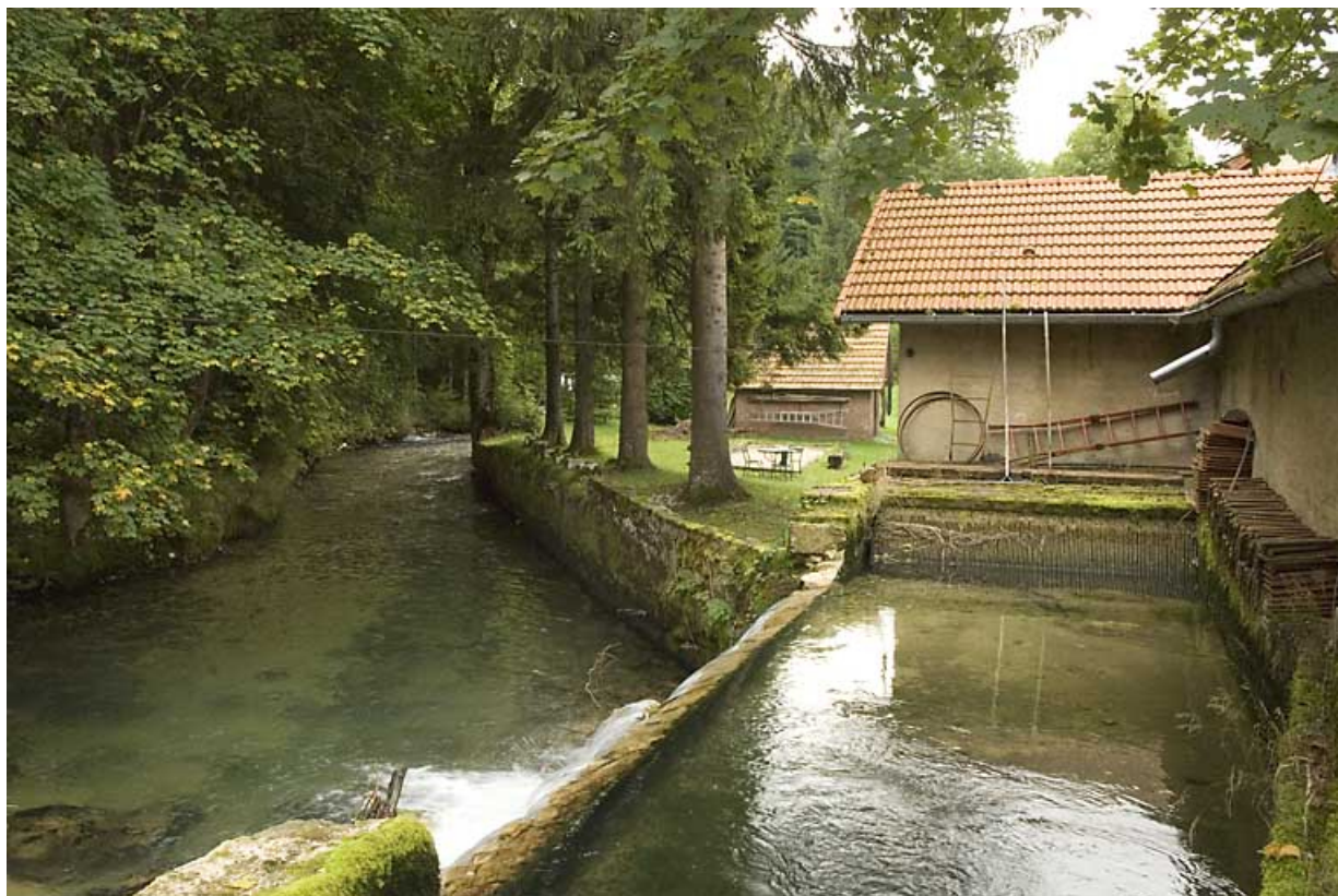
Canal d'aménée (avec déversoir à gauche) et bâtiment d'eau.
