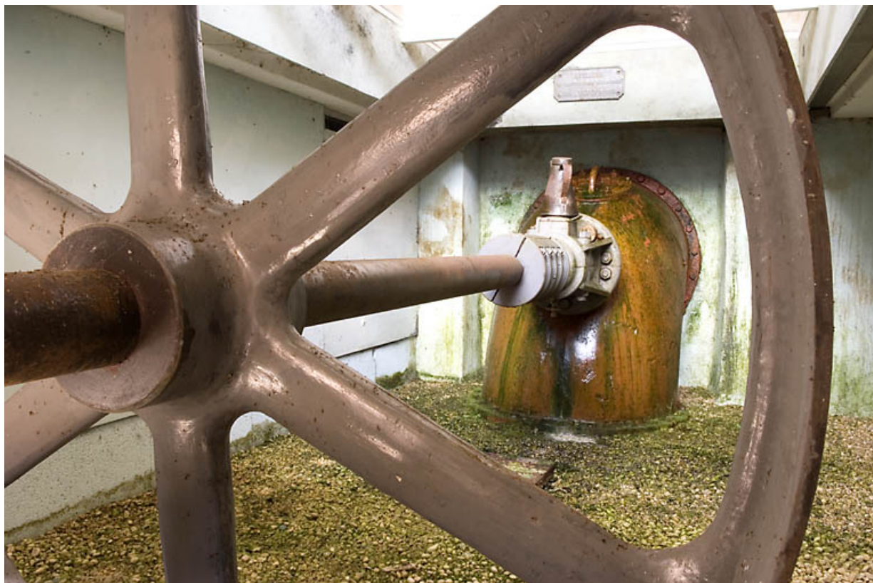
Usine : axe de transmission et volant.
