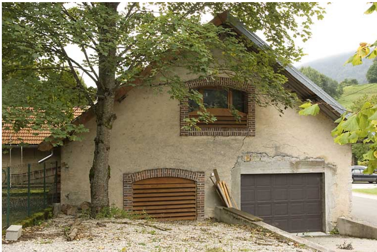
Usine : façade latérale gauche.
