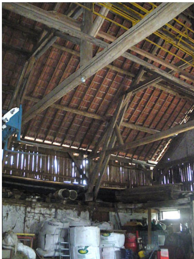
Remise agricole : charpente.
