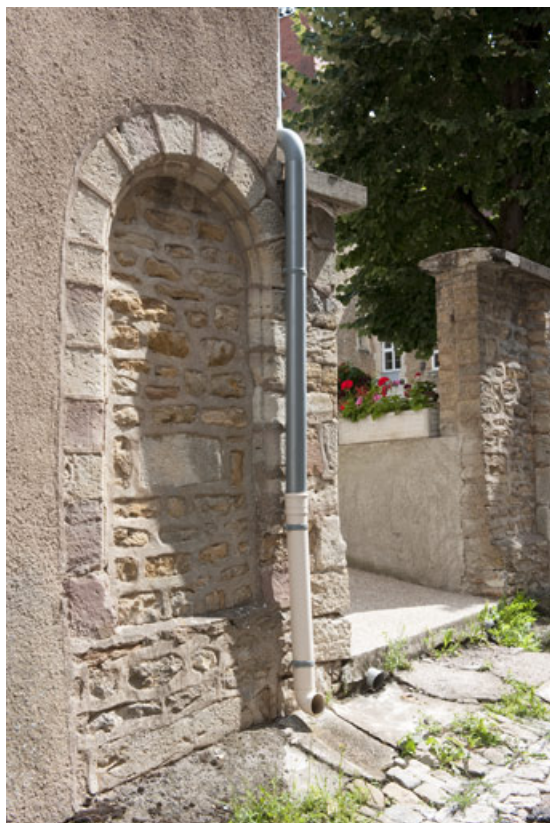
Bâtiment (B), ancienne porte.
