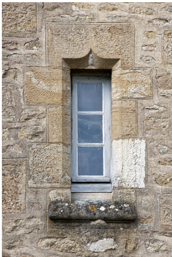
Bâtiment (C), façade côté jardin : détail d'une baie de la tour d'escalier. 25, Rougemont quartier de la Citadelle
