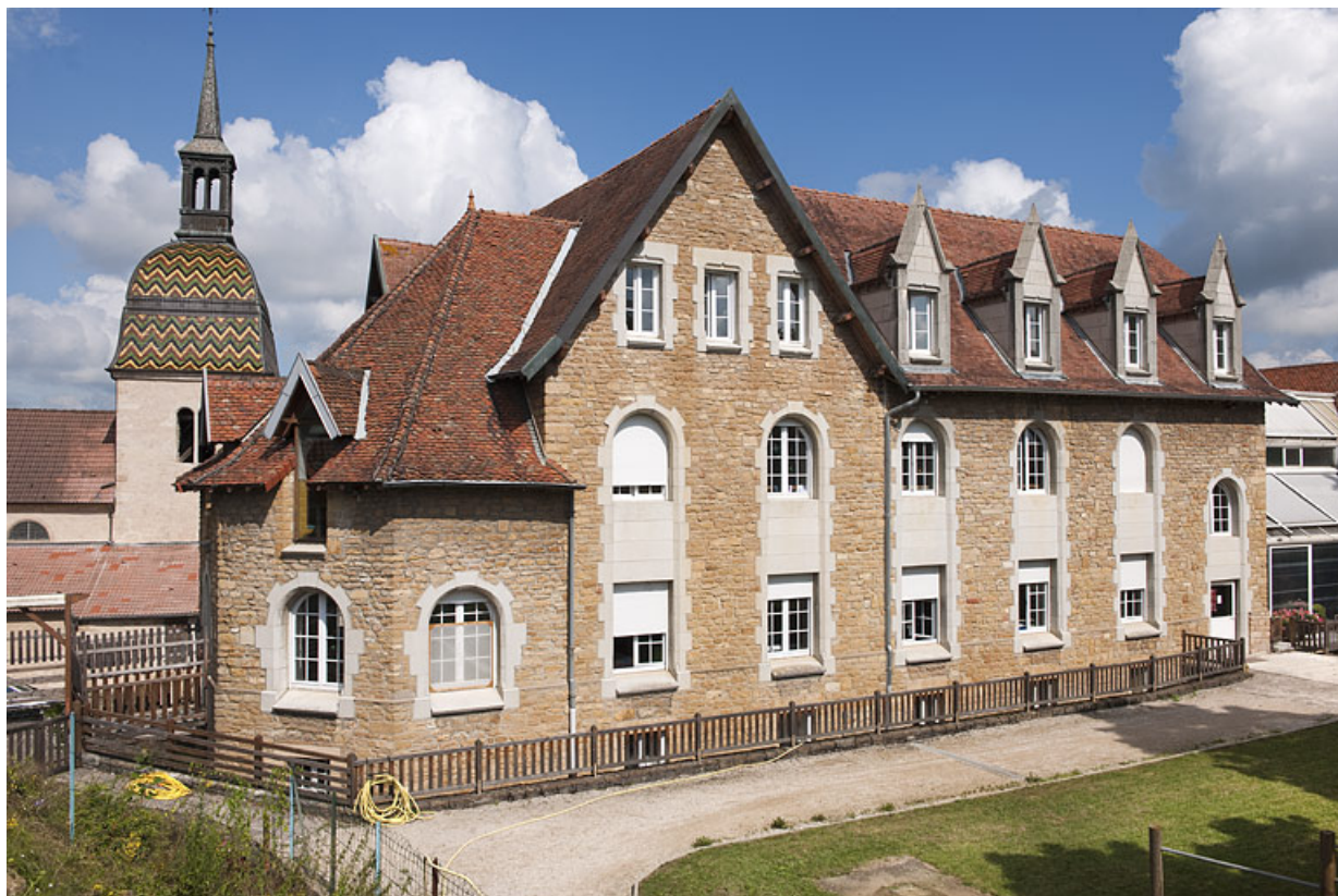
Bâtiment (G), façade postérieure, vue de trois quart gauche. 25, Rougemont quartier de la Citadelle
