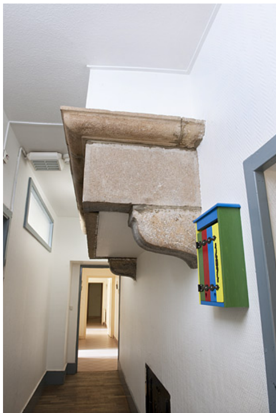
Hôtel de Choiseul : cheminée de l'ancienne cuisine. 25, Rougemont, 6, 8 rue Basse
