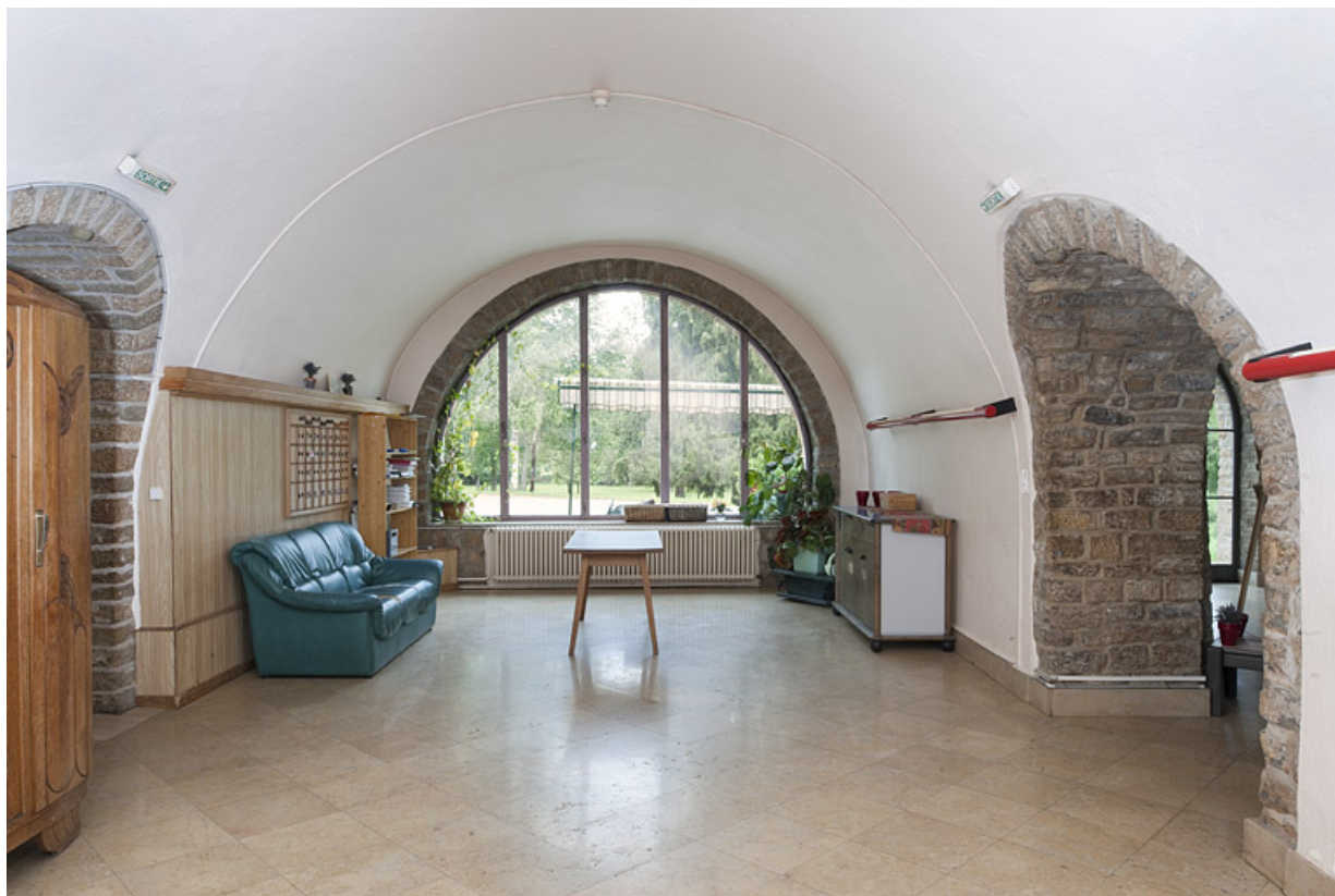
Hôtel de Choiseul : ancienne cave voûtée en berceau, vue en direction de la rue des Fossés. 25, Rougemont, 6, 8 rue Basse
