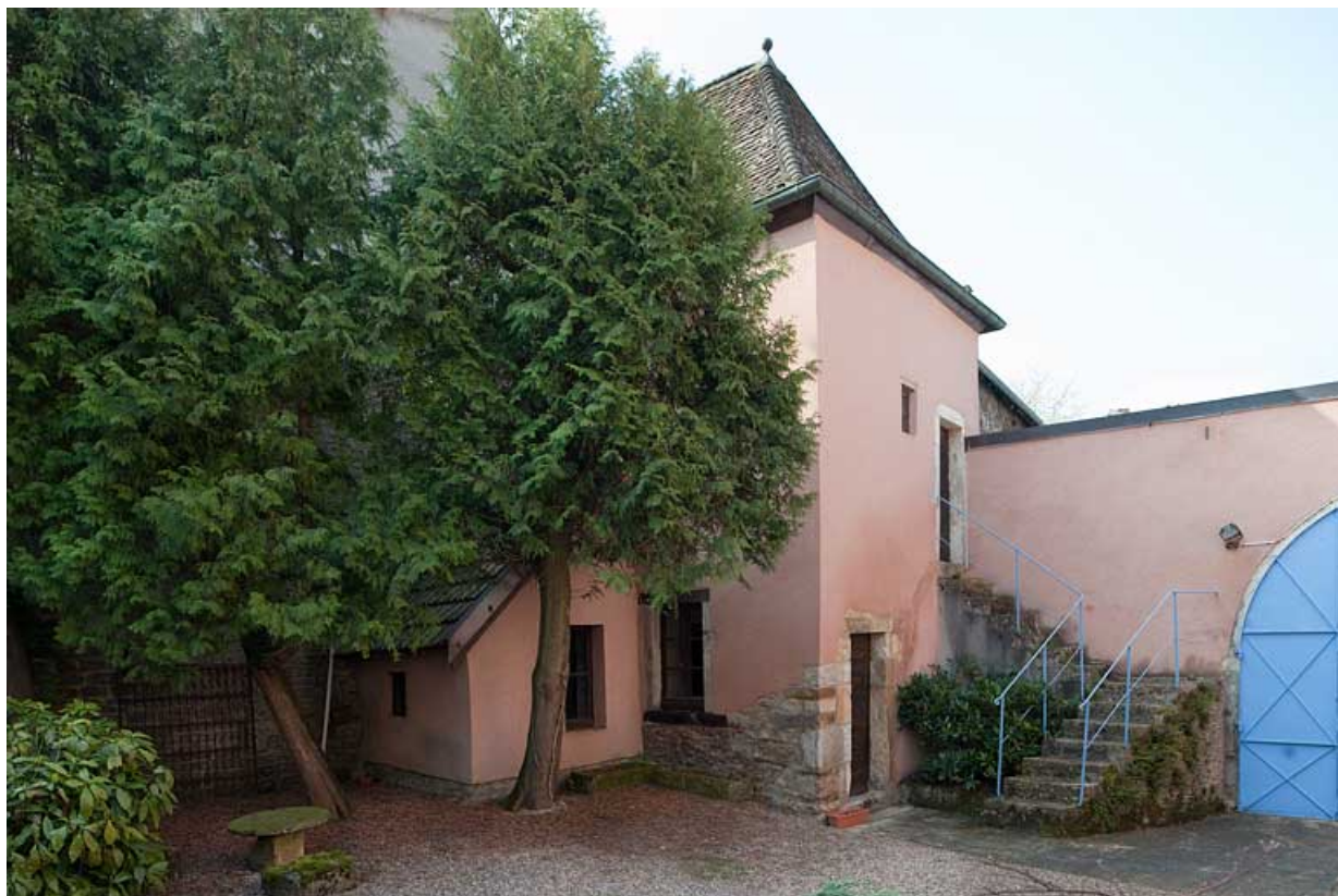
Vue générale du pavillon situé à droite de l'entrée.
