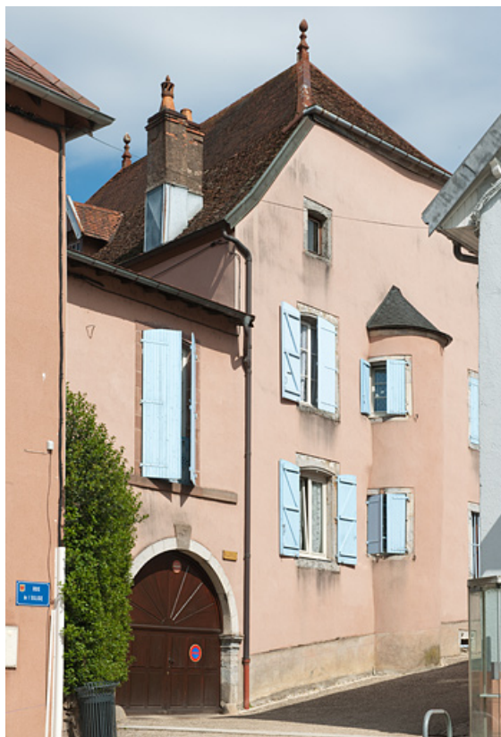
Façade antérieure, rue de l'Eglise.
