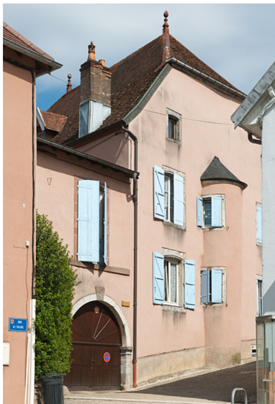
Façade antérieure, rue de l'Eglise.
