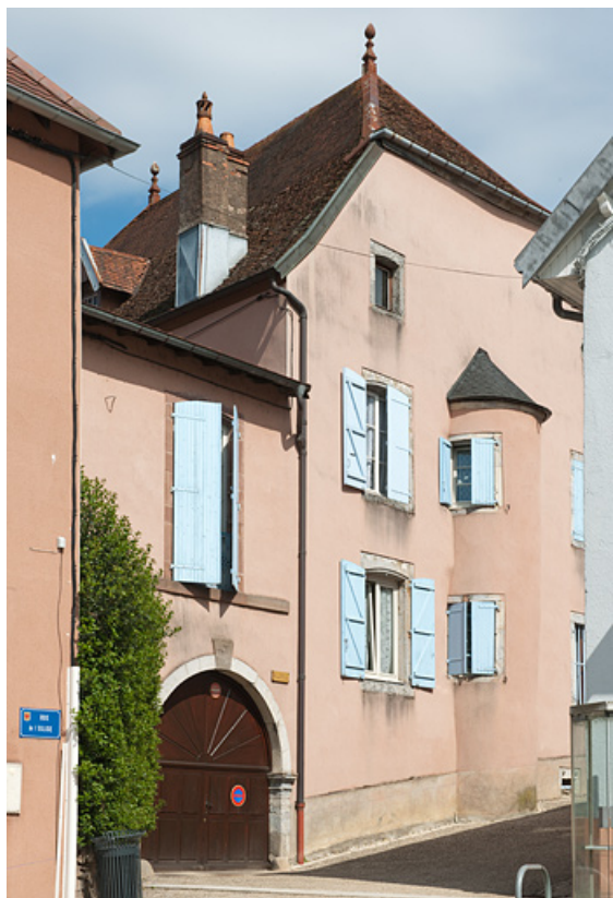
Façade antérieure, rue de l'Eglise.
