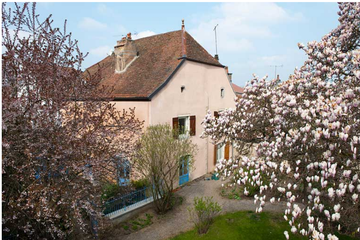
Façade postérieure de trois quart gauche.
