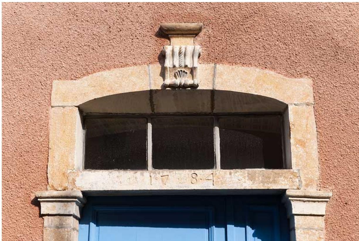
Détail : linteau de la porte d'entrée du logis.
