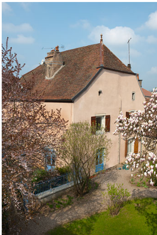
Façade postérieure, côté jardin.
