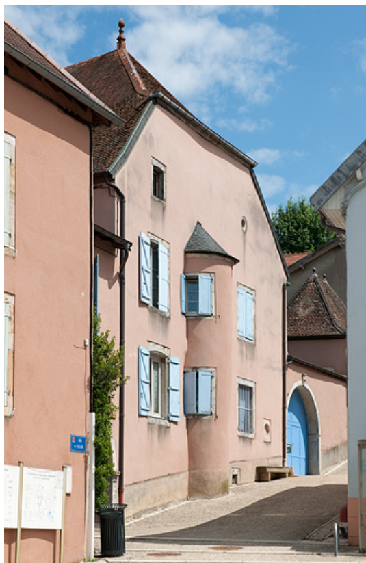
Vue générale de la façade, rue de l'Eglise. 25, Rougemont, 1 rue de l' Eglise
