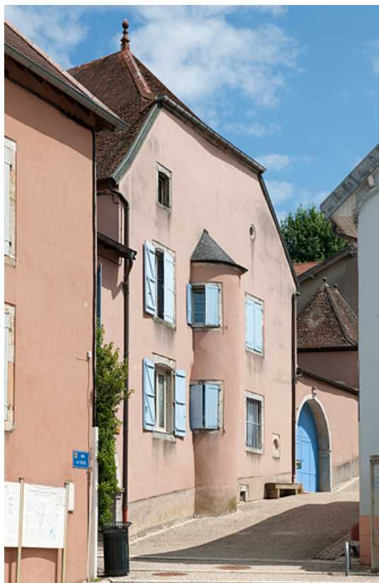
Vue générale de la façade, rue de l'Eglise.
