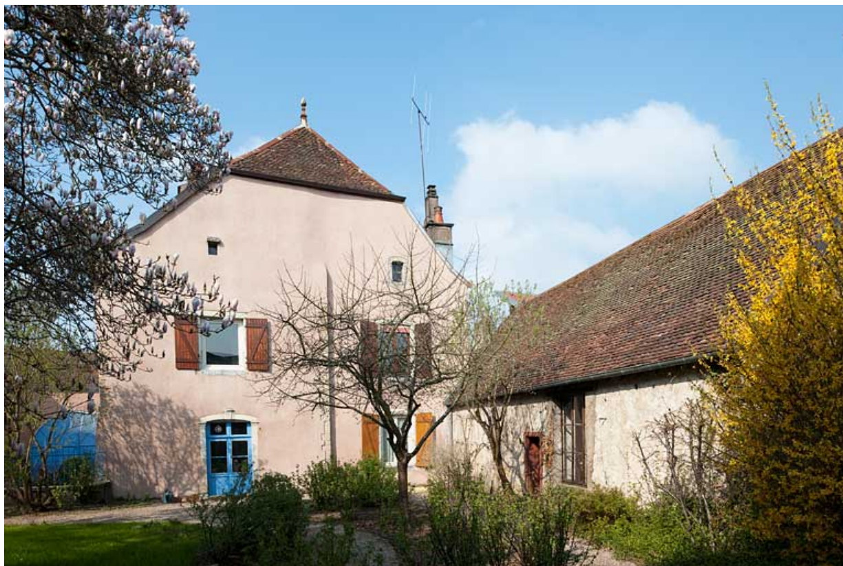
Vue d'ensemble du logis et des communs, côté jardin.
