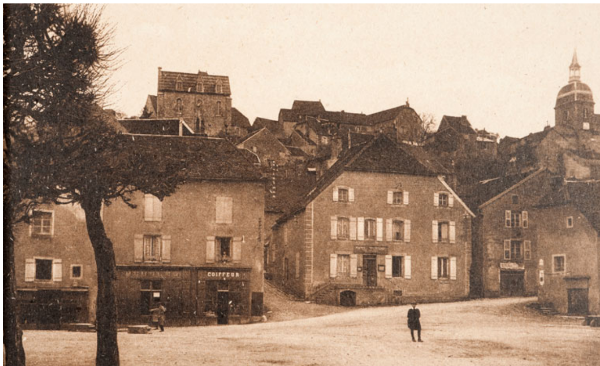
7-ROUGEMONT (Doubs)-Bureau de Poste.
