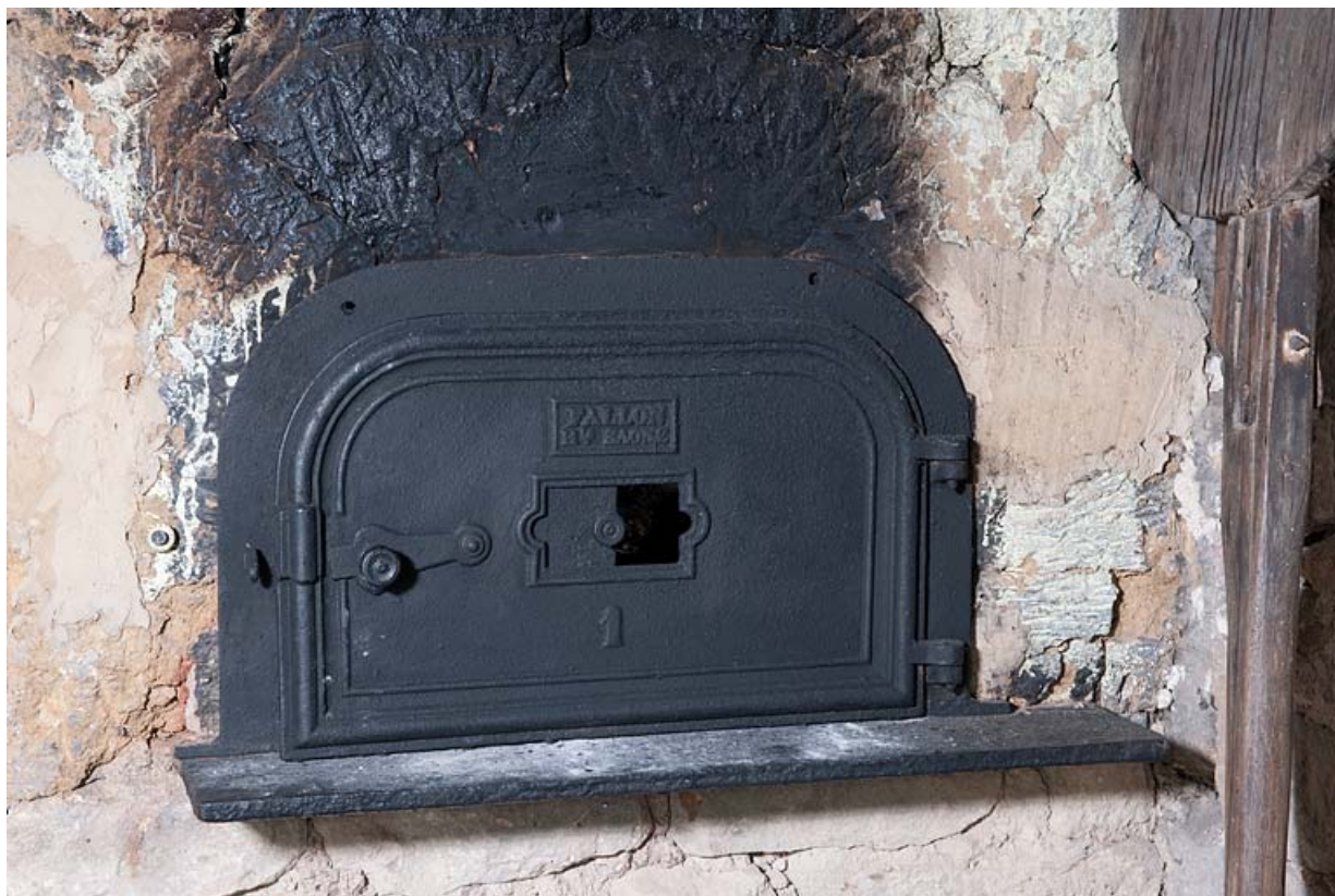
Cuisine : porte du four, portant la mention de la fonderie de Fallon.
