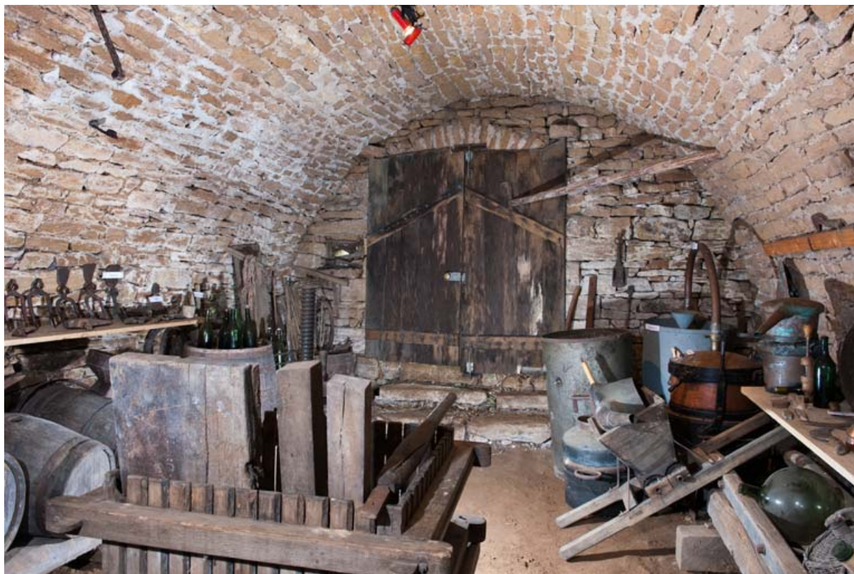
Vue générale de la cave depuis l'entrée.
