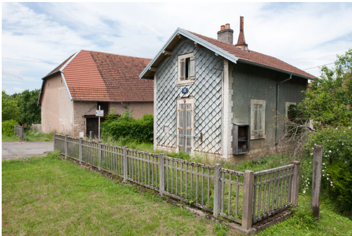
Maison de garde-barrière (cadastrée AK 125), rue du Pont. 25, Rougemont avenue de la Gare
