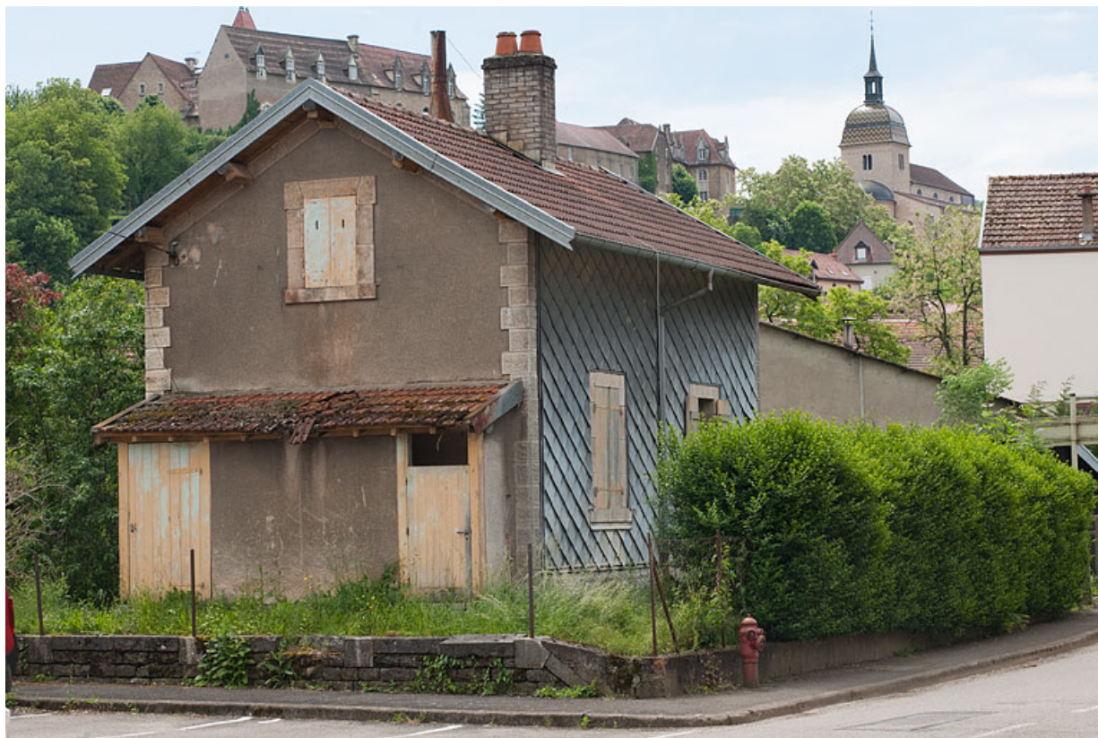
Maison de garde-barrière, rue du Pont : vue rapprochée, depuis le carrefour. 25, Rougemont avenue de la Gare
