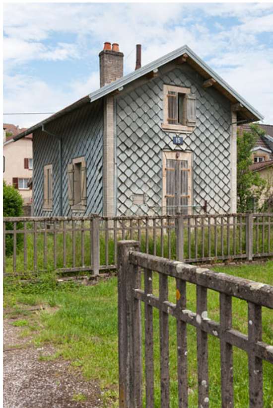
Maison de garde-barrière, rue du Pont : vue rapprochée. 25, Rougemont avenue de la Gare
