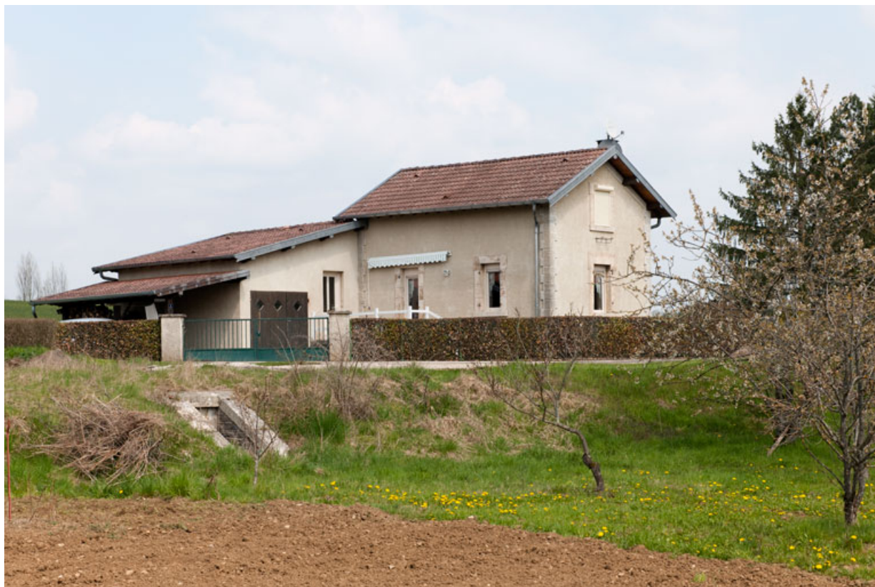
Maison de garde-barrière (cadastrée AI 59), chemin du Souvenir français. 25, Rougemont avenue de la Gare
