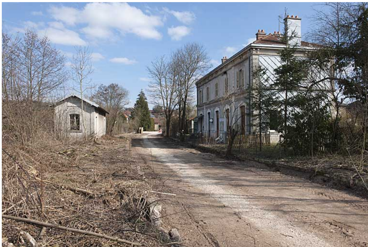
Bâtiment des voyageurs et abri. 25, Rougemont avenue de la Gare
