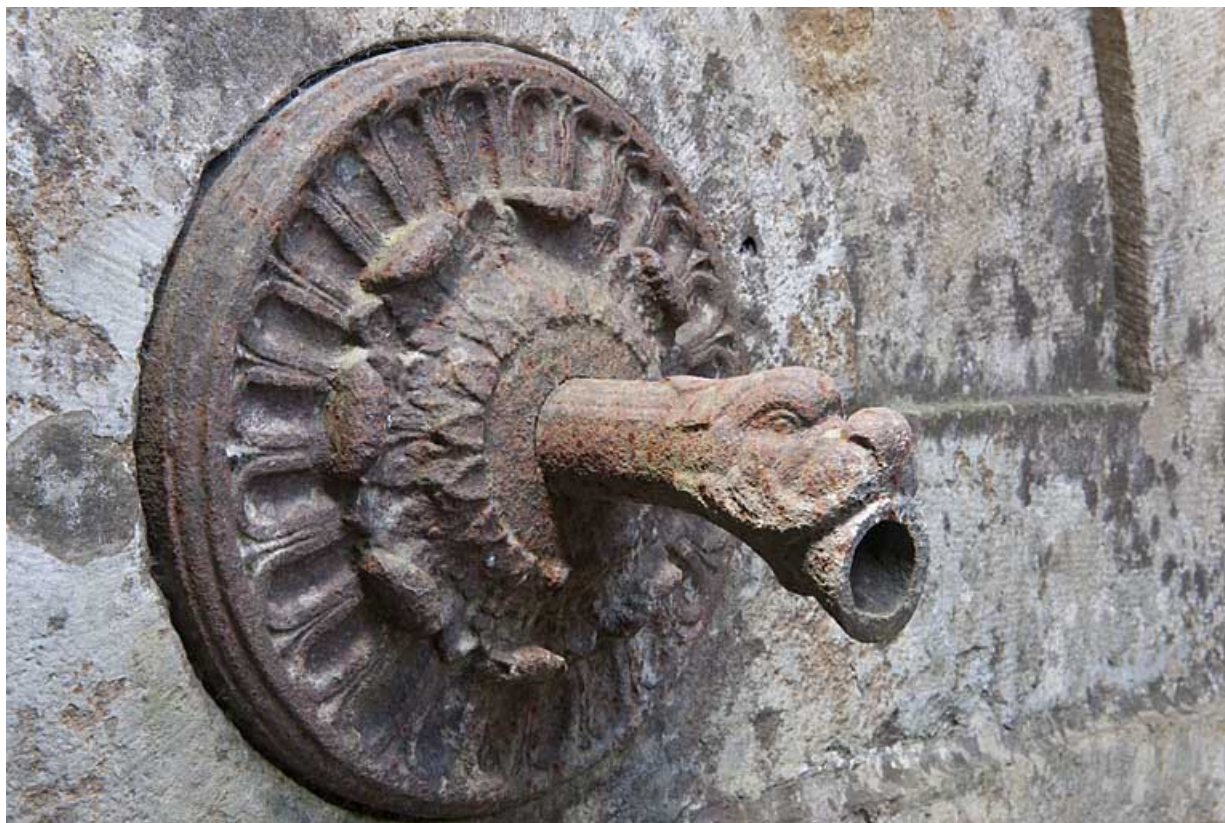
Vue d'une gueule de dragon ornant une pile de jet. 25, Rougemont rue du Lavoir
