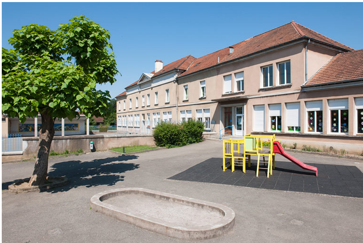
Vue de trois quart droit de la façade antérieure depuis la cour de récréation. 25, Rougemont rue Léon Belz
